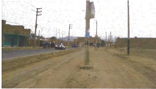
Figura 4.9.- Vista de red de postes de electricidad que se presentan como interferencias
