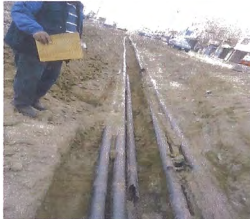
Figura 4.13.- Vista de red subterránea de servicios públicos que se presentan como interferencias
