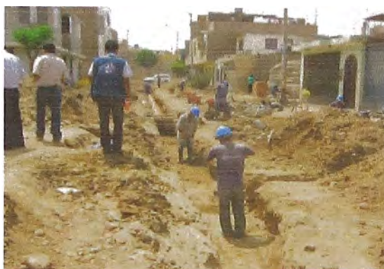
Figura 4.7.- Vista de ejecución de trabajos sobre Interferencias Sanitarias
