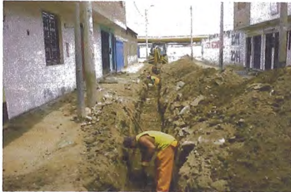
Figura 4.5.- Vista de ejecución de trabajos sobre Interferencias Sanitarias
