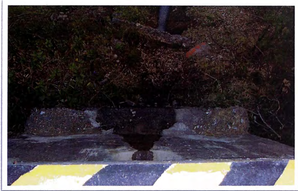
Figura 5.- Muro de contención existente (vista en planta) (Fuente: GCZ Ingenieros S.A.C., AGO 2006)
