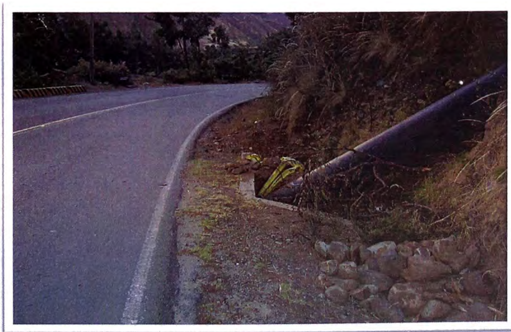
Figura 2.- Tubería forzada existente cruzando la carretera Lima Huaraz (vista transversal) (Fuente: GCZ Ingenieros S.A.C., AGO 2006)
