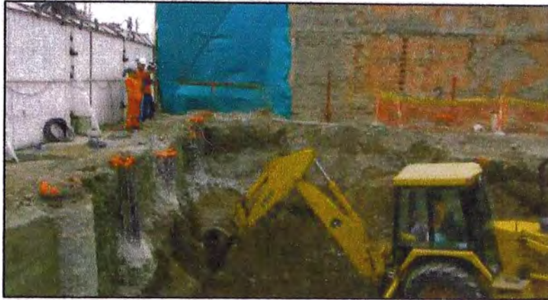
Figura 54: Excavación de área de sub estación definitiva
