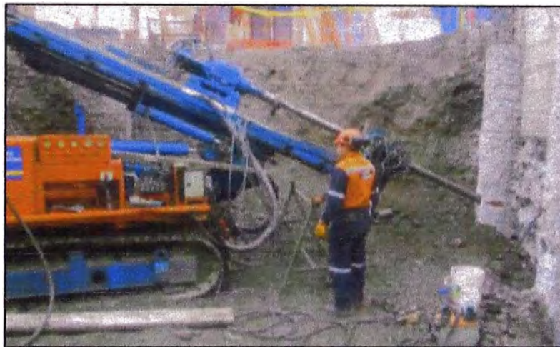
Figura 55: Inyección de anclajes de pilotes contraterreno
