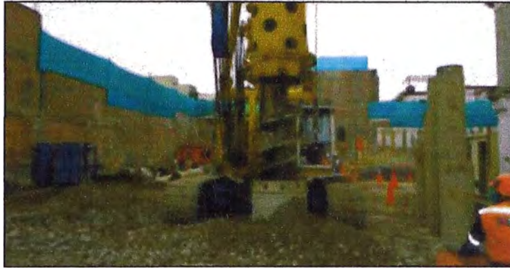
Figura 47: Perforación de pilotes tipo columna de D=1000 mm
