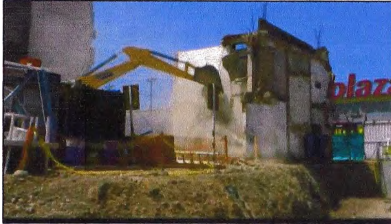
Figura 61: Demolición de sub estación N° 41
