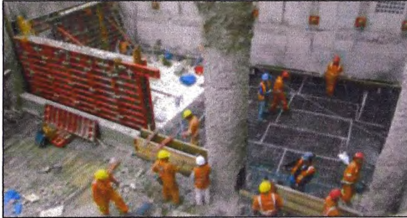
Figura 57: Losa, vigas y placas de concreto para Sub estación definitiva
