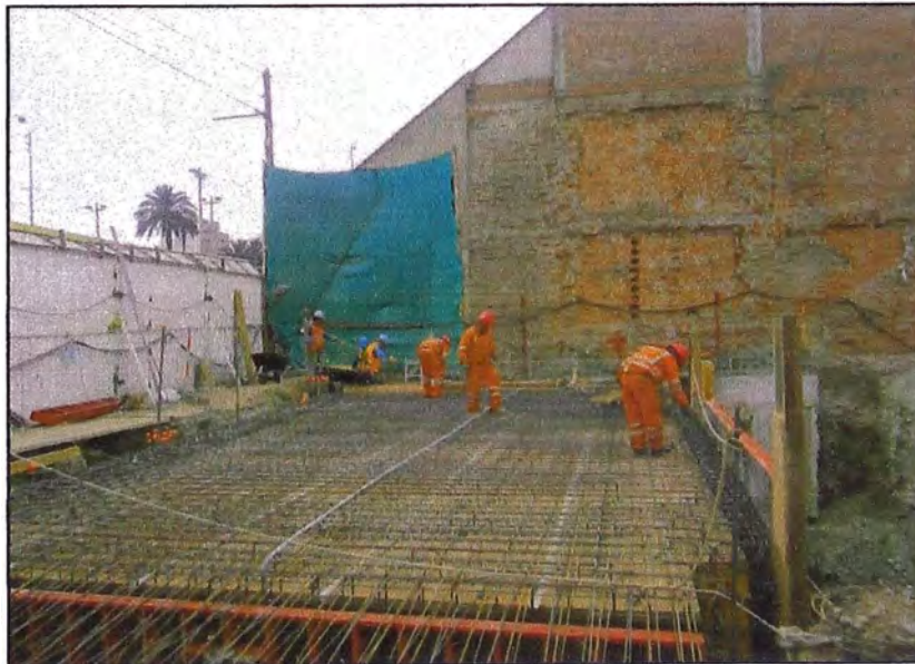
Figura 58: Ejecución de losa y vigas de techo
