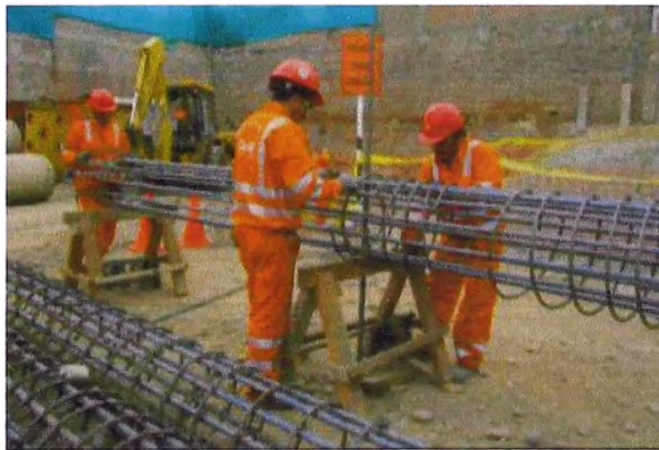
Figura 48: Pre armado de acero de refuerzo para pilotes
