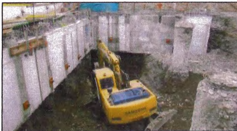
Figura 56: Excavación en segundo anillo
