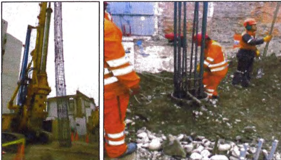
Figura 49: Izaje de acero para pilote y colocación de empalmes
