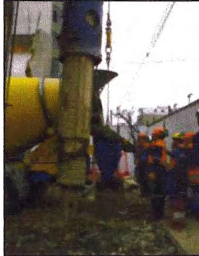
Figura 50: Vaciado de concreto en el embudo del tubo "tremie"
