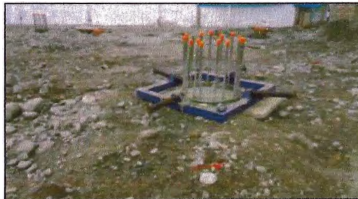
Figura 53: Pilotes ejecutados y señalizados
