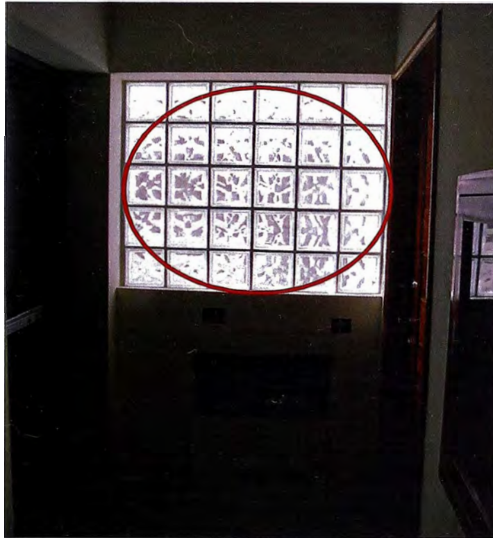
Figura N° 10: Regulación de segunda etapa sin ventilación.
