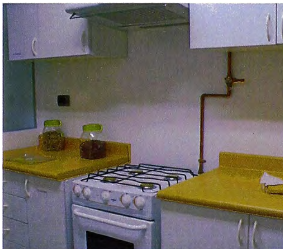
Figura N° 03: Tubería de PEALPE a la vista.
