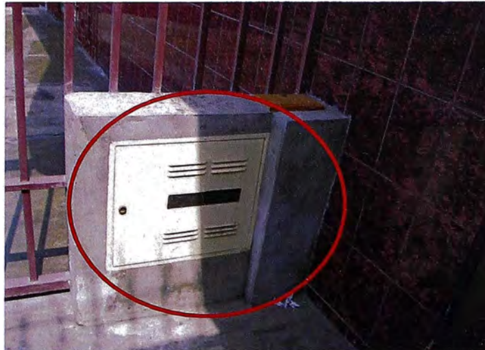
Figura N° 15: Murete para colocar gabinete.
