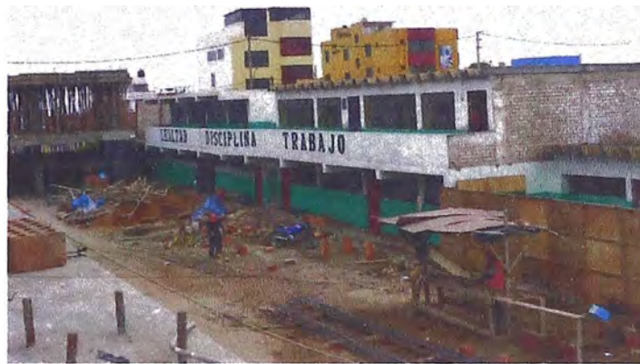
Figura 1.03 Edificación en construcción Fuente: Constructora AGALOBRAS SAC
