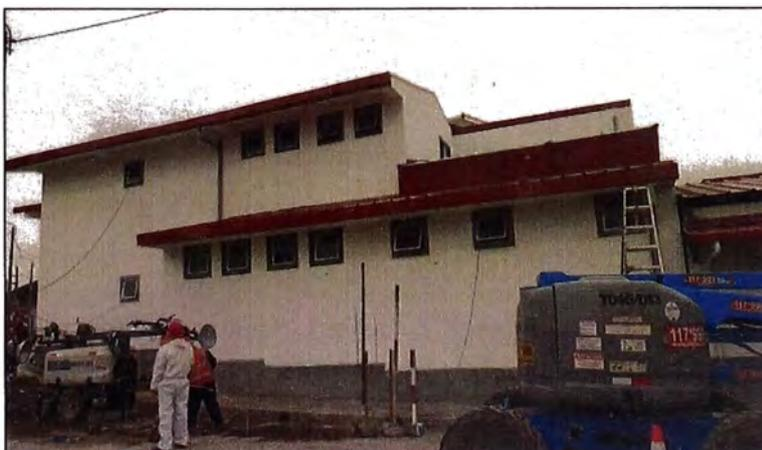
**Figura N°1.13. – Pintura en exteriores y montaje de cobertura de techos, colocación de puertas y ventanas.**
