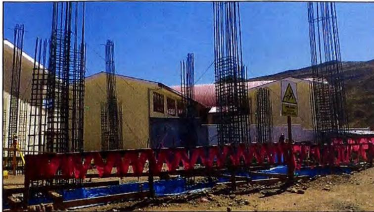
**Figura N°1.8. – Excavación para cimentación y colocación de acero en SUM**
