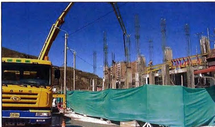
**Figura N°1.10. – Concreto en columnas de segundo nivel**
