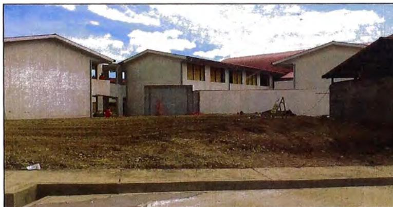
**Figura N°1.7. – Nivelación y compactación de suelo de fundación**
