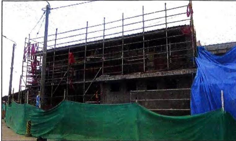
**Figura N°1.11. – Concreto en aligerado del segundo nivel y tarrajeo de muros exteriores**
