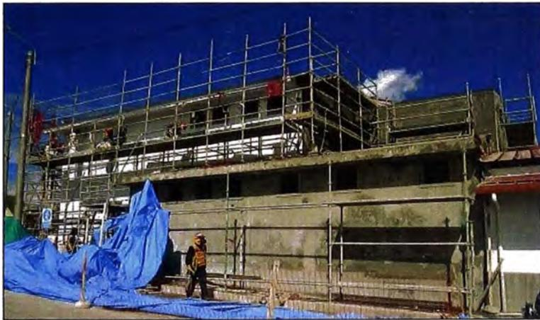
**Figura N°1.12. – Tarrajeo de interiores y exteriores, pintura en exteriores, montaje de estructura metálica**
