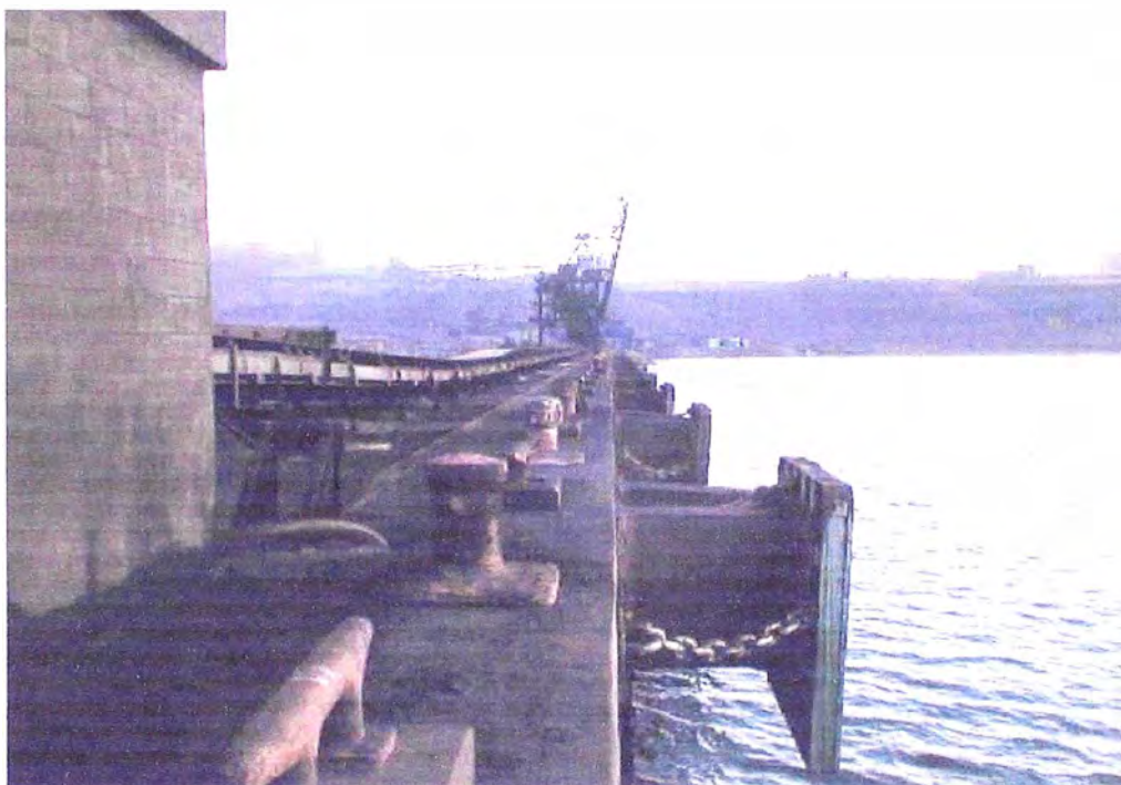
Figura 5: Protección del muelle contra choque de buques
