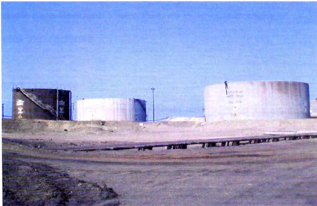
Figura 7: Tanques de Combustible
