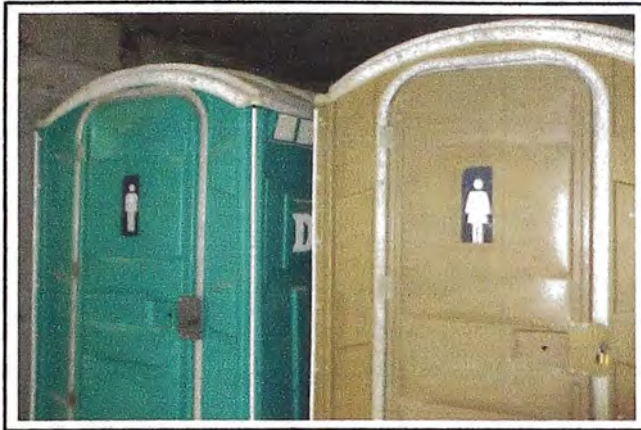
Figura N° 25: Servicios Higiénicos portátiles de la obra
