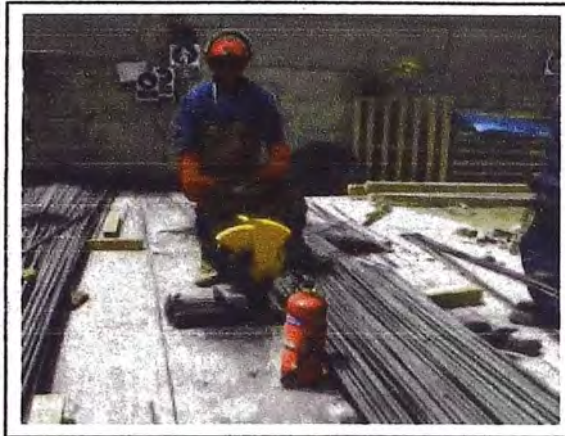
Figura N° 30: Personal realizando trabajos en caliente
