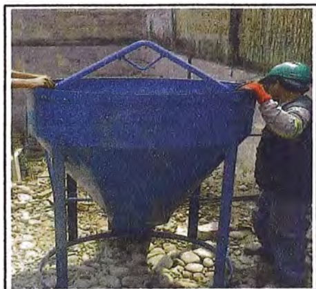
Figura N° 2.6: Recipiente utilizada para vaciar concreto utilizando grúa
