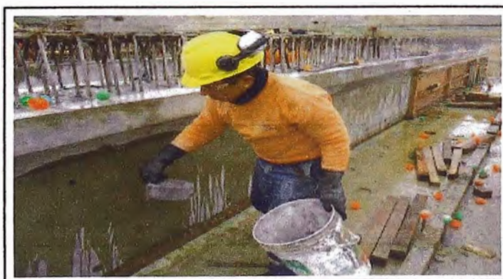
Figura N° 5: Desencofrado y curado de vigas prefabricadas en taller.
