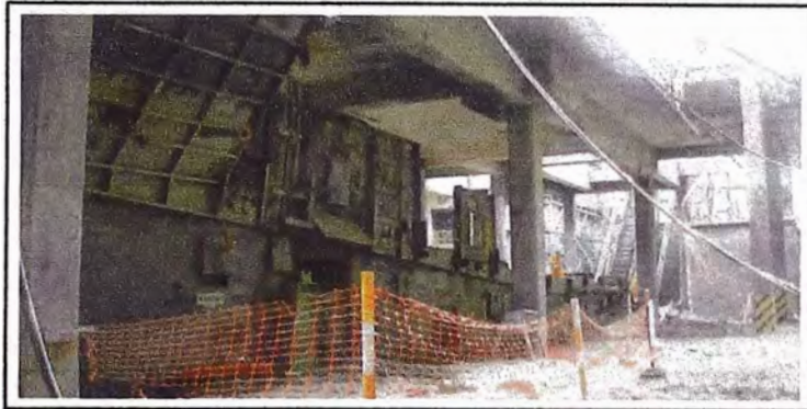
Figura N° 1.1: Estructura existe a demoler
