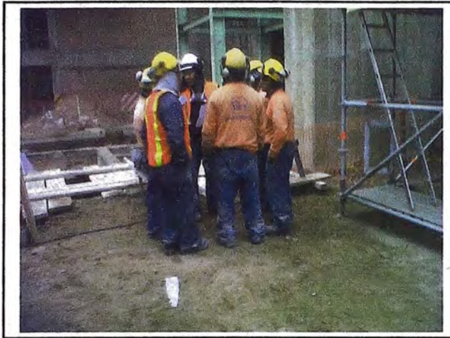
Figura N° 13: Obreros recibiendo Re- Inducción, producto de no conformidad
