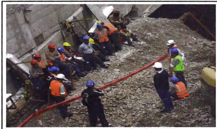
Figura N° 22: Charla de SST, previo a las labores diarias
