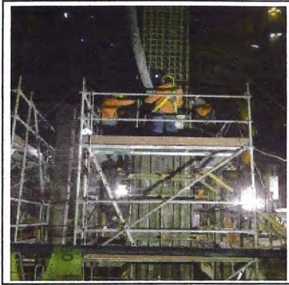
Figura N° 15: Vaciado de concreto de columna (Parte inferior)
