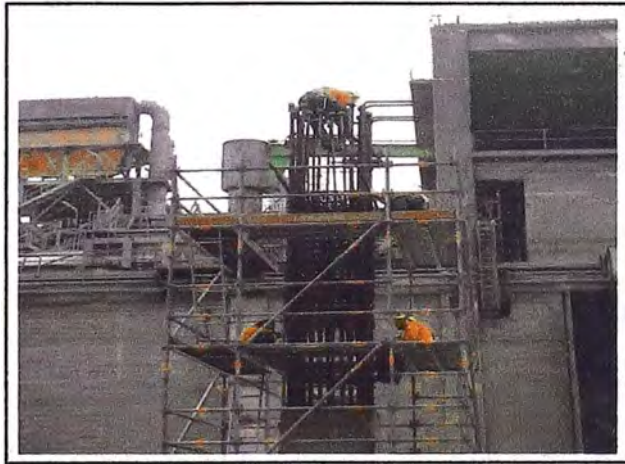
Figura N° 1.4: Parte de una columna de concreto armado
