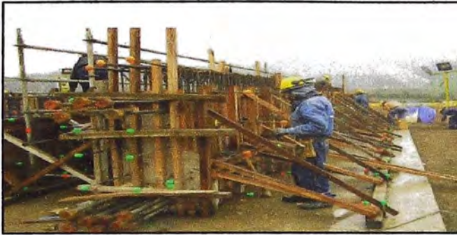
Figura N° 16: Encofrado de Vigas prefabricadas en taller
