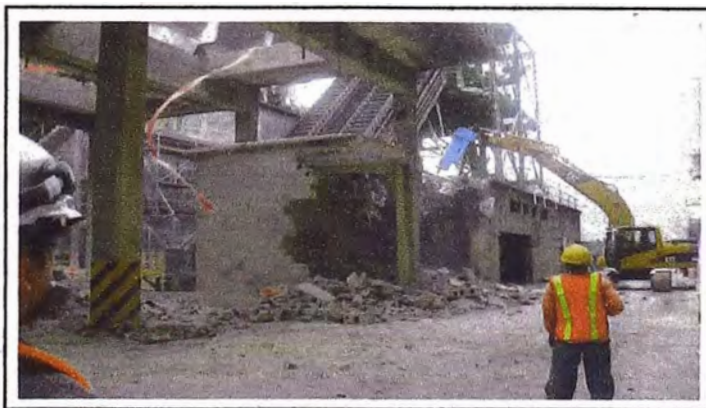
Figura N° 1.2: Demolición de estructura existente
