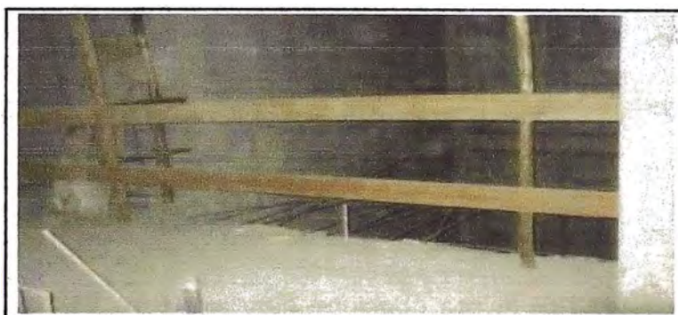
Figura N° 29: Barandas de madera ubicadas en ducto de ascensores
