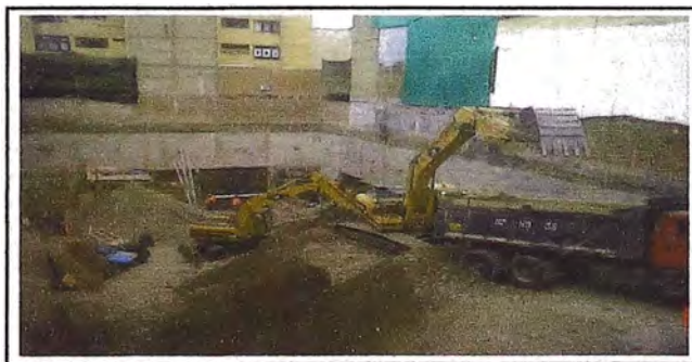
Figura N° 2.2: Cargado de materiales excavados
