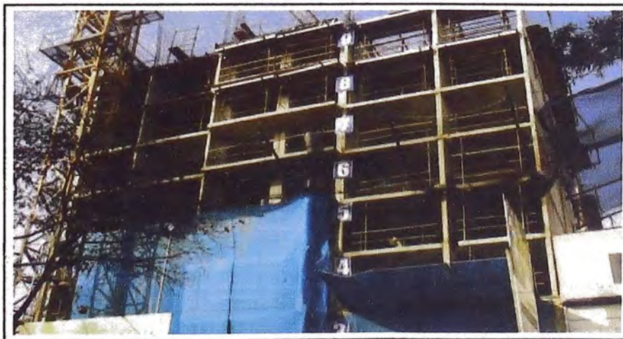
Figura N° 8: Vista de la fachada frontal de obra
