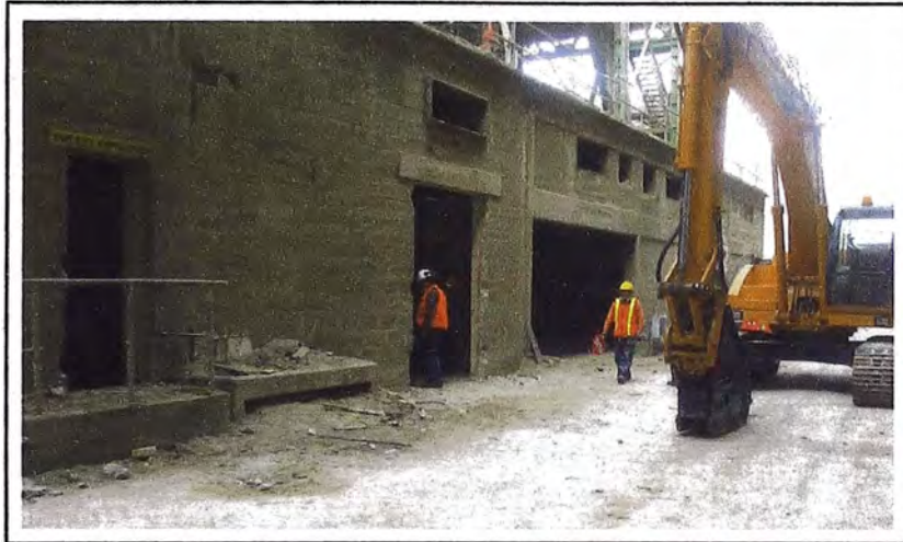
Figura N 11: Traslado de excavadora de demolición
