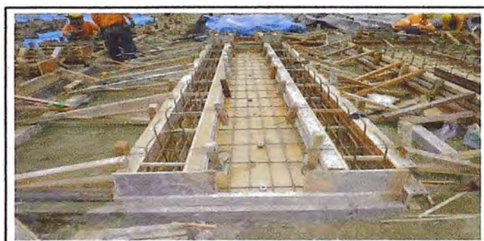
Figura N° 1.6: Encofrado de losas prefabricadas en taller
