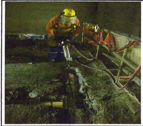
Figura N° 1.3: Demolición en techo de estructura existente
