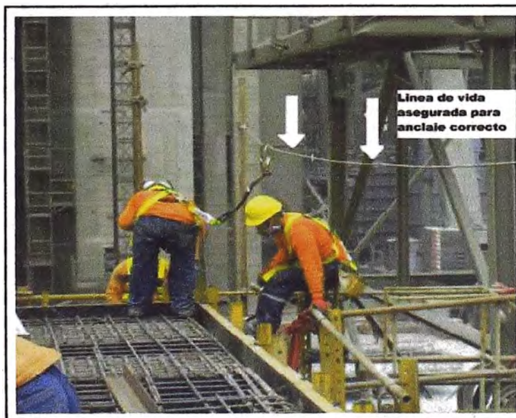
Figura N° 20: Enmallado de losas en techo
