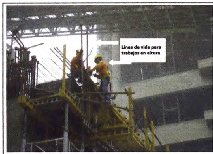
Figura N° 19: Trabajos en altura (Techo)
