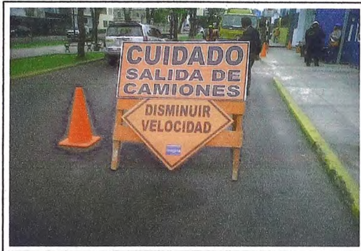
Figura N° 23: Señal que advierte la salida de camiones de obra
