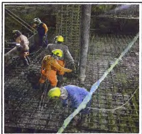
Figura N° 1.5: Vaciado de concreto en platea de cimentación
