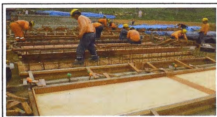
Figura N° 1.7: Encofrado de losas prefabricadas en taller
