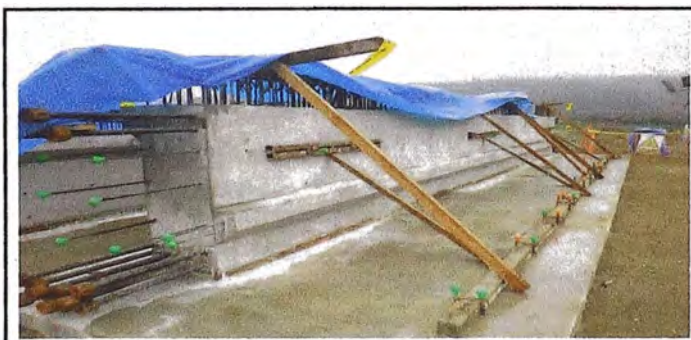
Figura N° 17: Viga prefabricada en taller
