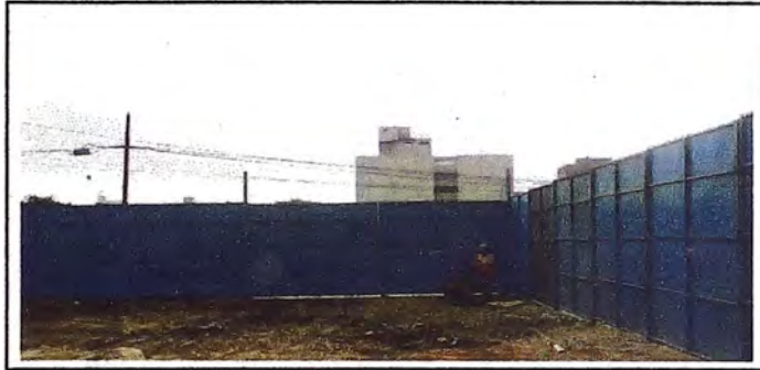
Figura N° 2.1: Parte de cerco de la obra (vista desde adentro)
