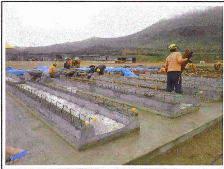
Figura N° 18: Losas prefabricadas en taller
