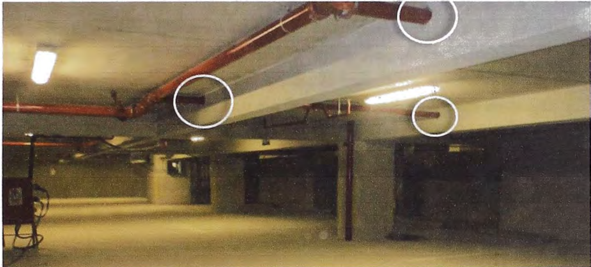
Fig. 78 Pases en vigas mediante perforaciones diamantinas
