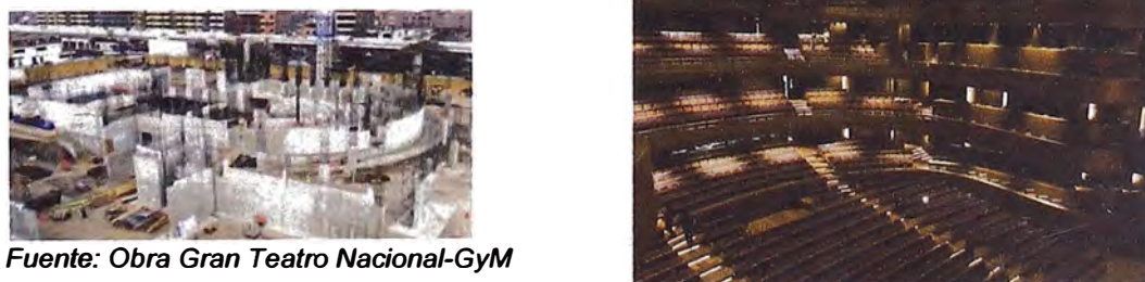
Fig. 6 Proceso constructivo Gran teatro Nacional y entrega
