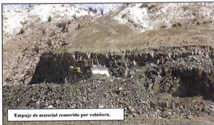
Figura N° 3.4 Procedimiento de remoción de escombros
