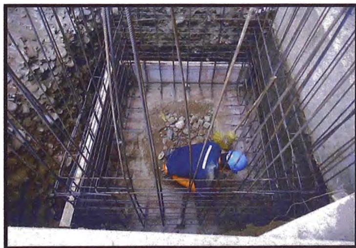
Figura 42. Construcción de cisterna de aceite
