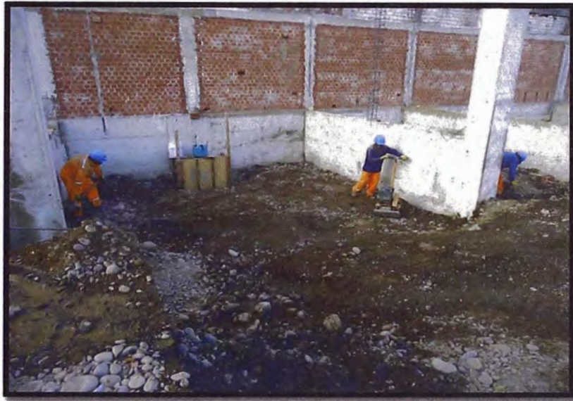
Figura 35. Refuerzo de zapatas
