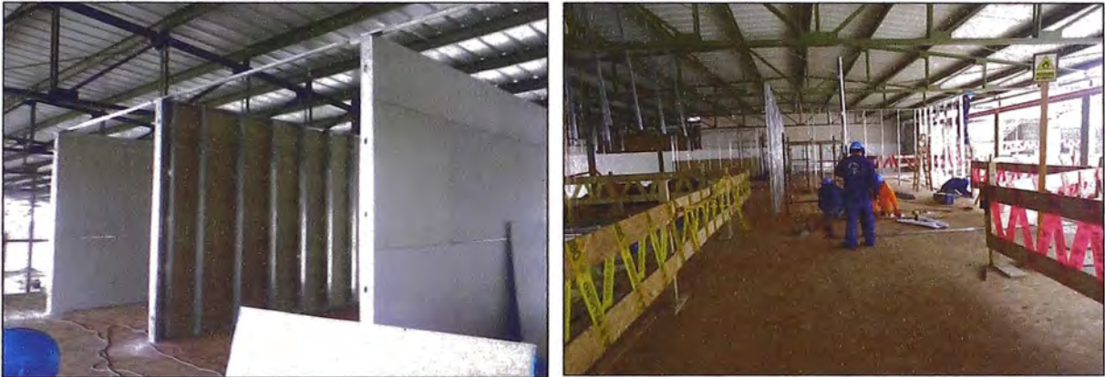
Figura 45. Izquierda drywall – derecha vidrio
