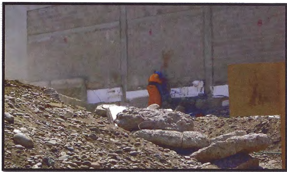
Figura 1. Picado de Muros
