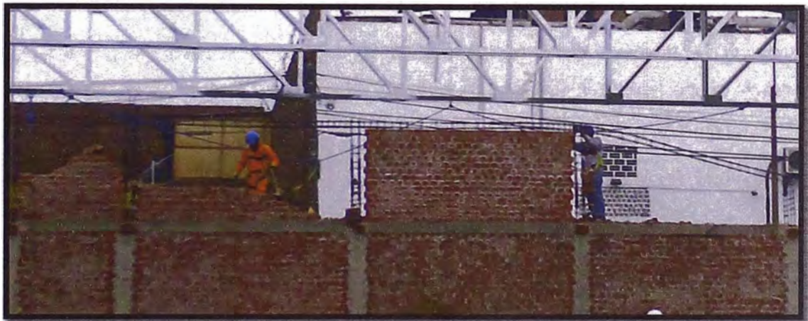
Figura 40. Demolición del muro
