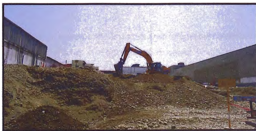
Figura 2. Excavación de Sótano
