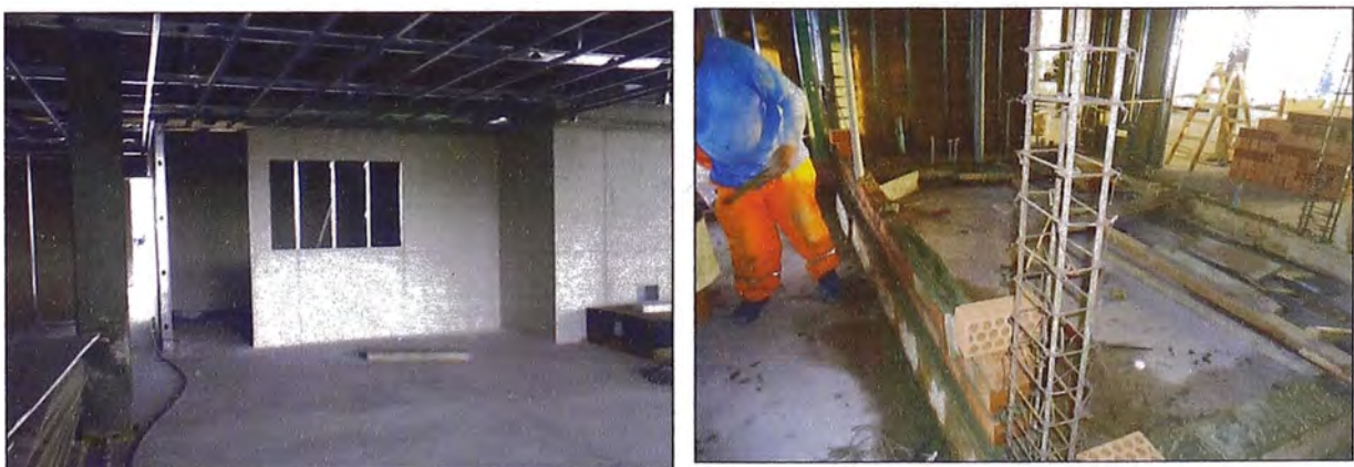
Figura 44. Izquierda Drywall- Derecha albañilería
