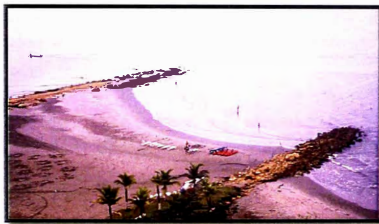
Figura N°3.16 Espigones en Piedra
