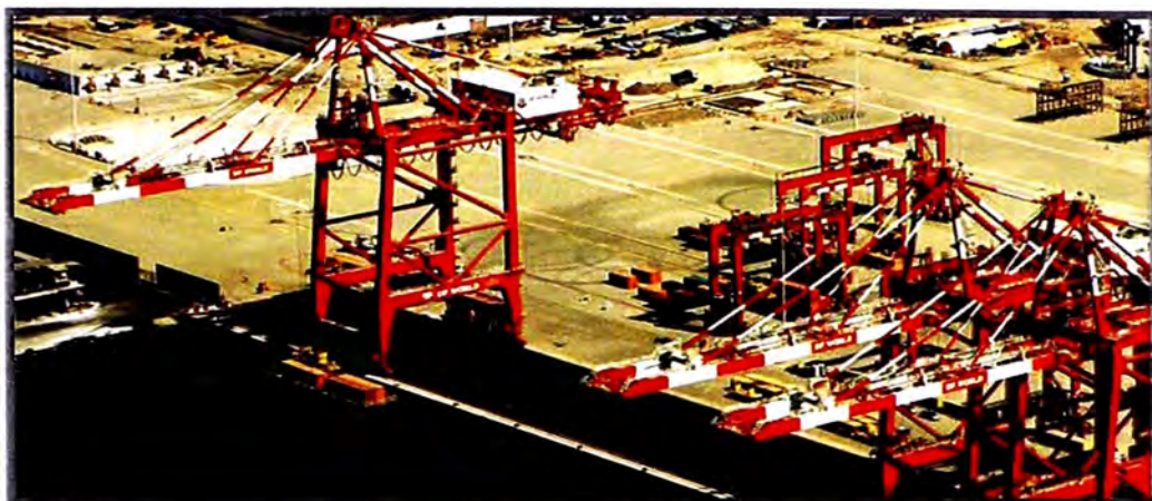
Figura N°2.1 Equipos sobre rieles y montados
