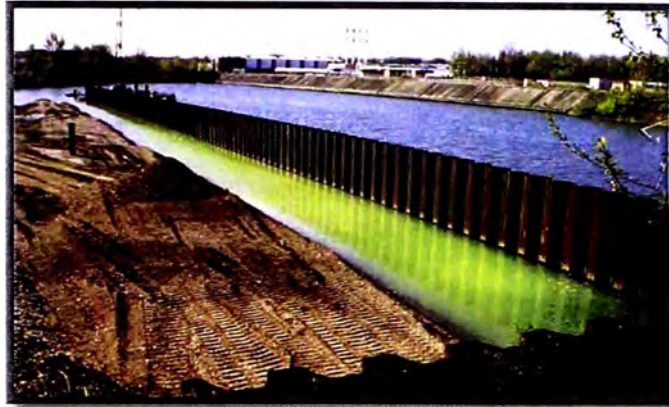
Figura N°1.28 Pantalla de Tablestaca Metálica
