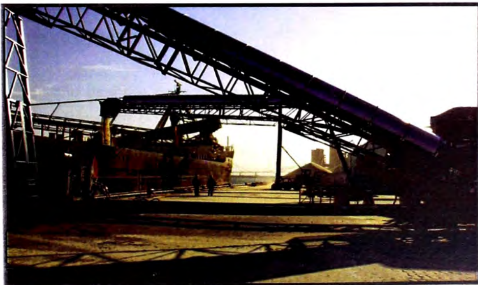
Figura N°2.5 Estructura de soporte – Faja transportadora
