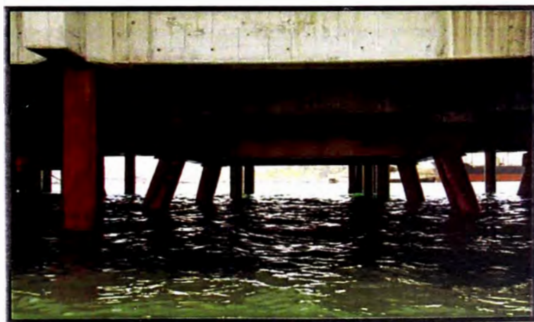
Figura N° 4.12 Esquema de pilotes verticales e inclinados
