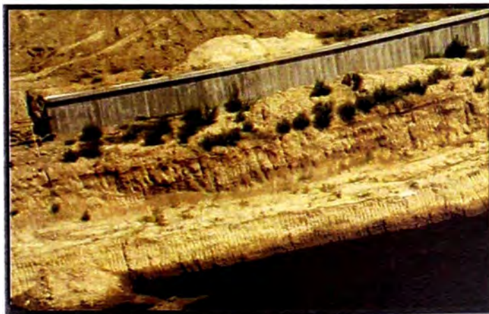
Figura N°1.29 Pantalla de Concreto Armado
