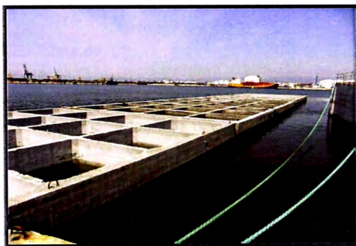
Figura N°1.24 Muro de Cajones
