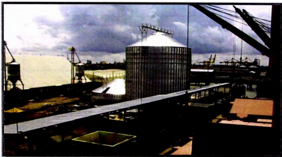
Figura N°2.6 Chutes y Tolvas
