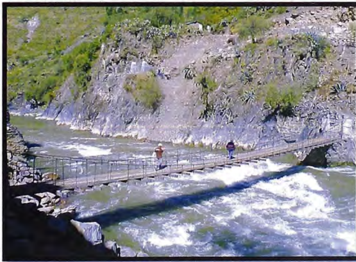
Figura N° 3.3.- Puente peatonal provisional.
