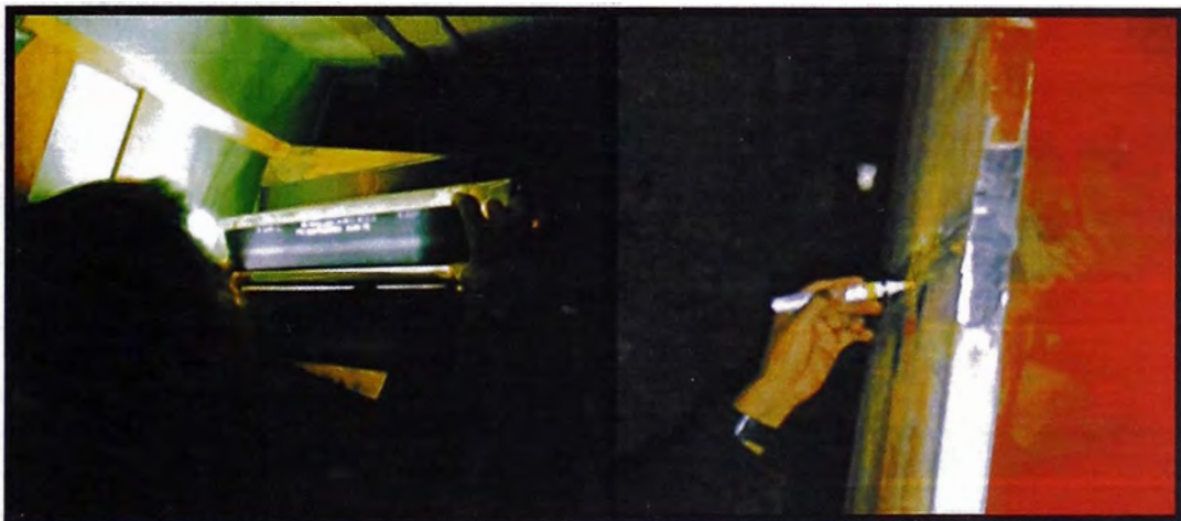
Figura N° 3.12.- Inspección de la soldadura
