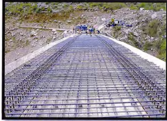
Figura N°3.24.- Acero de refuerzo en el tablero.
