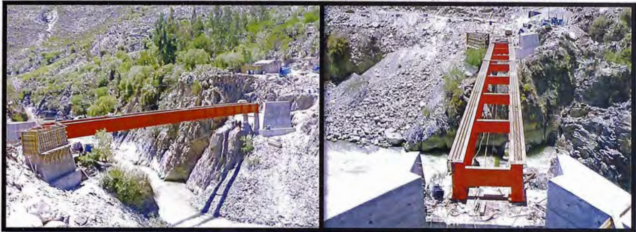
Figura N° 3.22.- Vistas de la estructura metálica ya emplazada.
