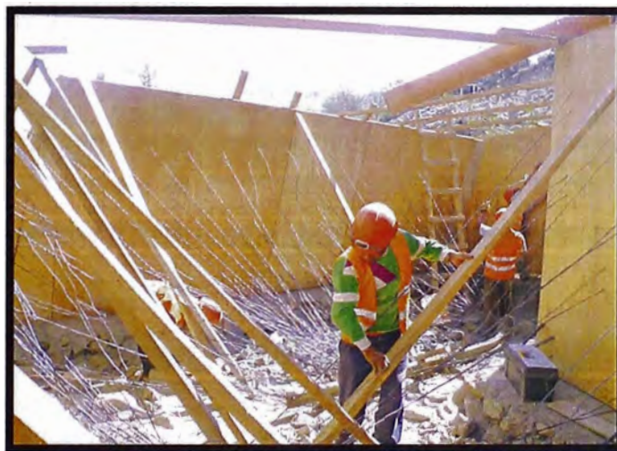
Figura N° 3.5.- Encofrado del estribo derecho.
