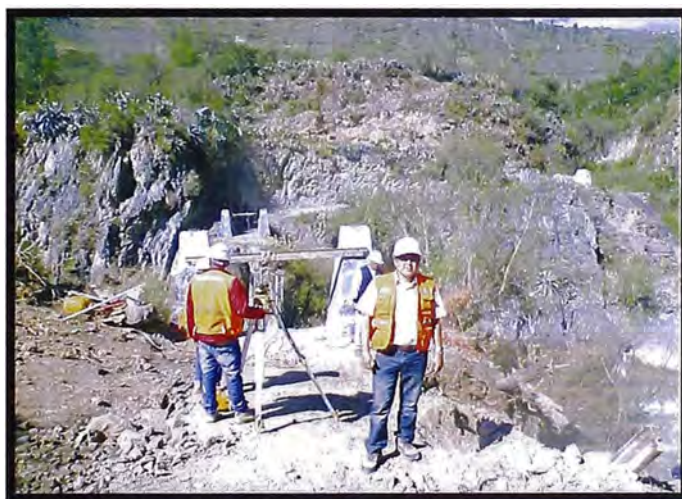
Figura 3.1.- Trabajos de topografía en el puente San Francisco.
