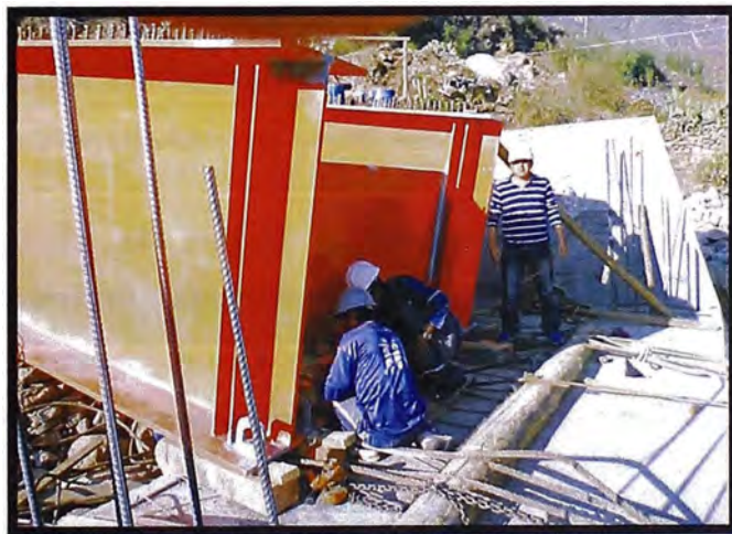
Figura N° 3.15.- Ensamblaje de la estructura metálica.
