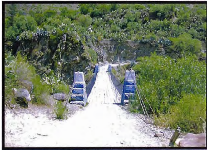
Figura N° 1.1.- Vista del puente peatonal desde el margen izquierdo.
