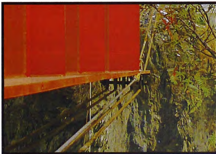
Figura N° 3.17.- Detalle del rodillo acoplado al primer segmento de lanzamiento.
