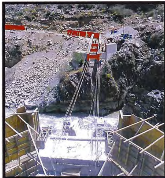
Figura N° 3.19.- Vista del lanzamiento desde el estribo opuesto.
