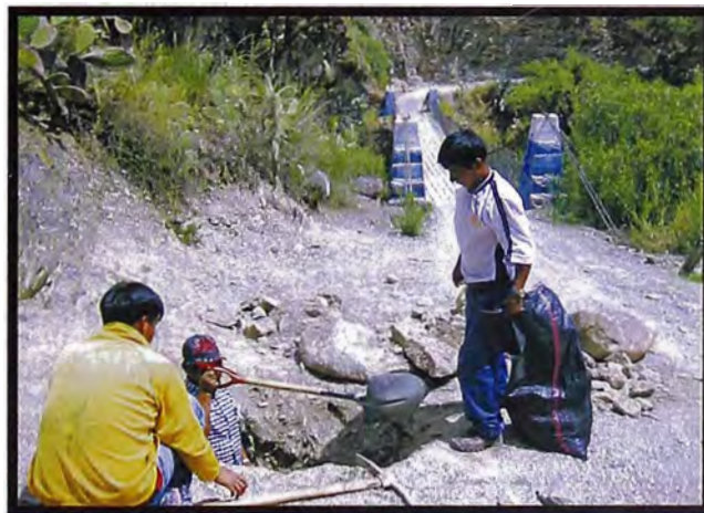
Figura N° 2.4.- Calicata en el margen izquierdo.
