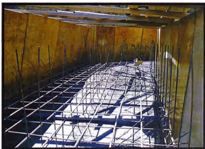
Figura N° 3.7.- Armadura de acero en la cajuela.
