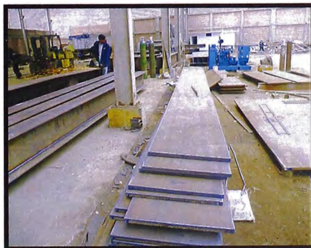
Figura N° 3.9.- Corte de las planchas de acero.
