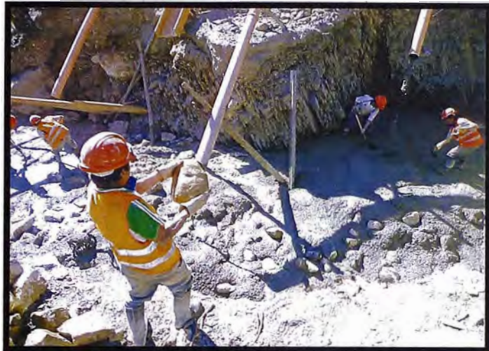
Figura N° 3.6.- Concreto ciclópeo para estribos.
