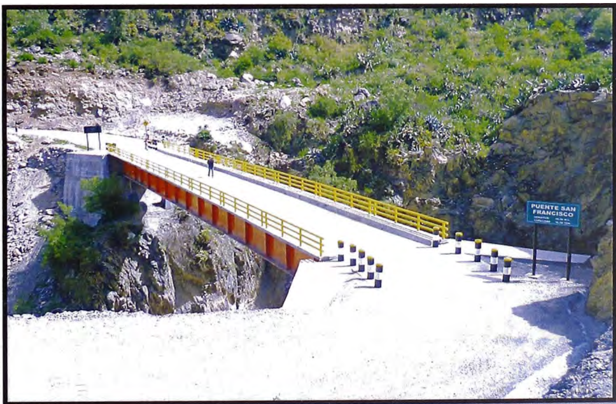
Figura N° 3.30.- Obra puente San Francisco finalizada.
