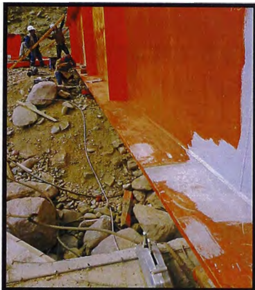
Figura N° 3.20.- Ensamblaje del siguiente segmento a ser lanzado.
