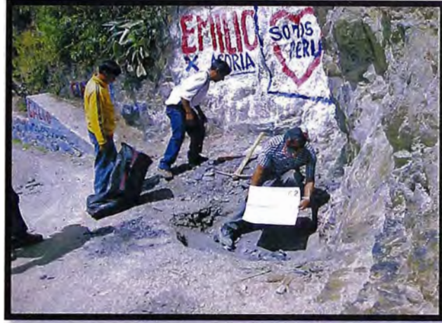
Figura N° 2.3.- Excavación de calicata en el margen derecho.
