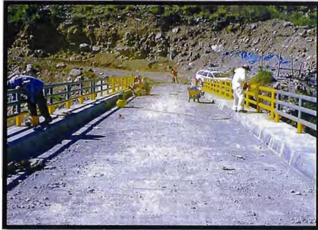
Figura N° 3.26.- Pintado de las barandas metálicas.
