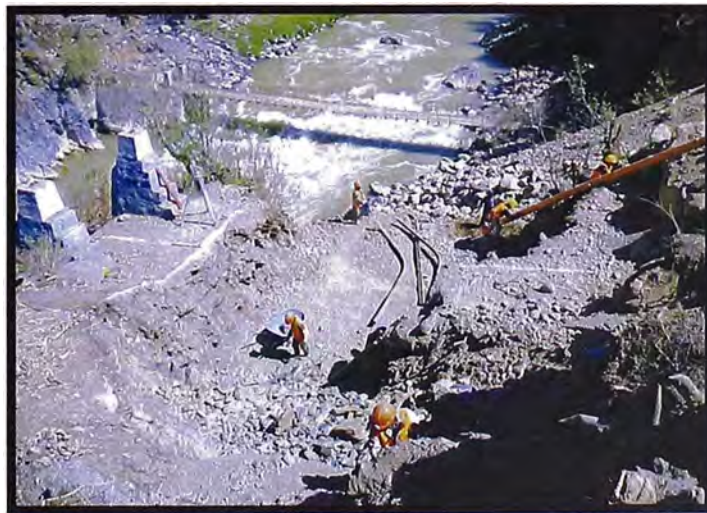
Figura N° 3.4.- Inicios de la etapa de excavación en el estribo izquierdo.
