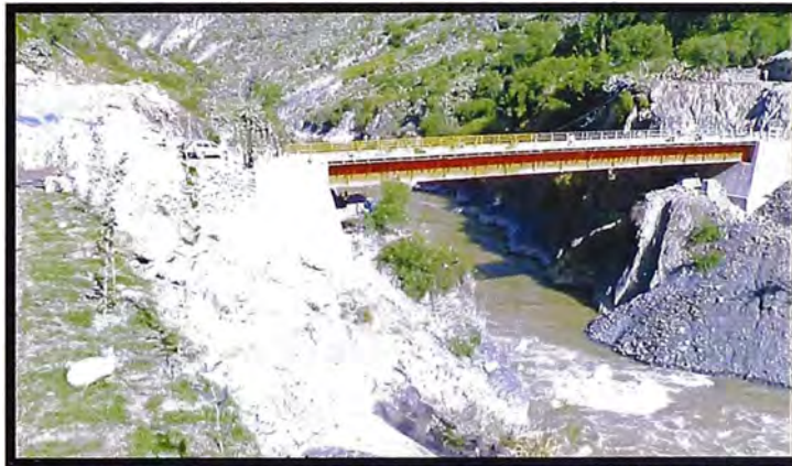
Figura N° 3.29.- Sembrío de pasto natural y plantones en los taludes de la carretera de acceso próximo al puente vehicular.
