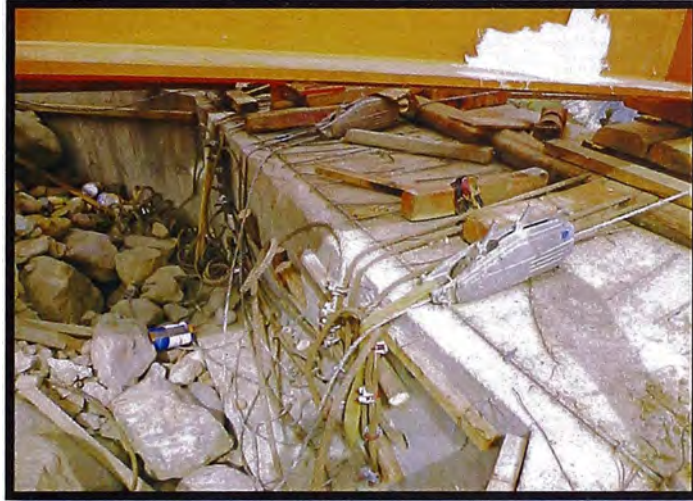
Figura N° 3.16.- Detalle del anclaje de los cables y del tecle tirfor.
