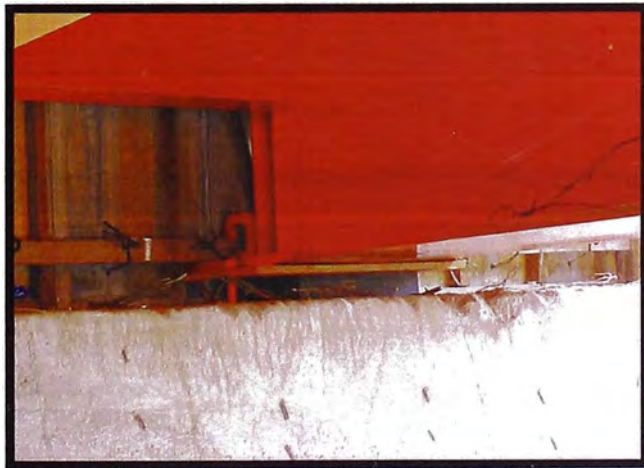
Figura N° 3.13.- Apoyo de neopreno.
