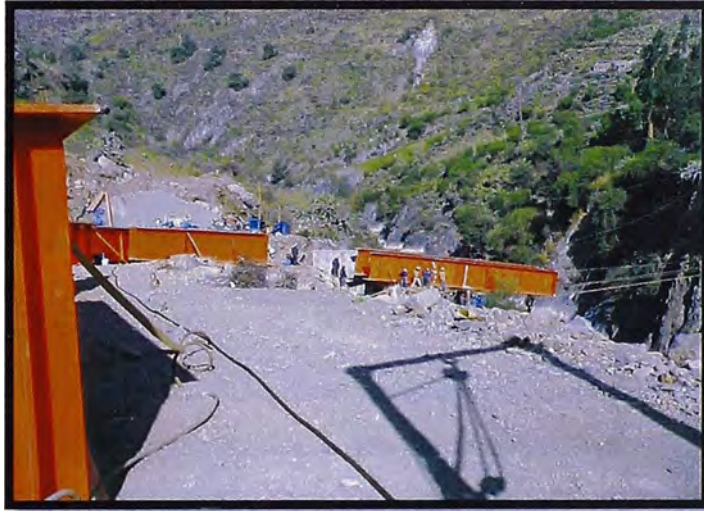
Figura N° 3.18.- Lanzamiento del primer segmento del puente.
