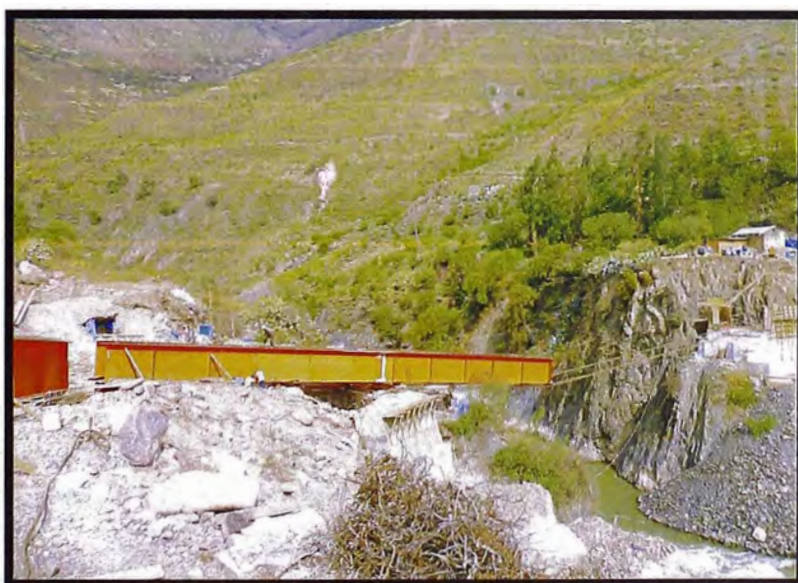
Figura N° 3.21.- Vista del lanzamiento con el quinto segmento ya acoplado.
