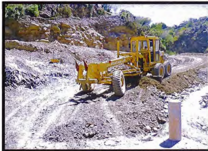
Figura N° 3.27.- Trabajos iniciales de las vías de acceso.
