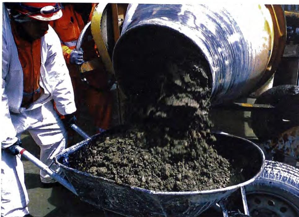
**Figura N° 3.10.- El CCR luego de terminado el mezclado es vaciado de la mezcladora donde se observa consistencia seca.**
