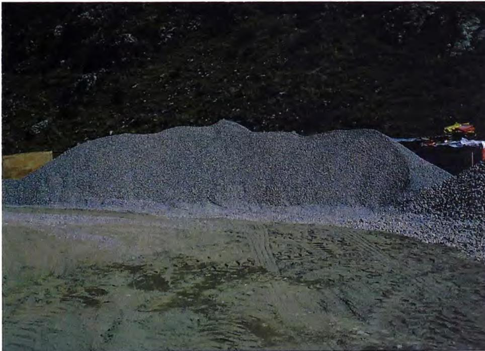
Figura N° 3.5.- Acopio de agregado grueso (huso 57), que se usó para determinar los diseño de CCR.
