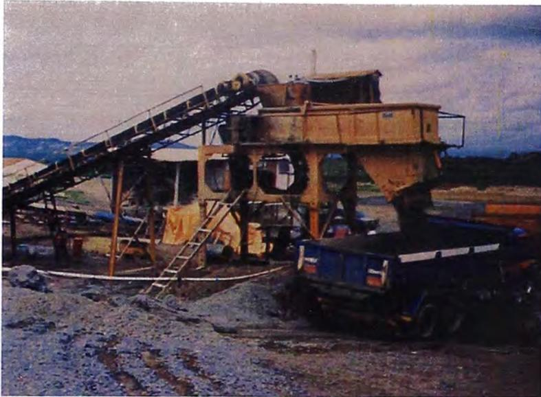
**Figura N° 4.5.- Traslado y colocación del CCR mediante camiones.**
