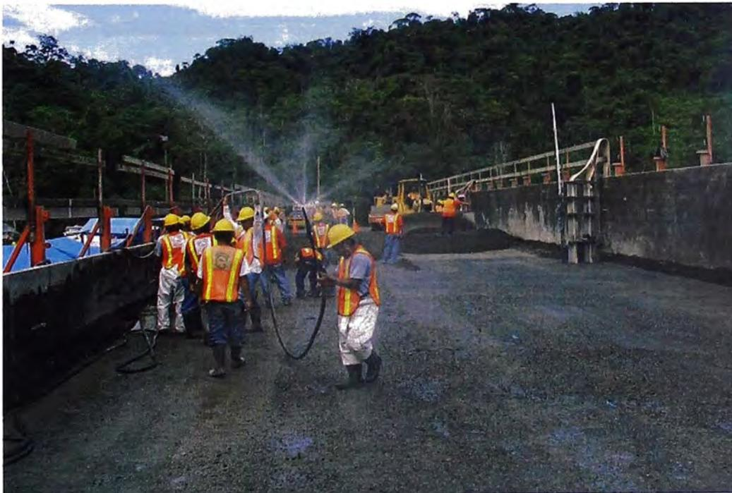
**Figura N° 4.9.- Sistema de rociado de agua para el curado del CCR.**
