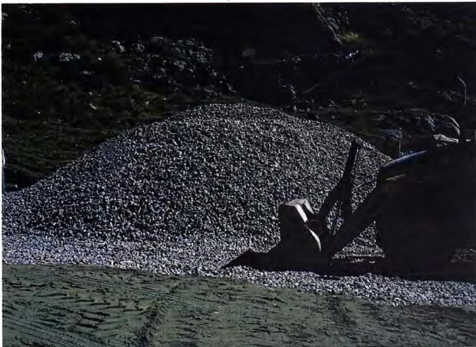
Figura N° 3.3.- Acopio del agregado grueso (Huso 3), que se uso para determinar los diseños de CCR.
