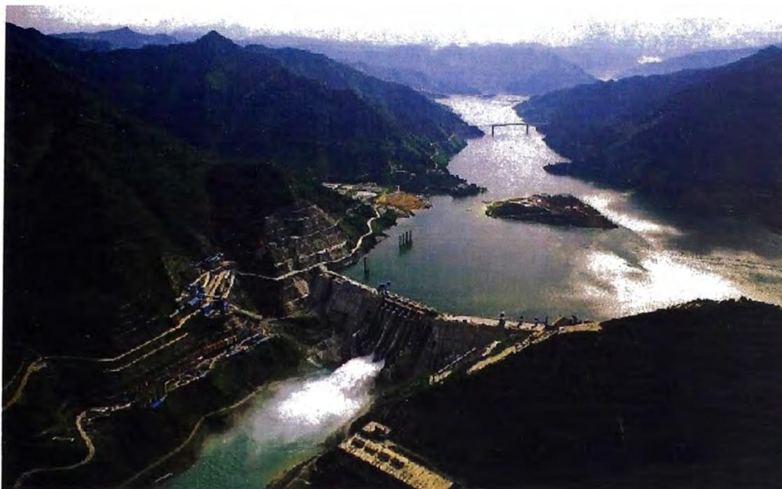
**Figura Nº 1.1.- Presa Longtan de CCR ubicada en la provincia de Tian China, altura de 216 m y longitud de coronación de 832 m.**
