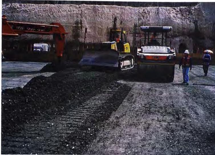
**Figura N° 4.6.- Extendido de la mezcla del CCR con equipos de oruga (Bulldozer).**
