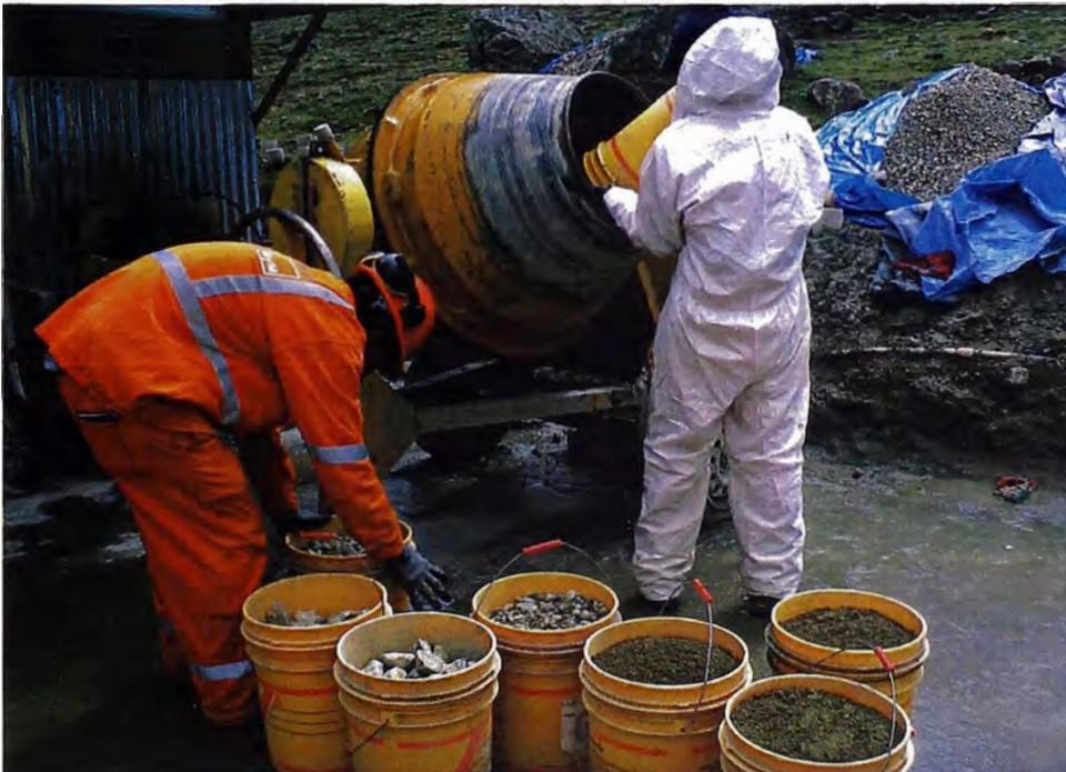
**Figura N° 3.9.- Colocación de los materiales (agregado grueso, fino, cemento y agua) en la mezcladora tipo trompo de 0.25m<sup>3</sup>.**
