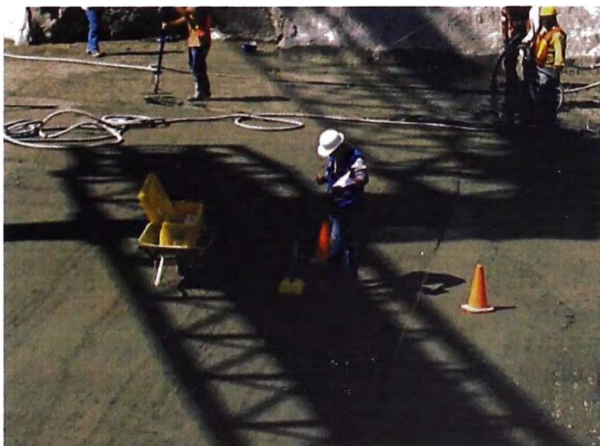
Figura N° 4.8.- Control de la compactación en campo con el densímetro nuclear.
