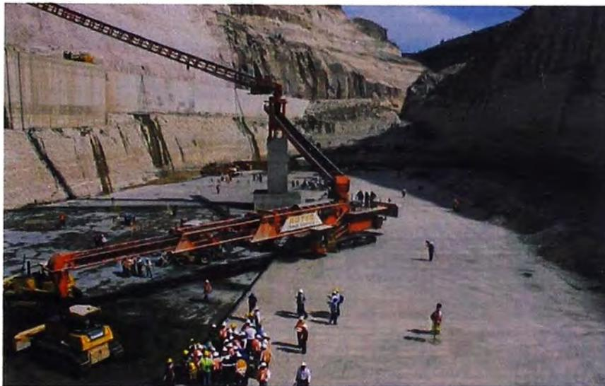
**Figura N° 4.4.- Colocación de CCR mediante cintas transportadoras.**
