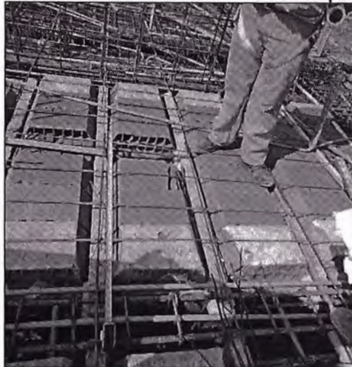
FIGURA. N° 4.8 Colocación del Acero de Temperatura.
