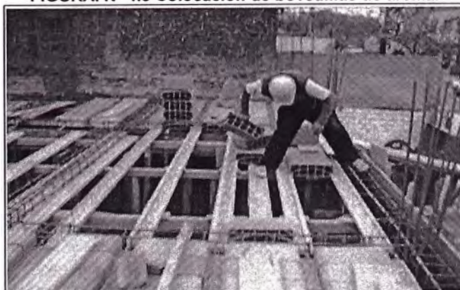
FIGURA. N° 4.5 Colocación de bovedillas de arcilla.
