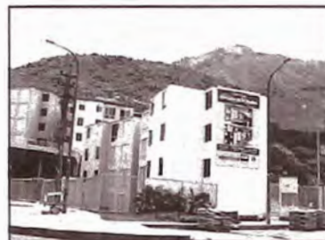
Conjunto Habitacional Melgarejo - GYM
