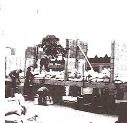
Foto1- Ensayo con cargas estáticas
