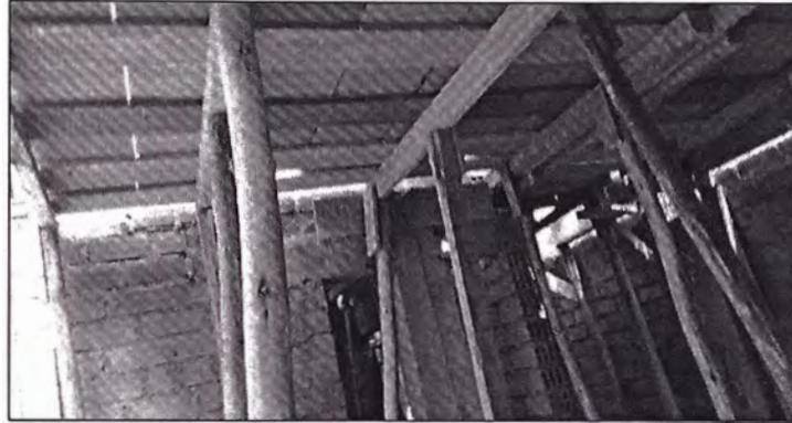
FIGURA 3.3 Detalle típico de encofrado de techo.
