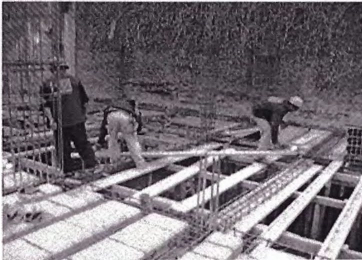
FIGURA. N° 4.4 Colocación de viguetas prefabricadas.
