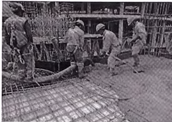
FIGURA. 5.5 Vaciado de losa
