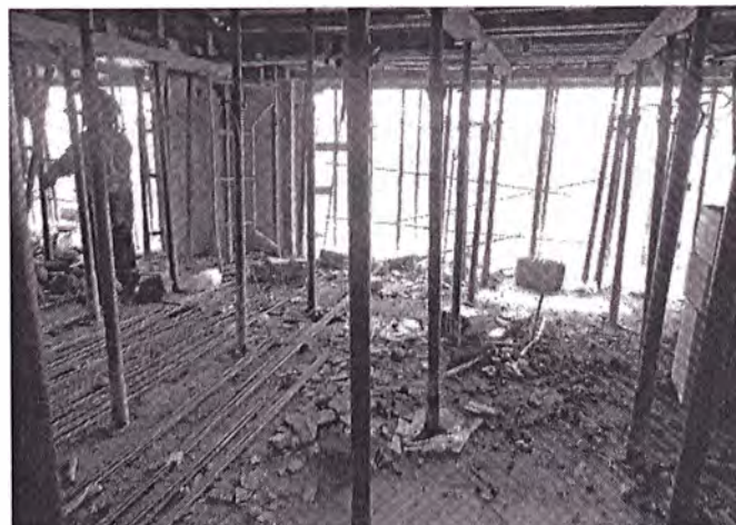
FIGURA. N° 4.3 Instalación de apuntalamiento de viguetas.(soleras).
