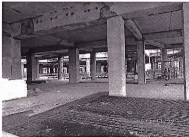
FIGURA. 5.6 Desencofrado de Prelosa
