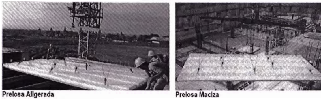
FIGURA. 5.3 Traslado de prelosas
