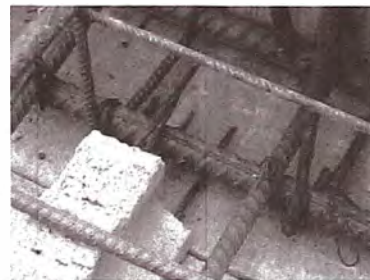
Foto6- Ensayo de carga - conexión viga - viga invertida
