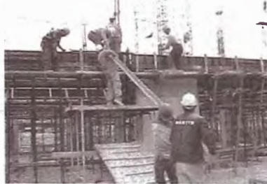
MANUAL (Las viguetas deben ser manipuladas en forma de T invertida)
