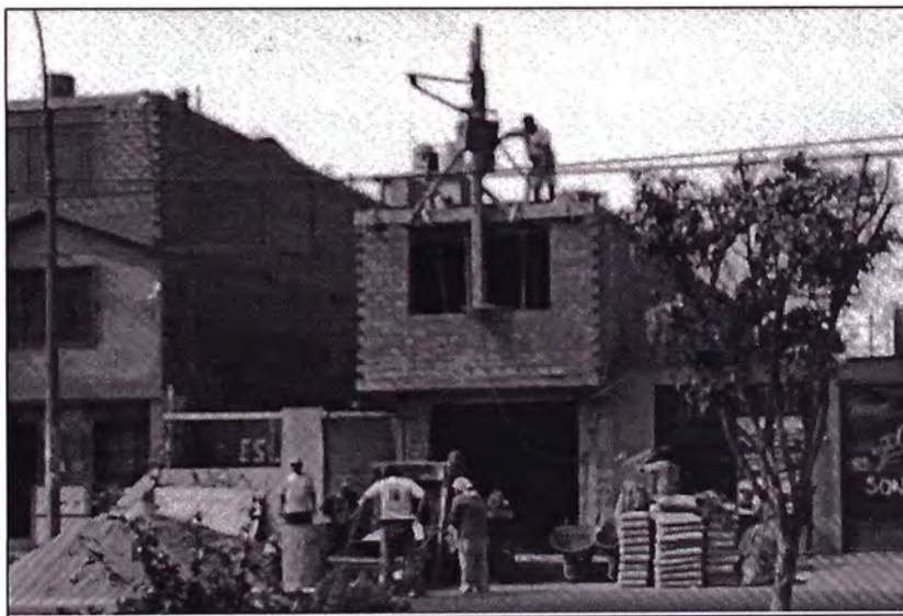
FIGURA. 3.10 Detalle típico de vaciado de techo con mezcladora.
