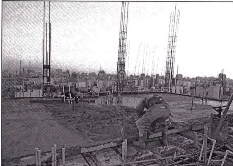
FIGURA. N° 4.10 Nivelación de losa de Techo.
