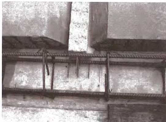
Foto10- Ensayo de carga Detalle de conexión
