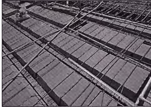
FIGURA. N° 4.6 Instalaciones eléctricas usando bandejas.
