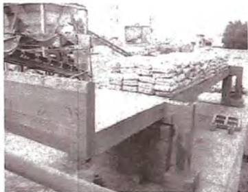
Foto5- Ensayo de Carga
