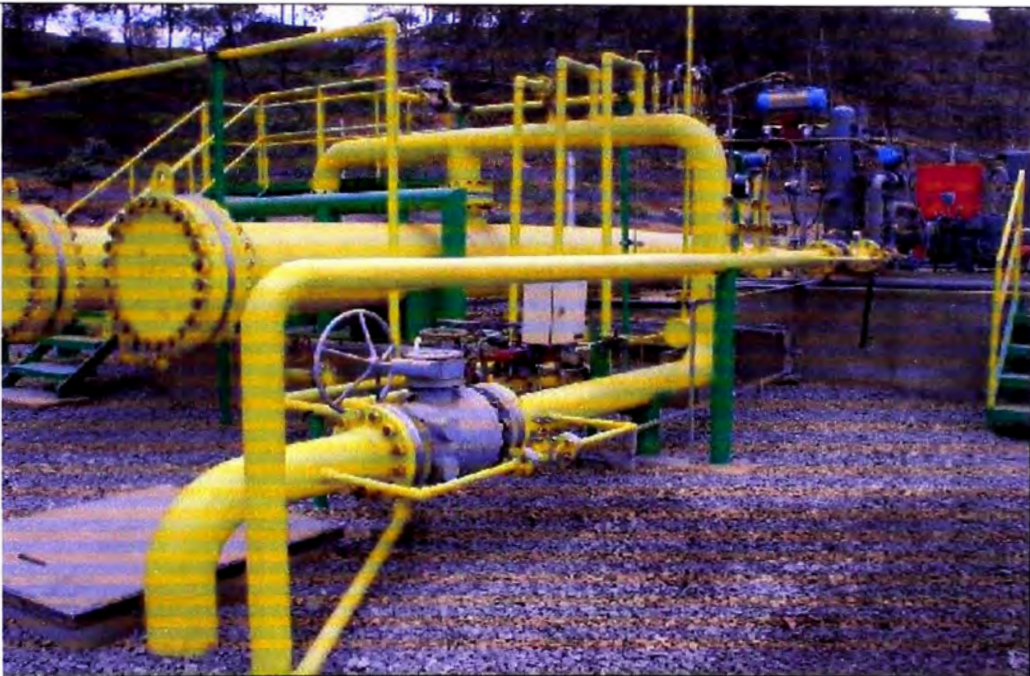
Figura 3.1: Sistema de Almacenamiento de Gas Natural – Pulmón
