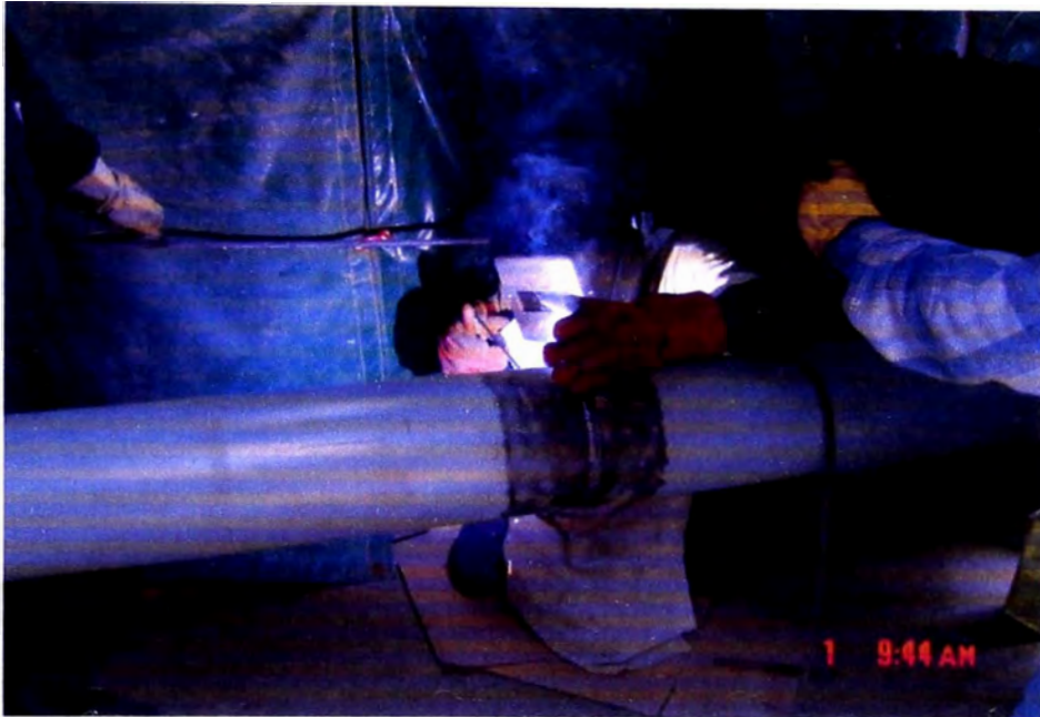
Figura 3.2: Soldaduras de Terreno
