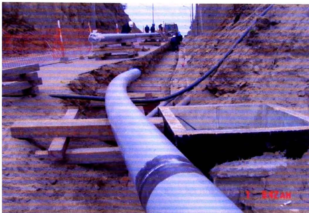
Figura 3.3: Montaje de Tuberías Enterradas
