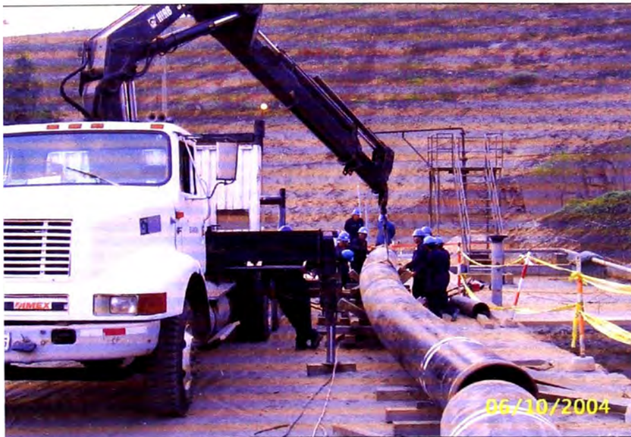
Figura 3.7: Desfile de Tuberías
