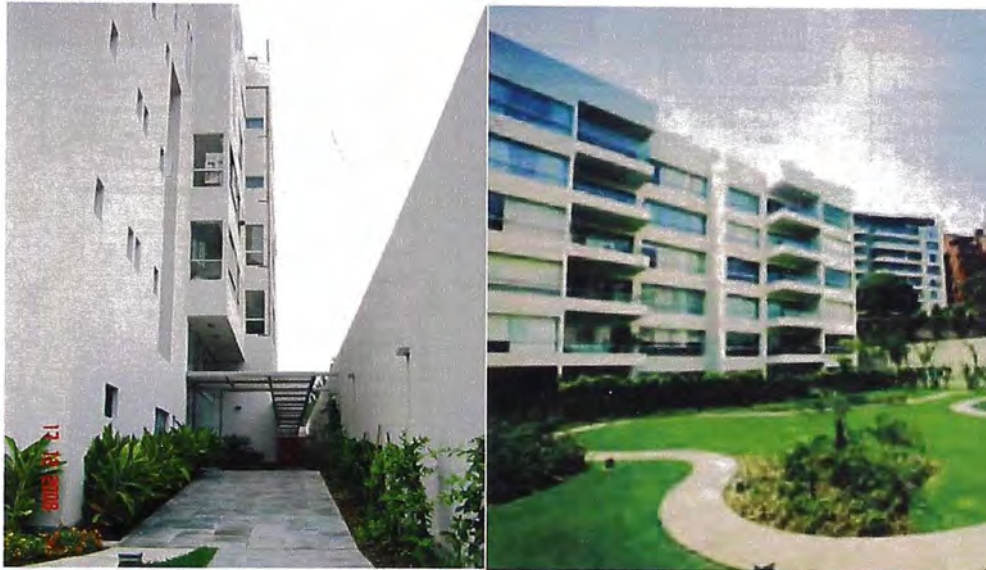
Figura 41: Fachada de Edificio- Proyecto clase A
