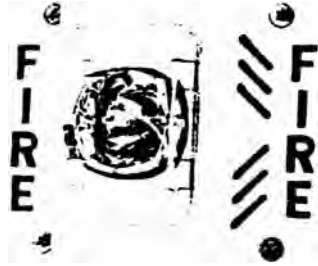
Fig. 24. Corneta con luz estroboscópica
