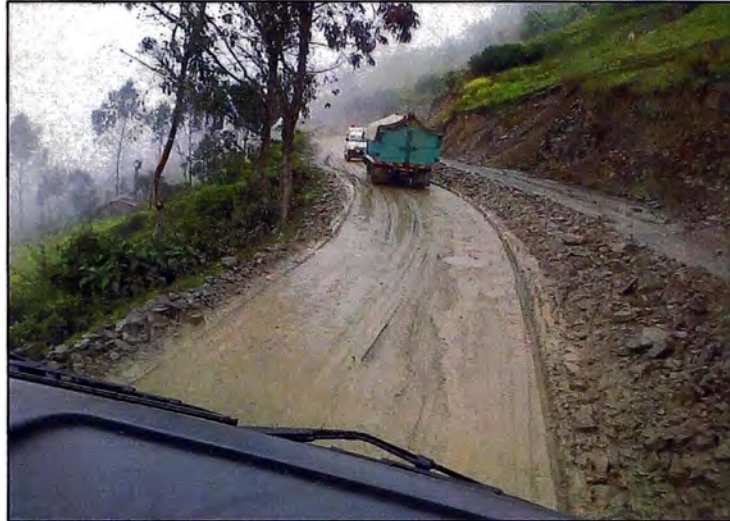
Interferencias, cruce con vehículos particulares – Frente 1
