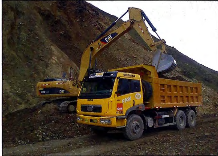
Operación de carguío a un volquete de marca Faw - Frente 3
