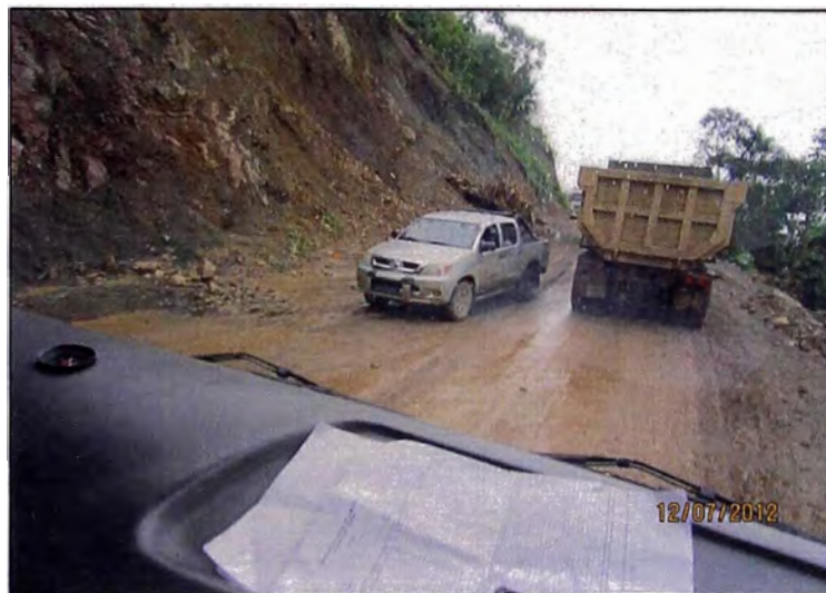
Acumulación de volquetes y cruces con vehículos particulares - Frente 3
