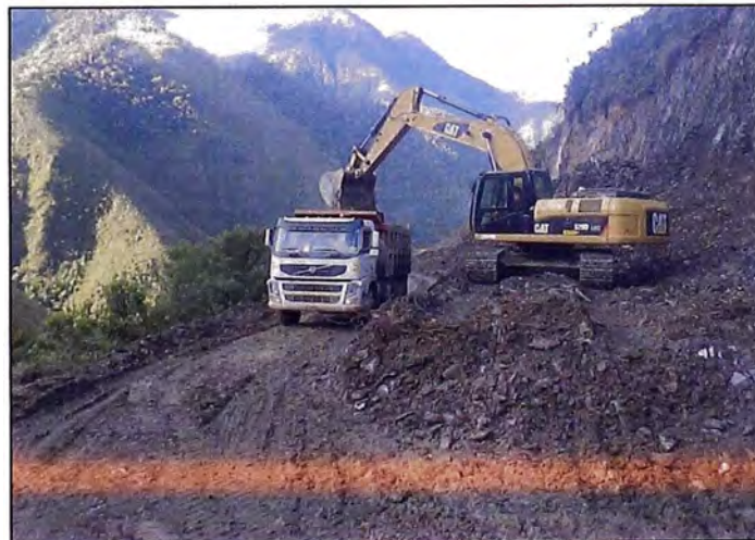
Figura 1.2: Transporte de material de excavación
