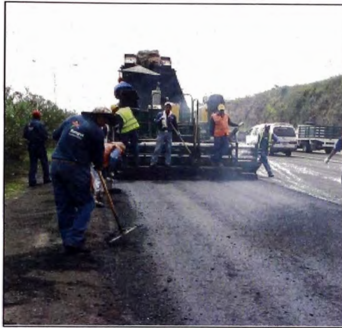
Figura 1.3: Transporte de mezcla asfáltica
