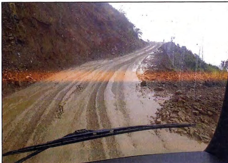
Ruta en mal estado para circulación – Frente 1
