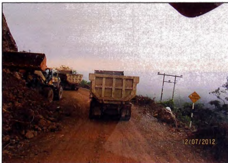
Trabajos de limpieza de derrumbes y cola de volquetes - Frente 3
