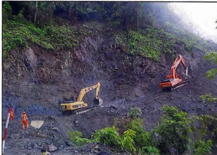
Trabajos de excavación - Frente 3
