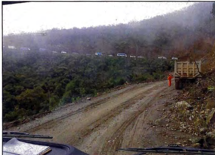
Cola de vehículos particulares por operaciones de excavación – Frente 1
