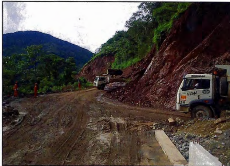
Operación de carguío y cola de volquetes - Frente 3
