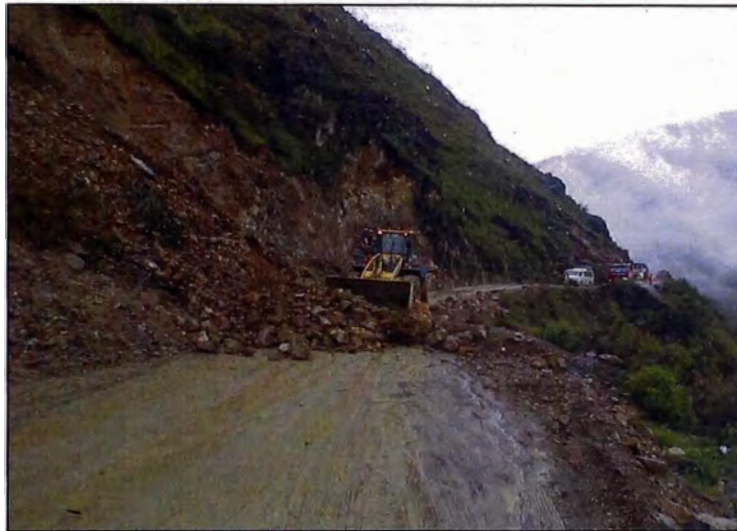
Trabajos de limpieza de derrumbes y cola de vehículos - Frente 1
