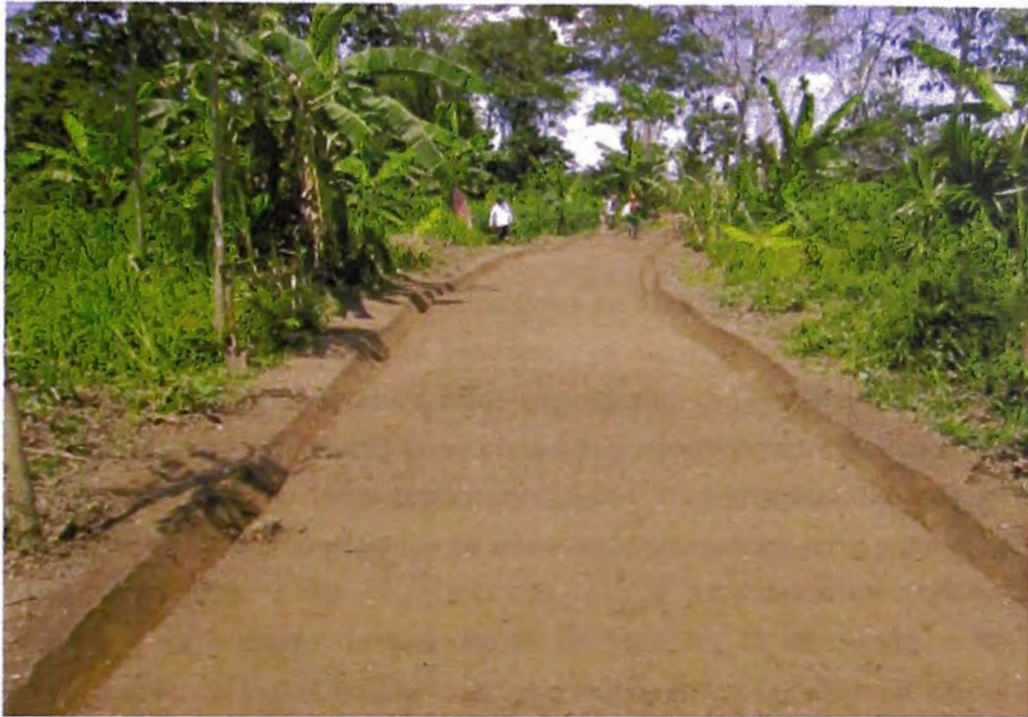
Figura 12.- Ampliación de caminos (Fuente propia)
