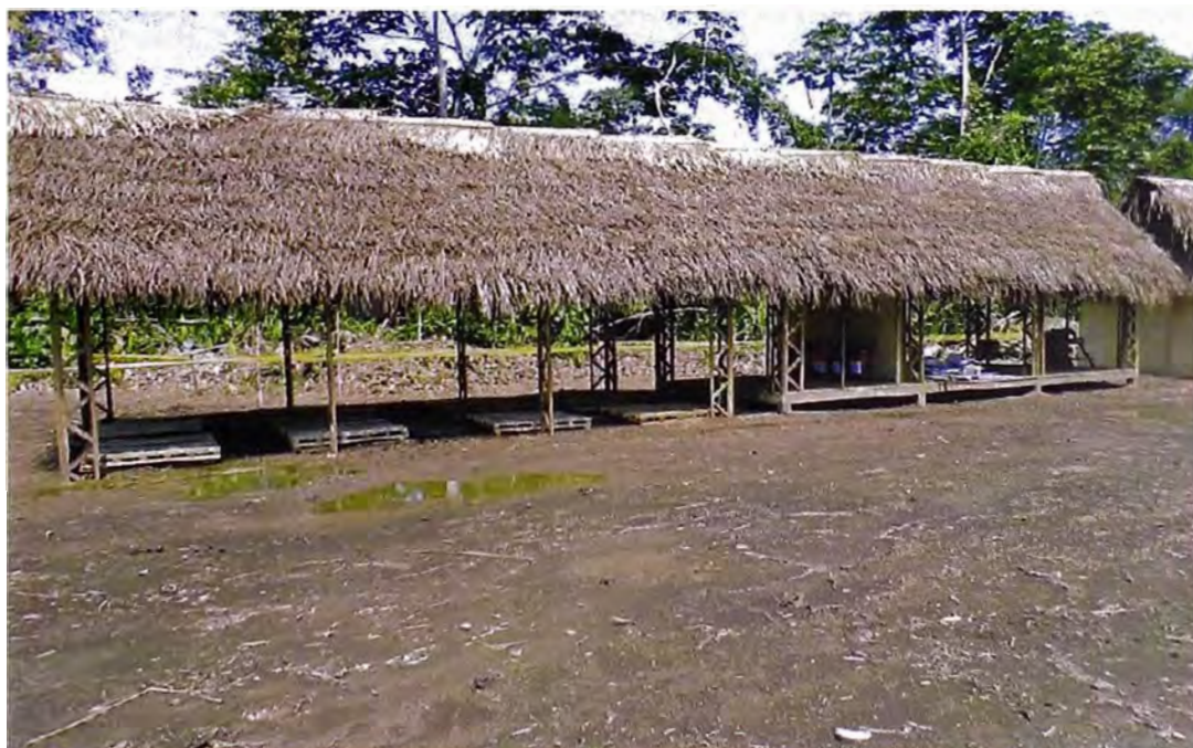
Figura 6.- Almacén en Campamento (Fuente propia)
