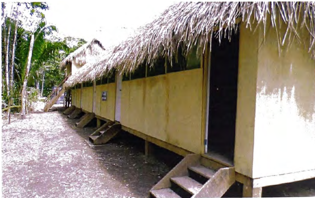
Figura 7.- Vista exterior de dormitorios en campamento (Fuente propia)
