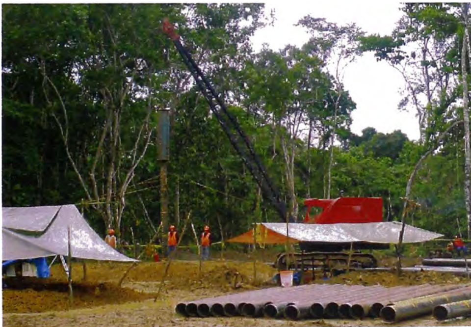
Figura 14.- Hincado de pilotes (Fuente propia)
