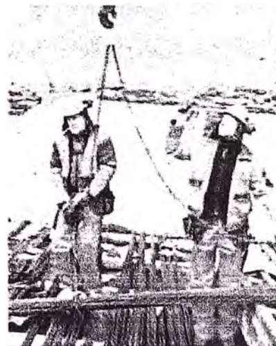
Fig. 1.18. Uso en izaje de material.
