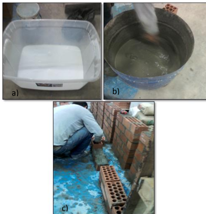
Figura N° 22: Mezcla agua con aditivo (a); mezcla del mortero con aditivo (b); elaboración de muretes de albañilería (c)
