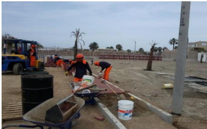
Figura N° 59 Ejecución de la actividad: Instalación de adoquines en veredas.<sup>100</sup>
