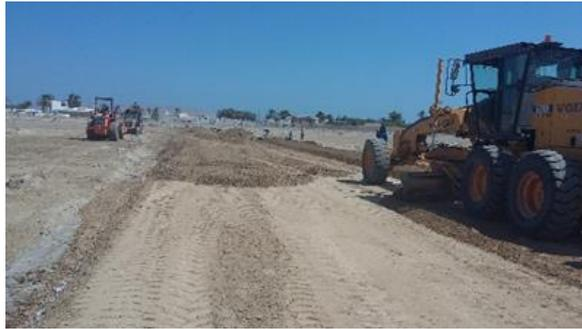
Figura N° 76 Nivelación del afirmado.<sup>119</sup>
