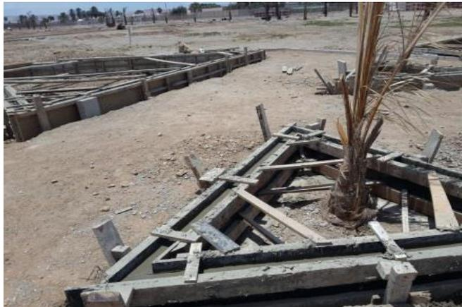
Figura N° 88 Encofrado de sardineles en veredas.<sup>135</sup>
