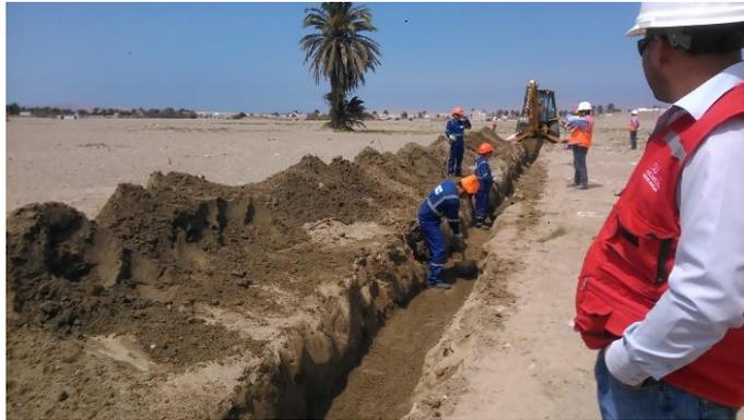
Figura N° 58 Ejecución de la actividad: Excavación manual de zanja.<sup>99</sup>
