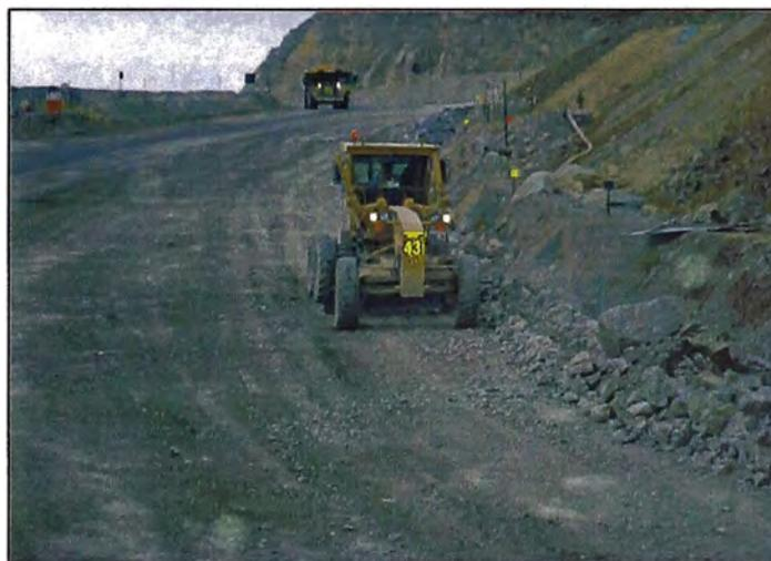
Figura N° 9.- Motoniveladora realizando limpieza de cunetas
