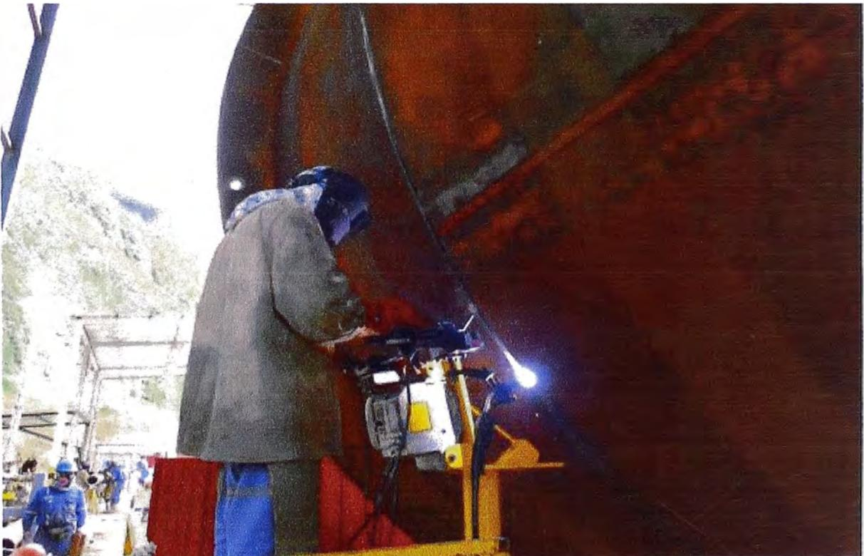
Figura N° 3.3.- Equipo de soldadura tractor SAW-SAM, uniendo los tubos de blindaje
