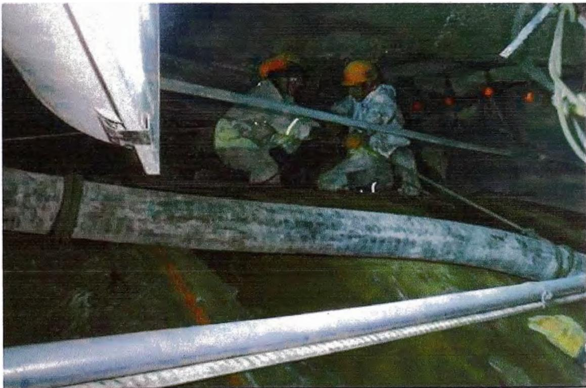
Figura N° 4.6.- Tubería transportando el concreto tipo 25 MPa
