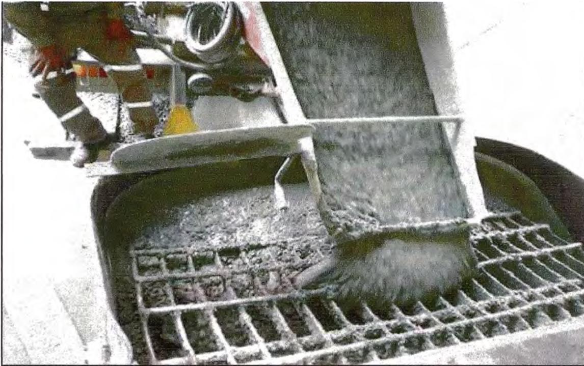
Figura N° 4.3.- Procedimiento adecuado de la descarga del concreto a la batea de la bomba telescópica
