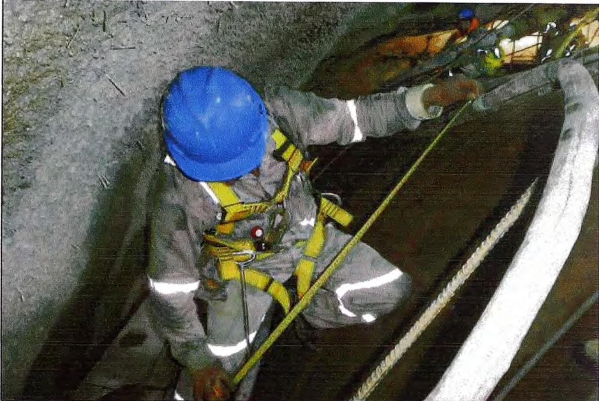
Figura N° 5.2.- Separación de 1m entre cada tubería del serpentin
