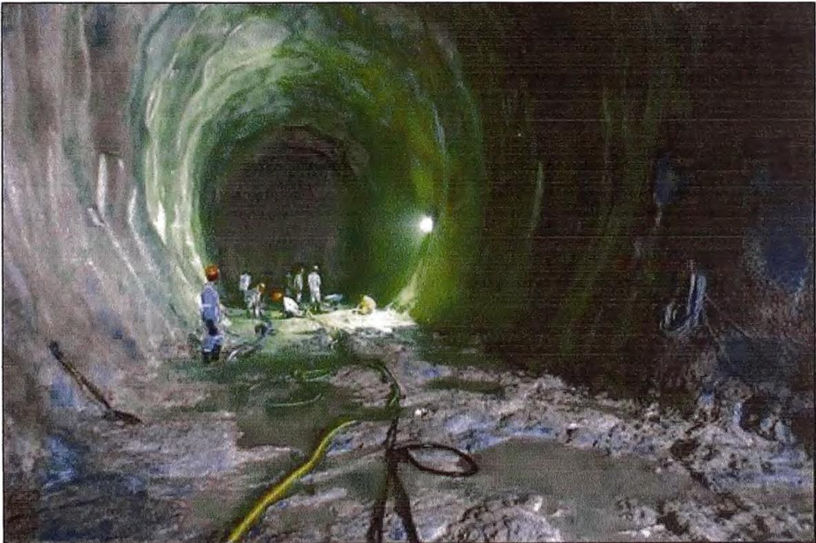
Figura N° 4.4.- Limpieza de roca para colocación del solado
