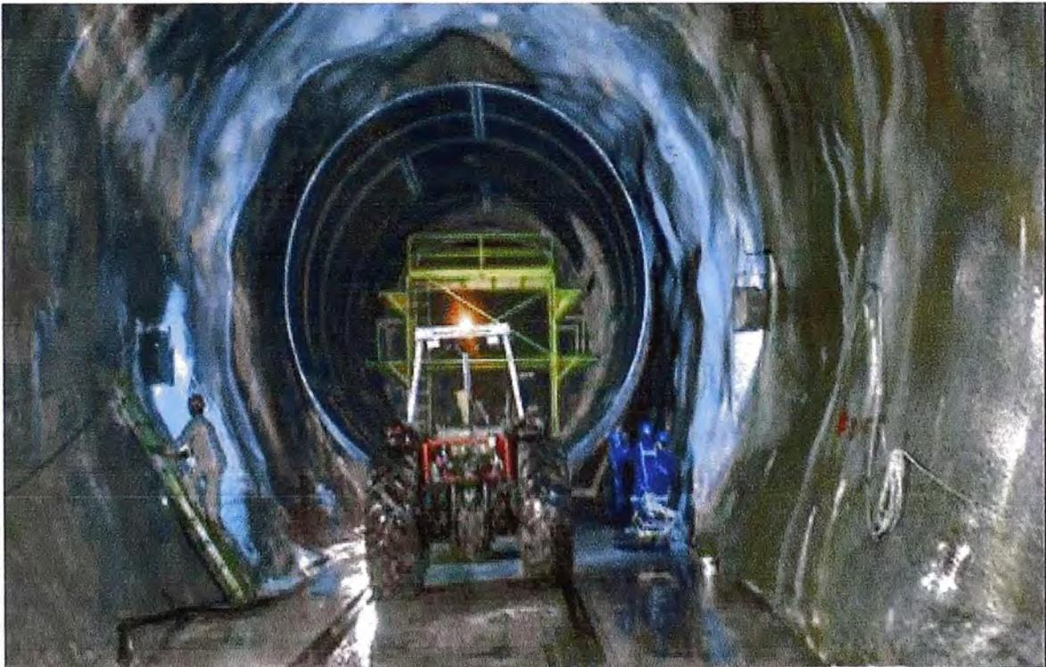
Figura N° 3.1.- Cargador agrícola empujando al tubo de blindaje, a su posición final
