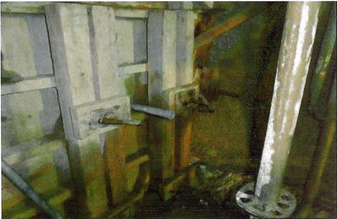
Figura N° 5.1.- Tubería de inicio del serpentín de enfriamiento, lado izquierdo hidráulico.
