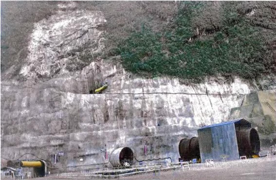
Figura N° 3.5.- Galpón donde se une los 2 Tubos de Blindaje de 6m cada uno
