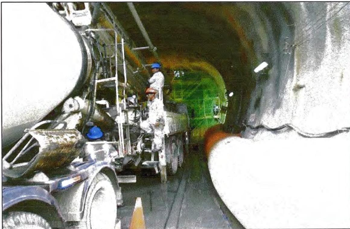
Figura N° 4.4.- Mixer descargando el concreto tipo 25 MPa, en el camión
