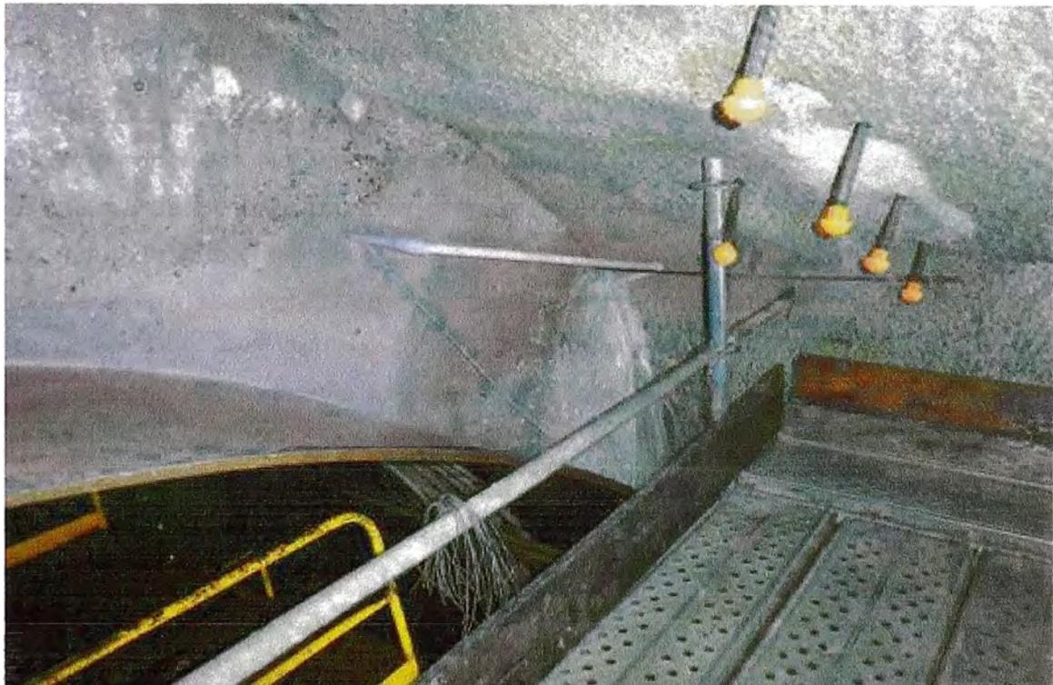
Figura N° 5.5.- Salida del agua por el serpentin de enfriamiento del lado izquierdo.
