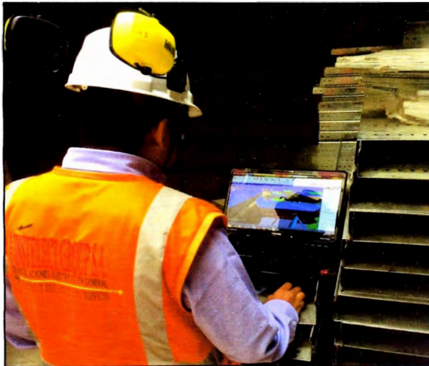
Figura N°5. 26: El subcontratista eléctrico revisa el modelo BIM antes de ingresar a montar sus instalaciones
