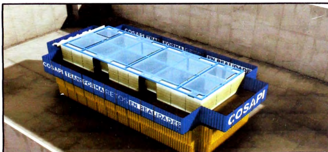
Figura N°5. 36: El encofrado Auto-trepante Doka en la estructura
