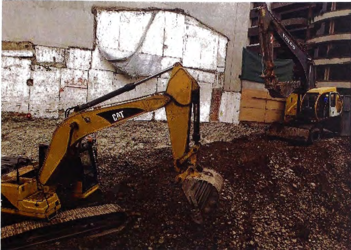
Figura 4.11: Eliminación de material con intercambio de cucharas.
