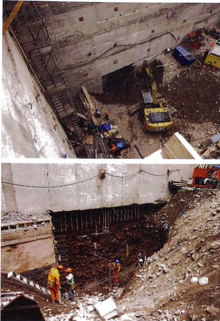
Figura 4.07: perfilado y pañeteo de muros.
