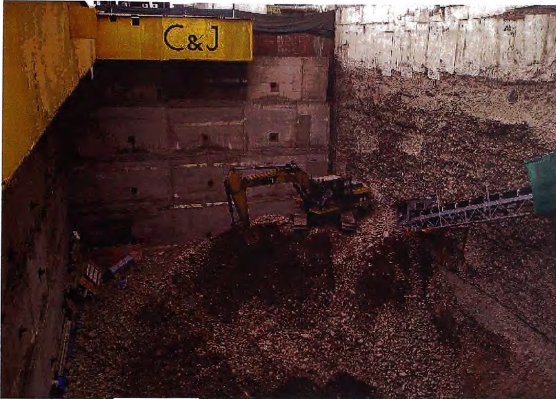
Figura 4.12: Eliminación de material con faja transportadora
