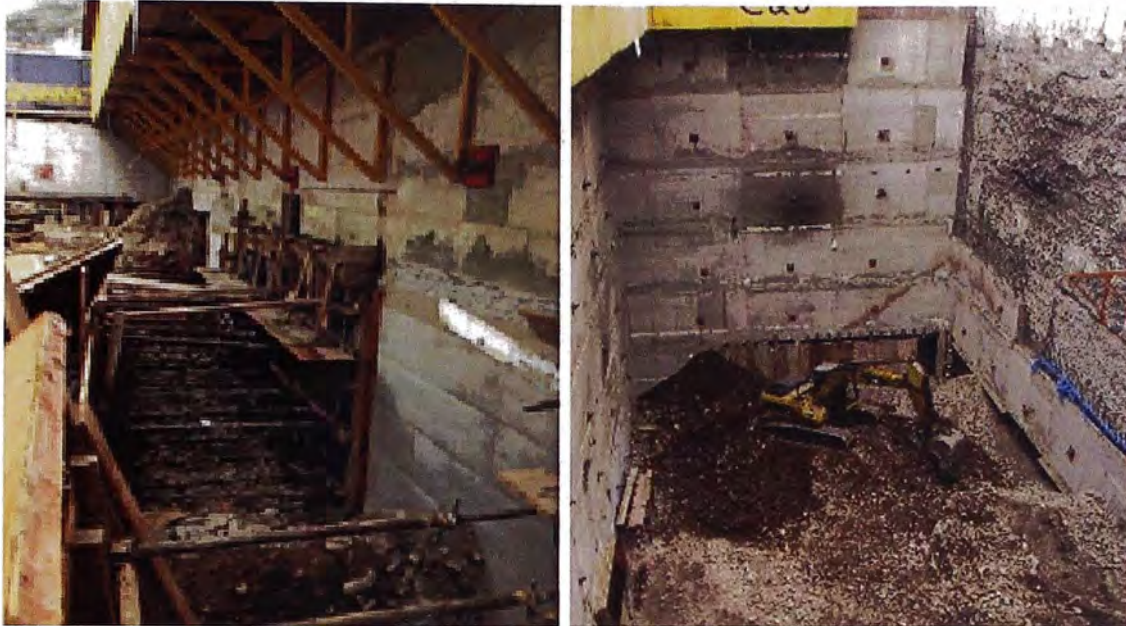
Figura 4.09: sistemas de encofrado para muros pantalla.
