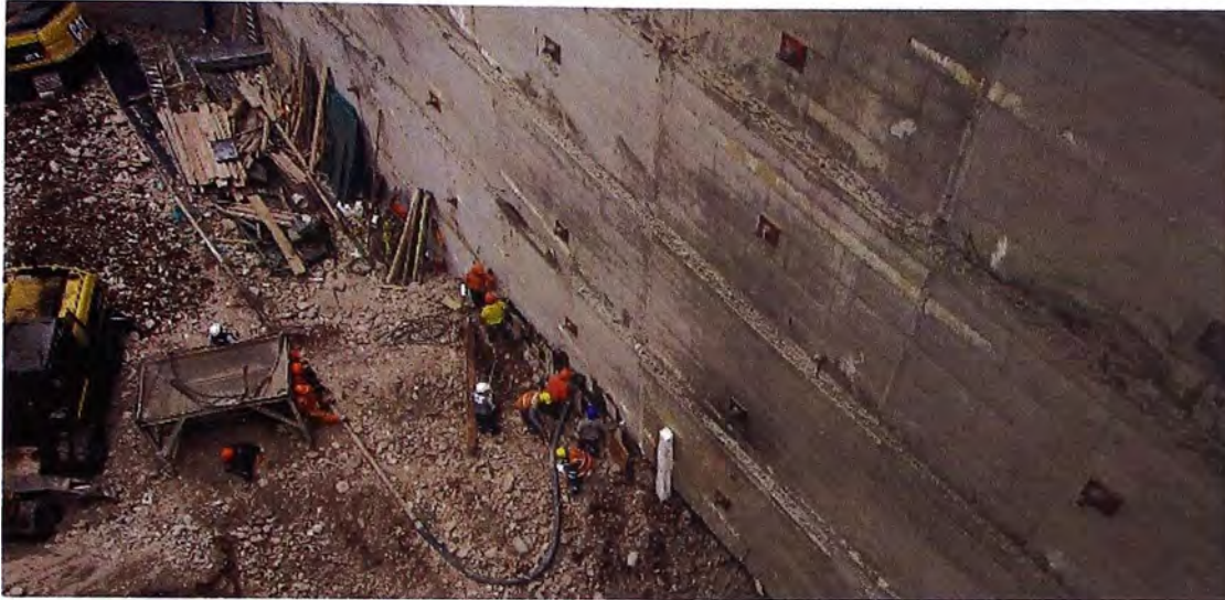
Figura 4.10: Vaciado de muros pantalla
