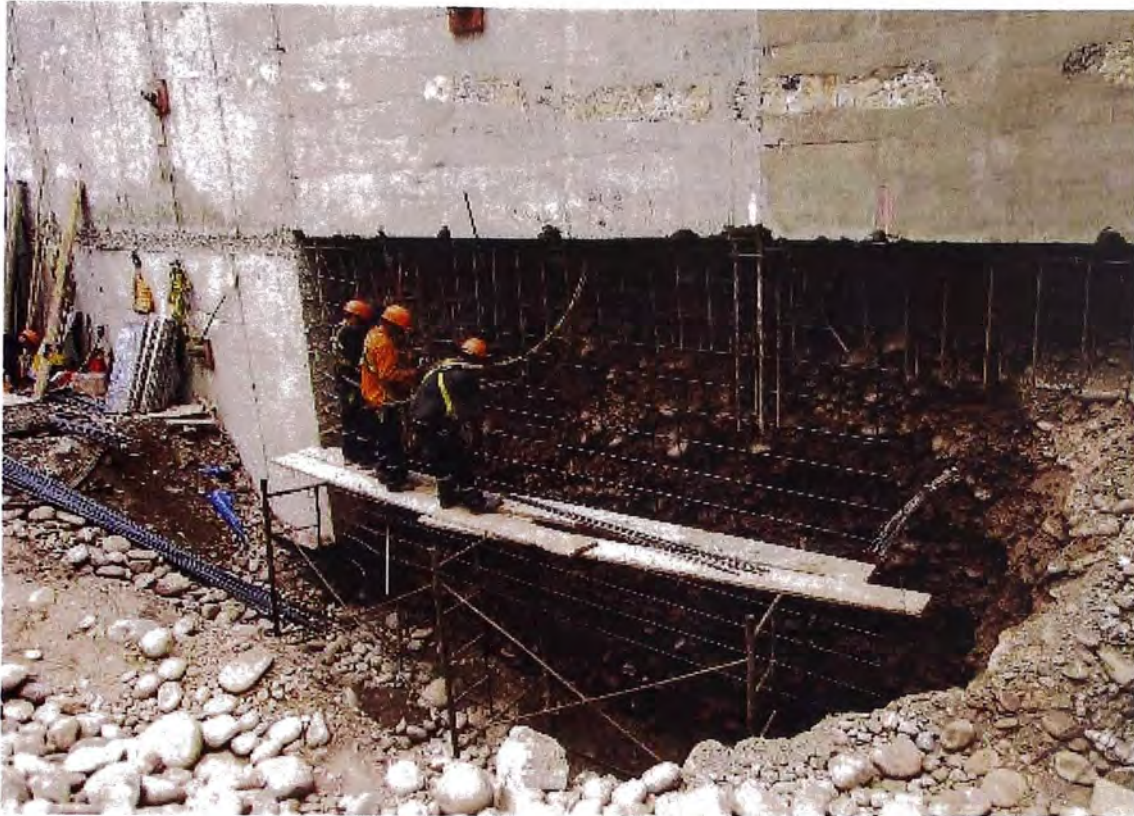
Figura 4.08: Colocación de armadura de acero en muros pantalla.
