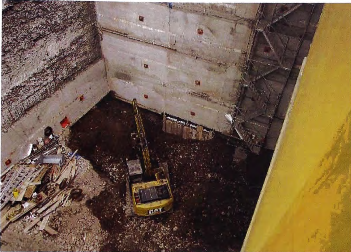
Figura 4.06: excavación del quinto nivel
