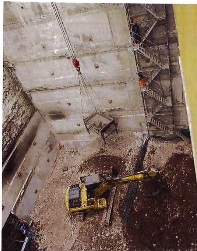
Figura 4.13: Eliminación de material con grúa y balde
