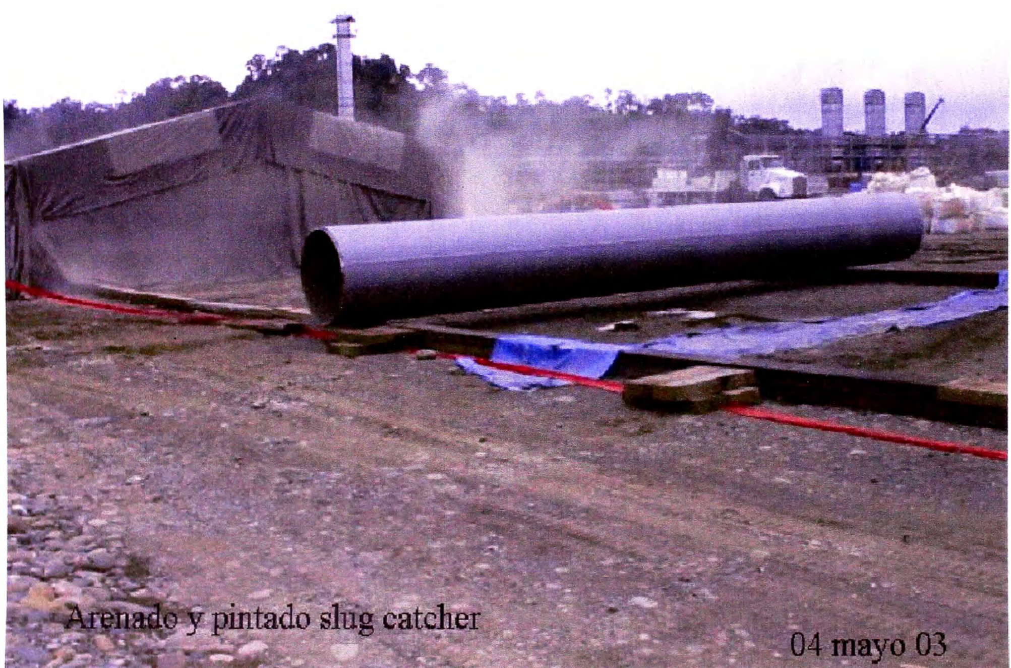
FIGURA 4.13 PREPARACION DE SUPERFICIE Y APLICACIÓN DE RECUBRIMIENTO ESQUEMA 1
