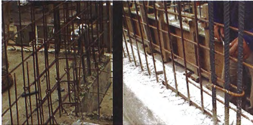
Figura N°5.- Refuerzo típico en muros empleando malla electrosoldada
