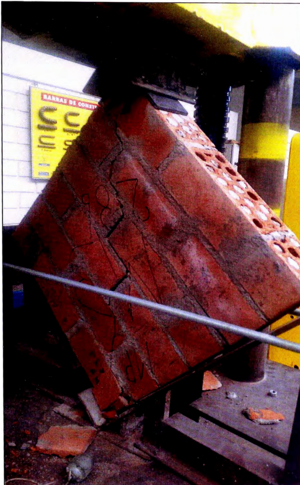
Anexo N° 15: MODO DE FALLA DE MURETE ELABORADO CON MORTERO PATRÓN.
