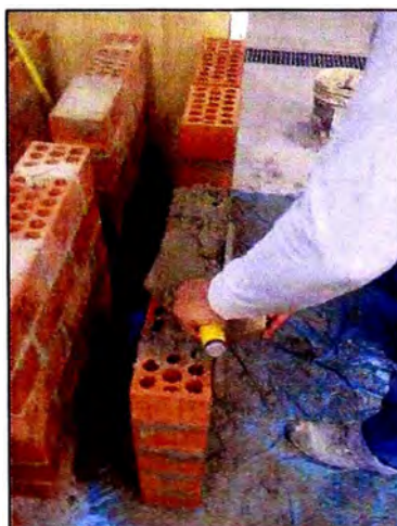
Figura N° 26: Elaboración de muretes de albañilería.
