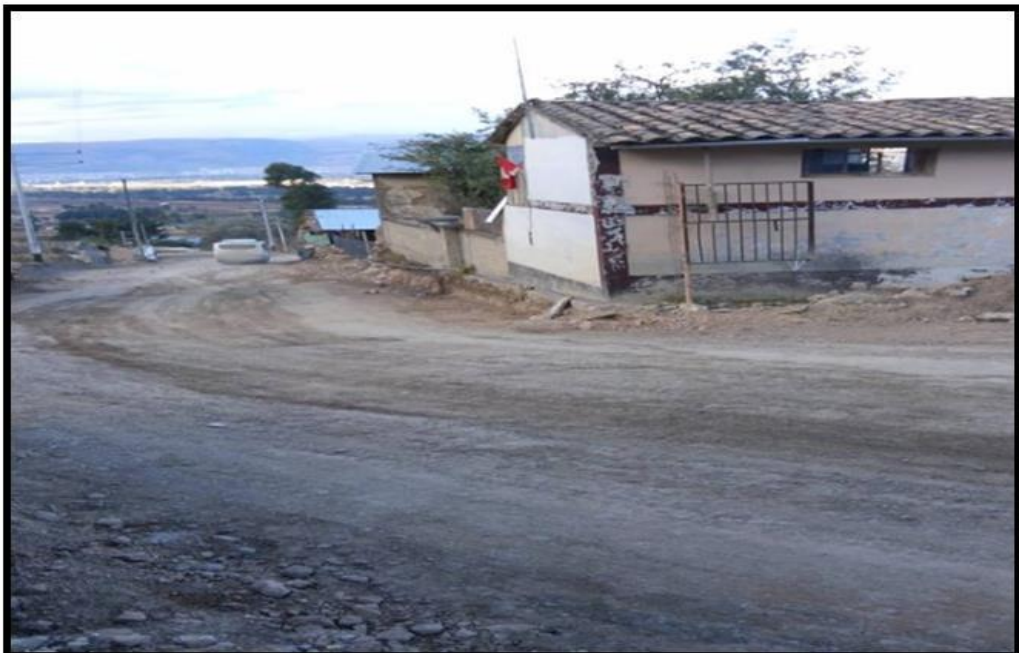
Foto 12: Estado de vía afirmada, cercana a la localidad de Vista Alegre.
