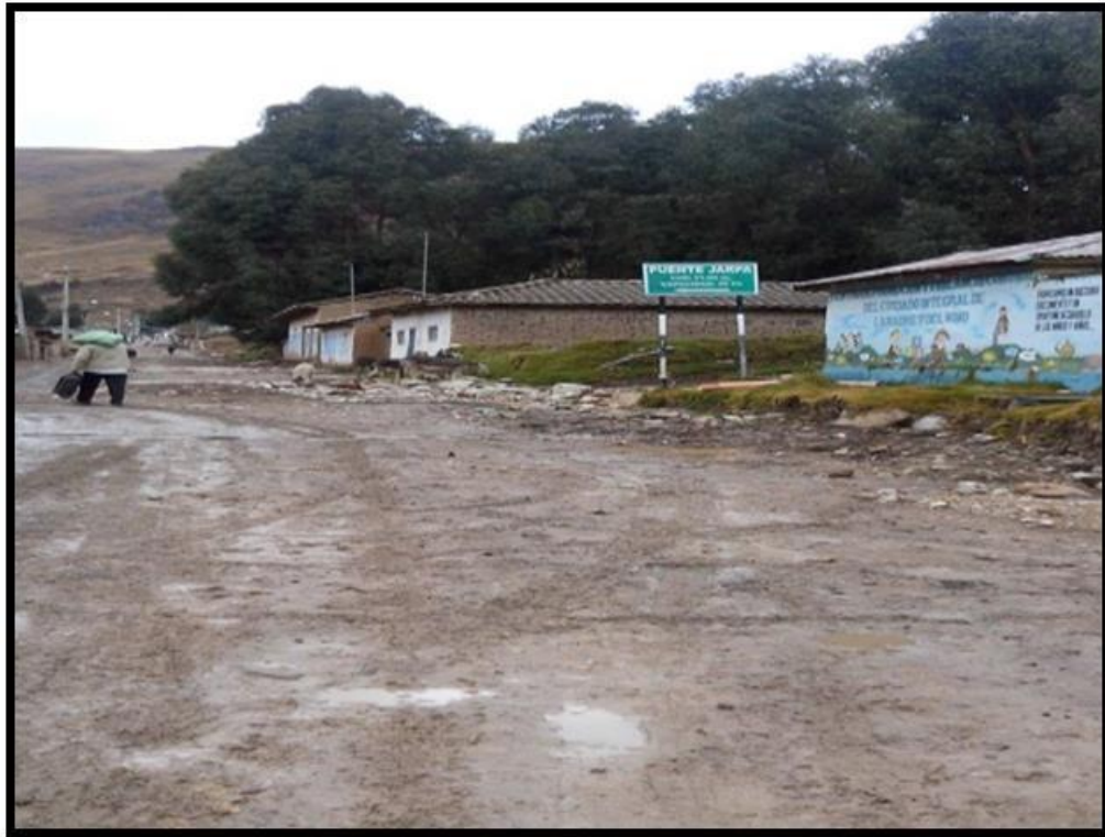
Foto 7: Se observa parte de la vía sin asfalto, en la localidad de San Juan de Jarpa
