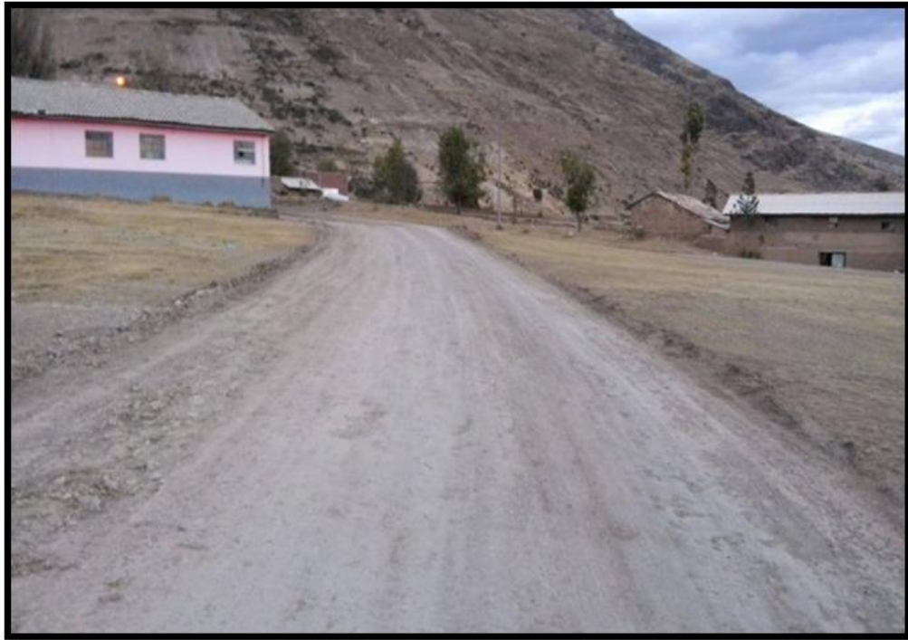
Foto 15: Se muestra la vía afirmada, no presenta señalizaciones.
