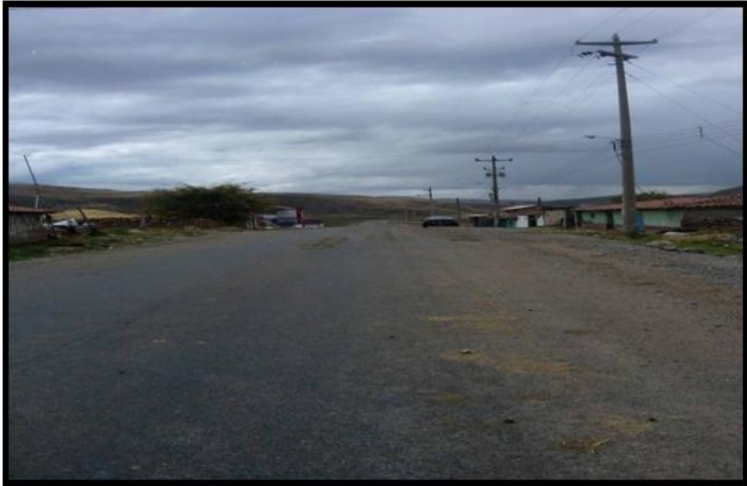
Foto 3: Se muestra parte de vía asfaltada camino a localidad de Misquipata.
