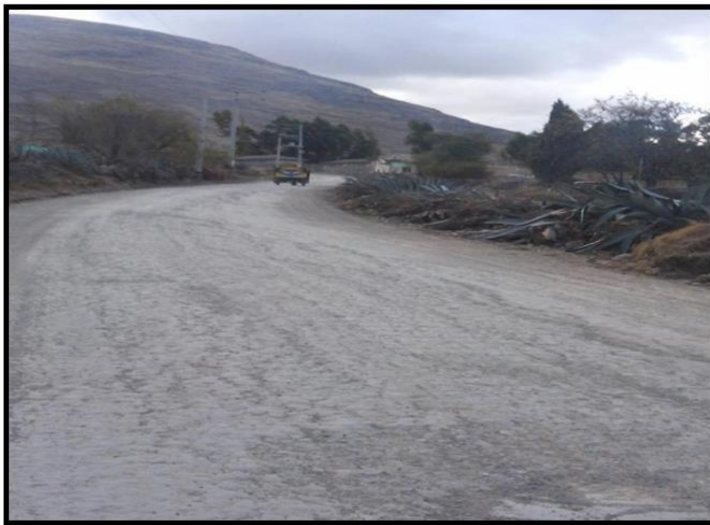
Foto 17: Se muestra la vía afirmada, sin señalizaciones.
