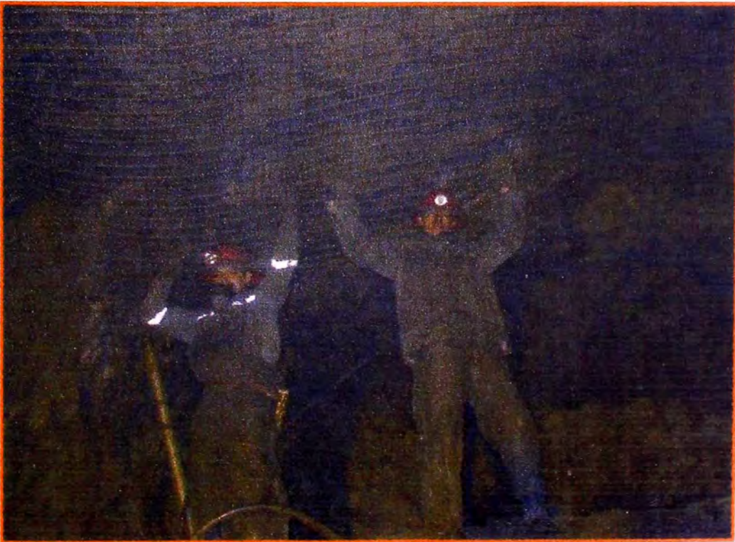
Fotografía N°2: Operarios colocando el enmallado en mina subterránea.
