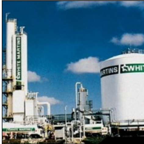
Figura N°7.1.- Miniplanta de licuefacción de GNL- Paulínia –Sao Paulo
