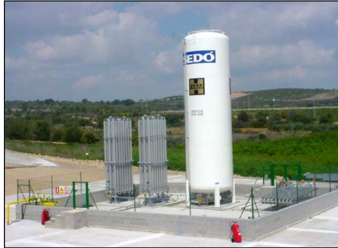
Figura N° 7.5.-Planta satélite de GNL
