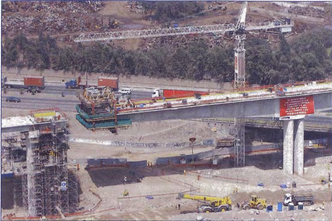
Foto 17 Ejecución Dovela 11 (Extremo)
