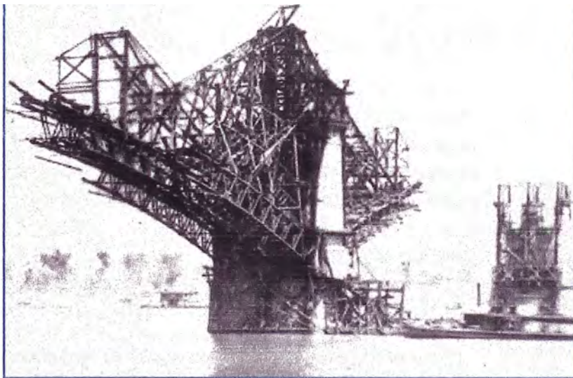
Figura 1.5 Construcción del Puente de San Luis
