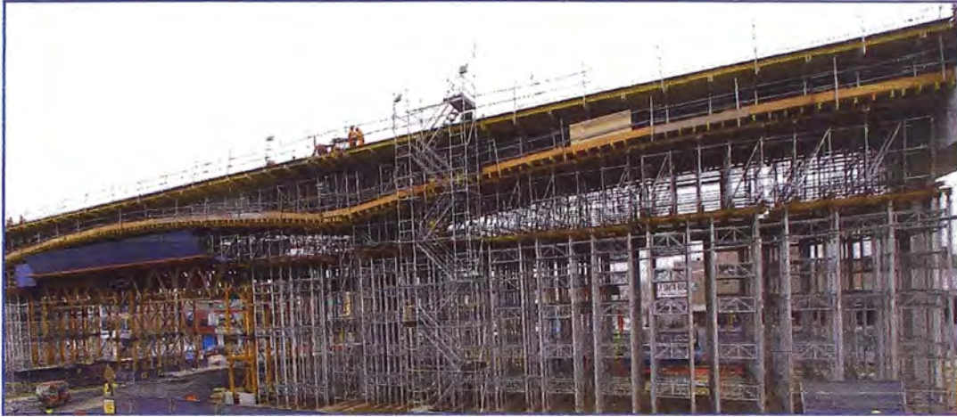
Figura 1.6 Proyecto "Metro de Lima" - Fuente: Archivo Ulma Encofrados Perú S.A.
