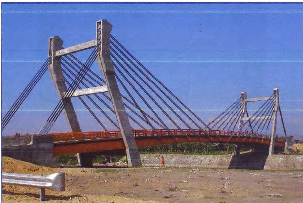
Figura 1.14 Puente Atumpampa - Tarapoto, San Martín
