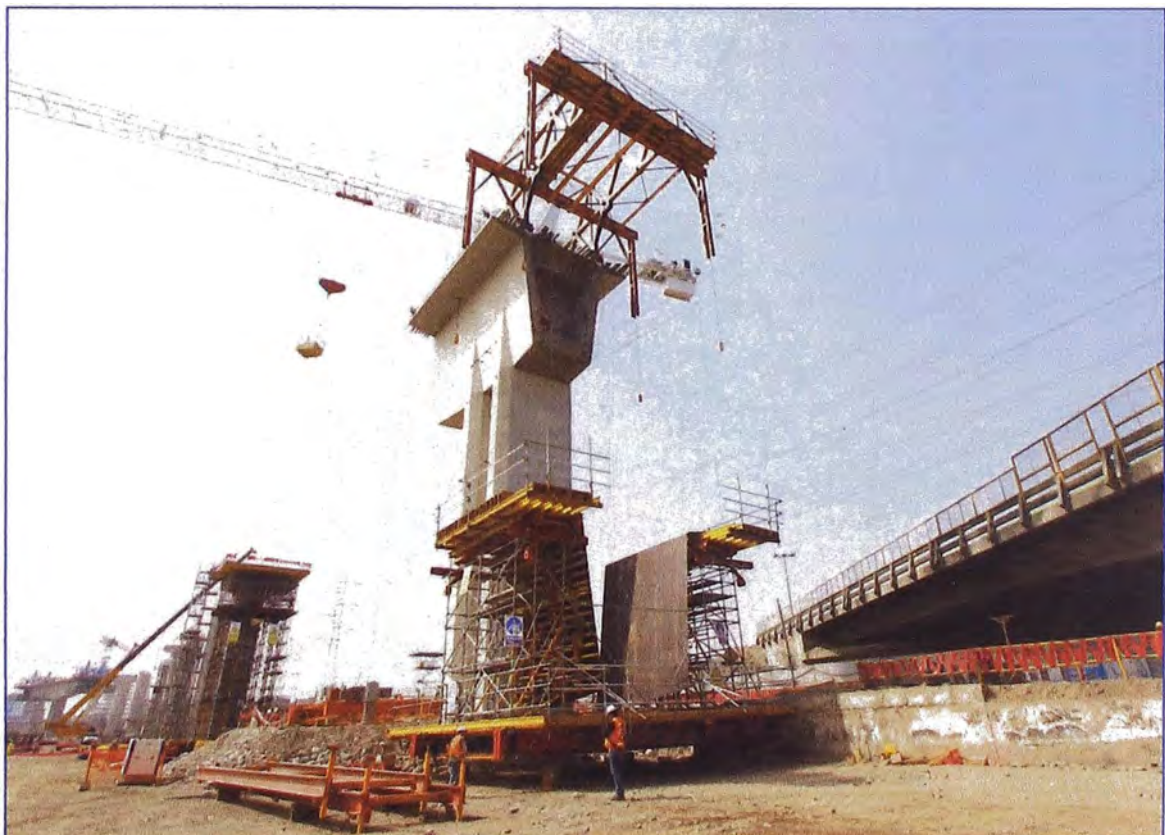
Foto 04 Presentación Encofrado Exterior y de fondo
