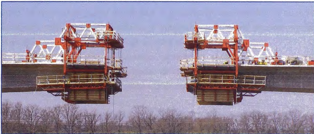
Figura 1.8 Puente Kobemi - Fuente: Archivo Ulma Encofrados Perú S.A.
