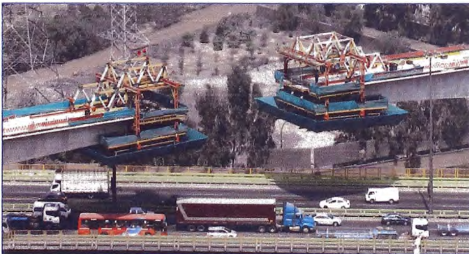
Figura 3.5 Ejecución de tramo central - Fuente: Ulma C y E, S. Coop.
