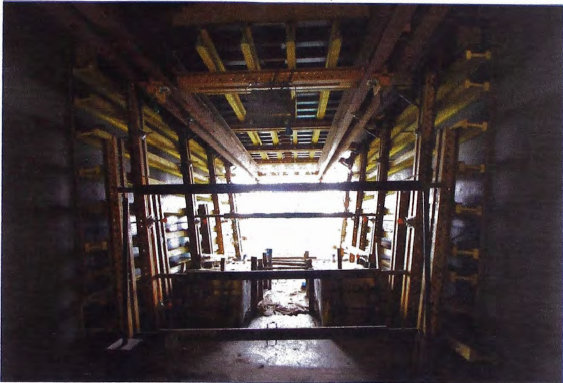
Foto 11 Vista Encofrado Interior
