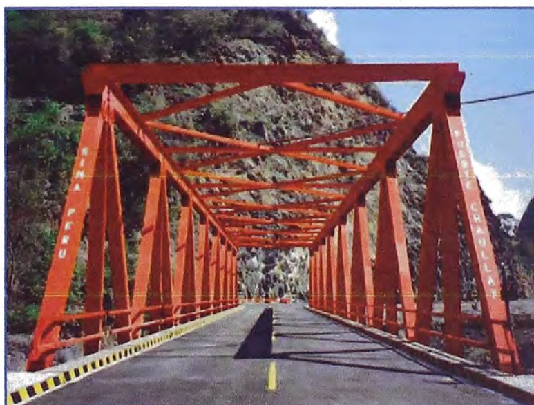
Figura 1.12 Puentes reticulado Chaullay - La Convención. Cusco
