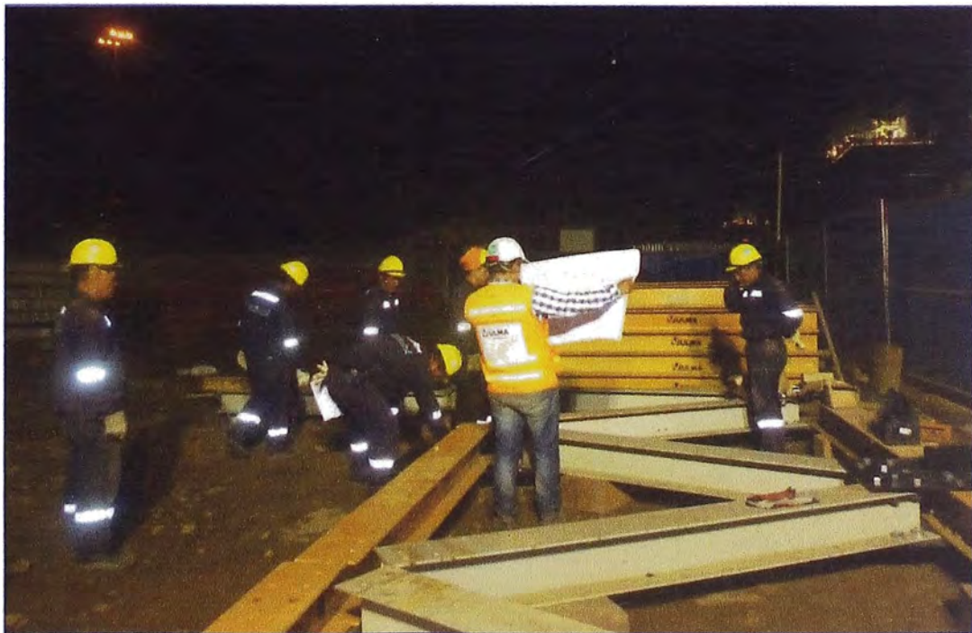
Foto 02 Pre montaje Estructura Principal
