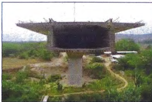
Figura 1.10 Puentes sección cajón de una celda
