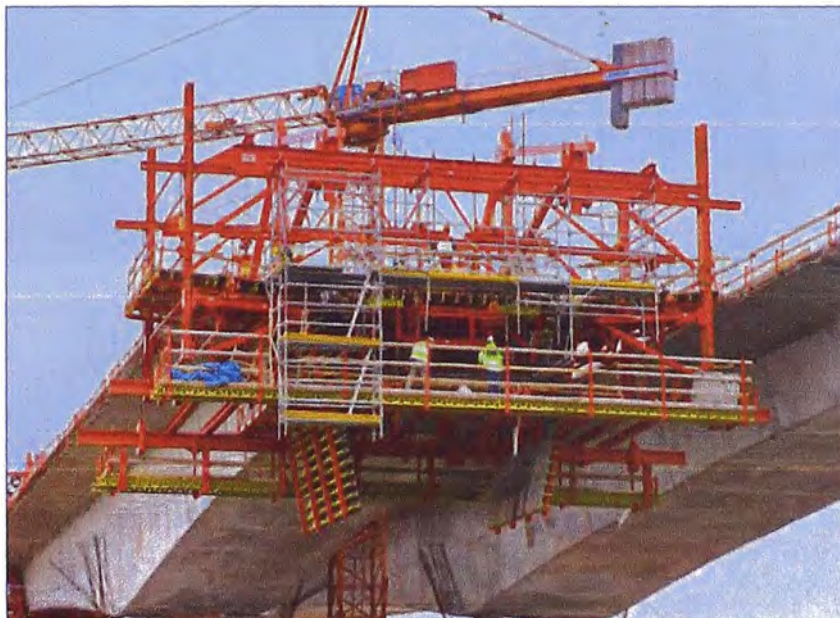
Figura 2.7 Carro de avance PERI - Fuente: www.peri.de
