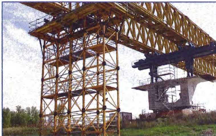
-- Figura 1.7 Vigas de Lanzamiento - Fuente: Archivo Ulma Encofrados Perú S.A.
