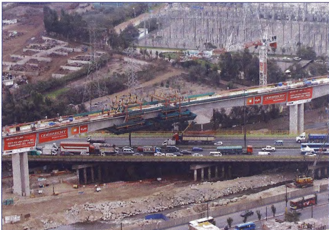
Foto 18 Ejecución Dovela de Cierre Central
