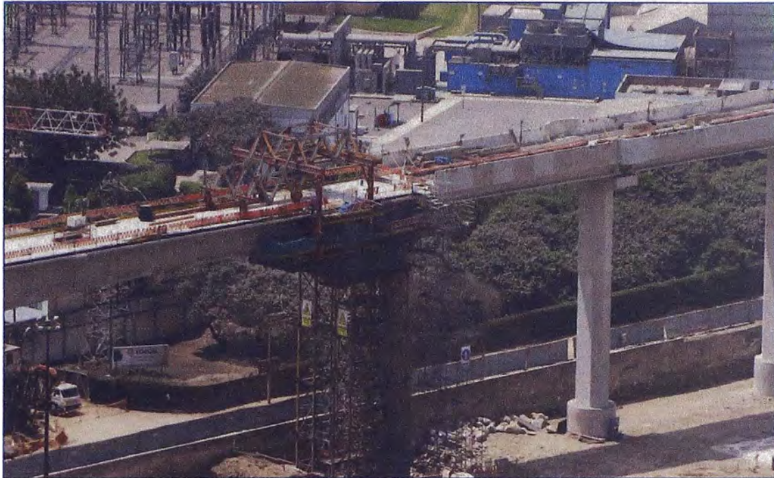
Foto 19 Ejecución Dovela de Cierre Extremo
