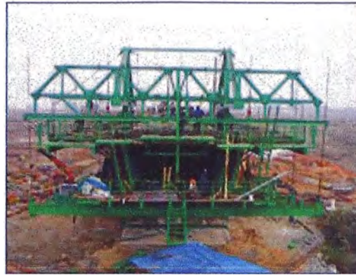
Figura 2.5 Carro de avance ALSINA - Fuente: www.alsina.com
