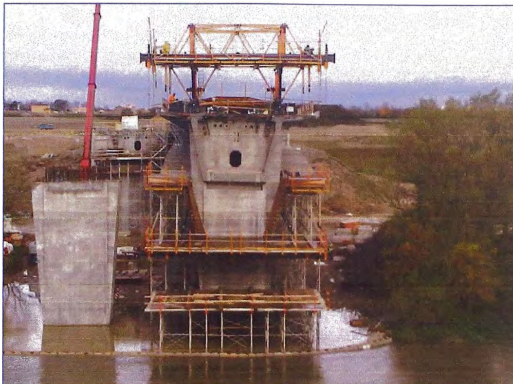
Figura 2.25 Proceso de izado del encofrado de fondo y exterior - Fuente: Ulma C y E, S. Coop
