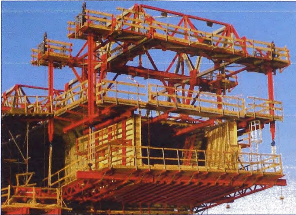
Figura 2.47 Encofrado de fondo y exterior - Fuente: Ulma C y E, S. Coop
