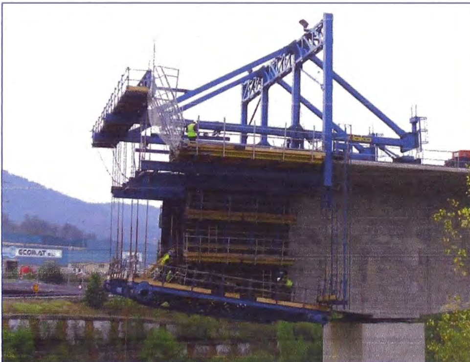
Figura 2.4 Carro de avance DOKA - Fuente: www.doka.com
