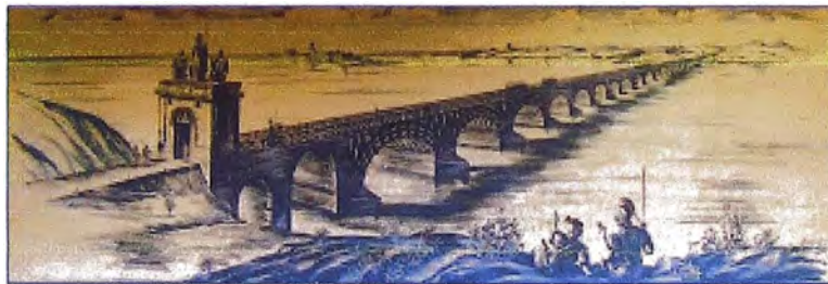
Figura 1.2 Puente romano de madera a través del Danubio
