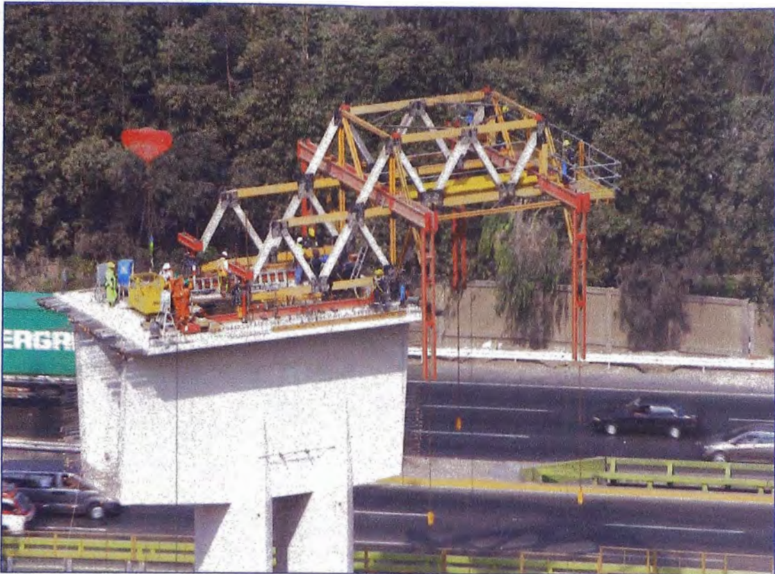
Foto 05 Estructura Principal en posición de inicio
