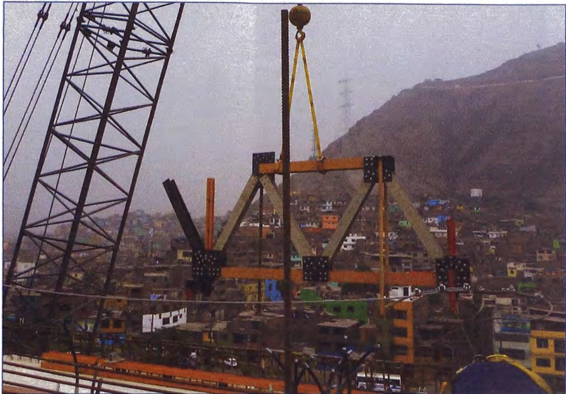
Foto 03 Izado Estructura Principal
