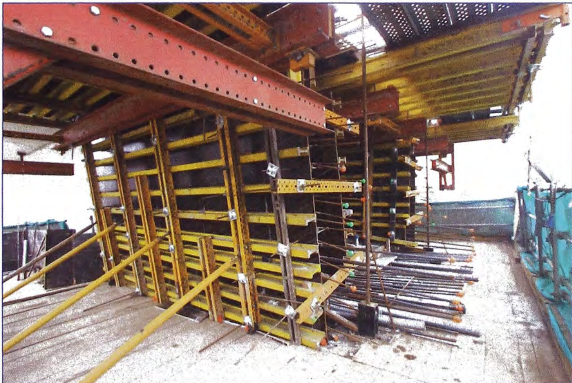
Foto 14 Vista Encofrado Exterior
