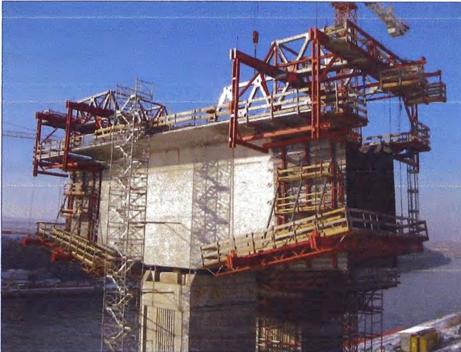
Figura 2.2 Ejecución Puente Koberni - Fuente: Ulma C y E, S. Coop.
