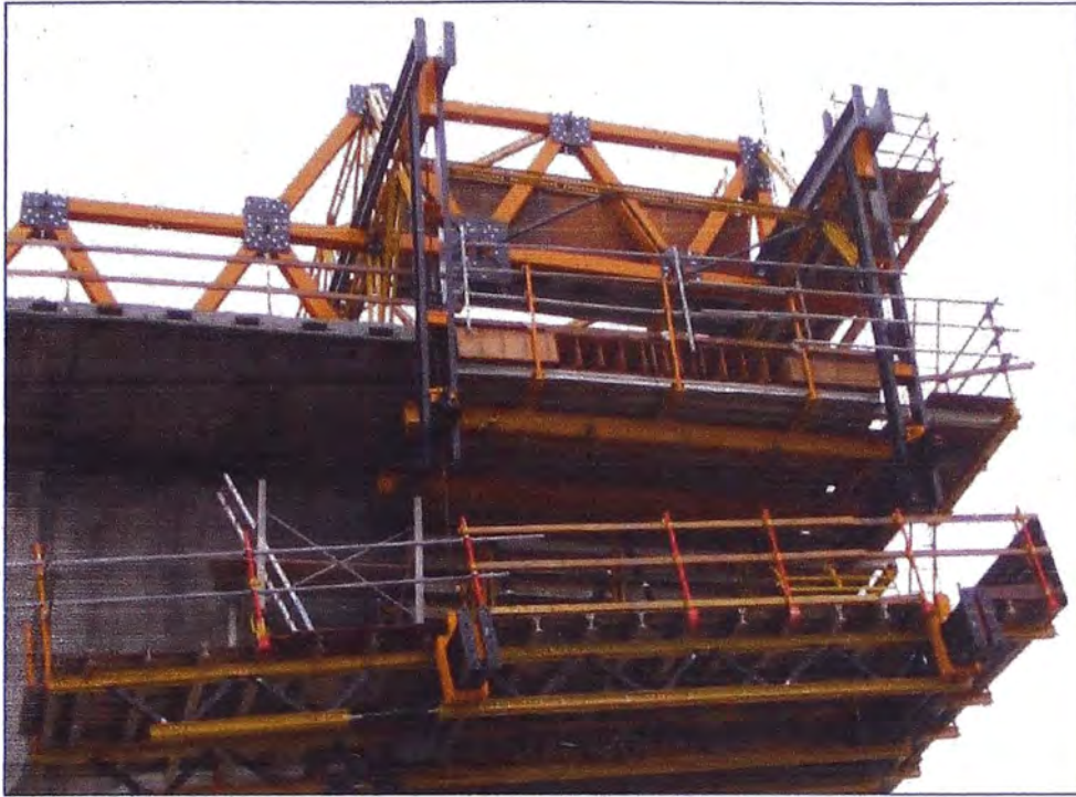
Figura 2.31 Montaje Completo del Carro de Avance - Fuente: Ulma C y E, S. Coop
