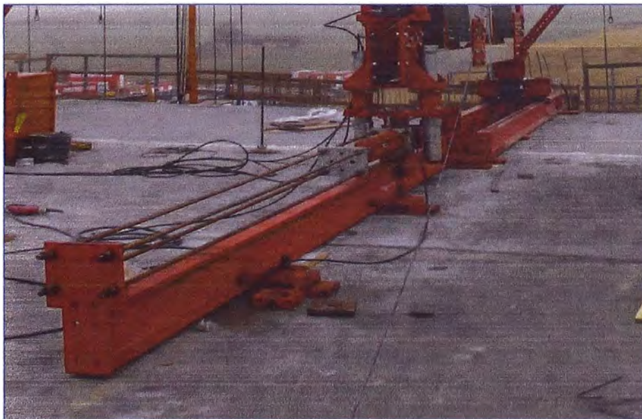
Figura 2.13 Carriles instalados sobre la dovela '0' - Fuente: Ulma C y E, S. Coop.
