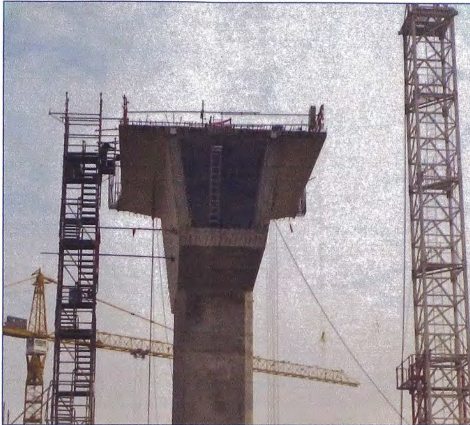
Foto 01 Dovela Cero - Eje O16
