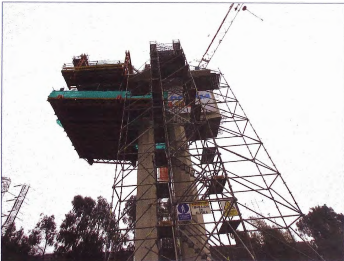
Foto 06 Escalera de Acceso a la Dovela Cero
