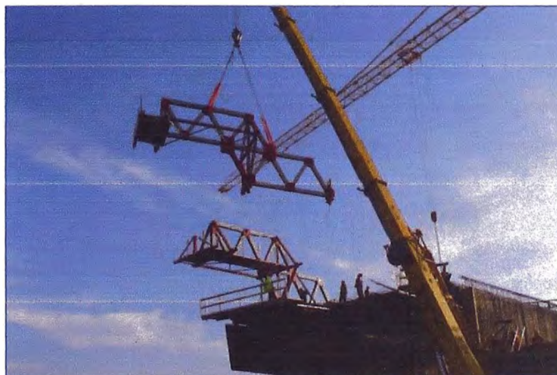
Figura 2.19 Izado de la Estructura Principal - Fuente: Ulma C y E, S. Coop.
