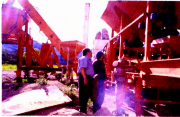
Foto 3.48 Identificación de los puntos de inspección de las tolvas y faja transportadora de agregados de la planta CIBER ubicada en Cajamarca
