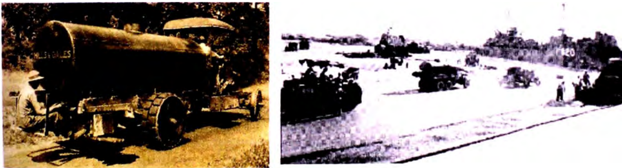
Foto 1.10 Proceso sencillo de distribución del asfalto
