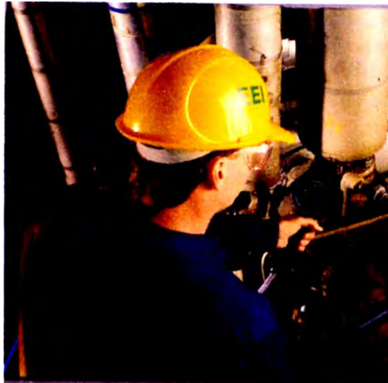
Foto 3.73 Las inspecciones a cada una de las partes y componentes de la planta de asfalto deben realizarse según lo establecido en los y procedimientos y manuales del fabricante
