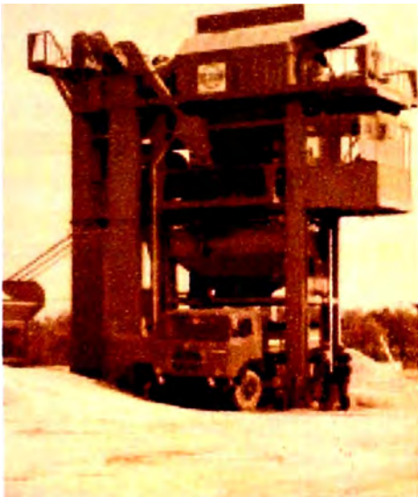
Figura 1.59 Batch plant de los años 1,950
