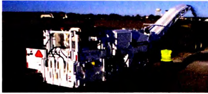
Foto 4.109 Fresadora RX 400 de ROADTEC cortando pavimento asfáltico antiguo
