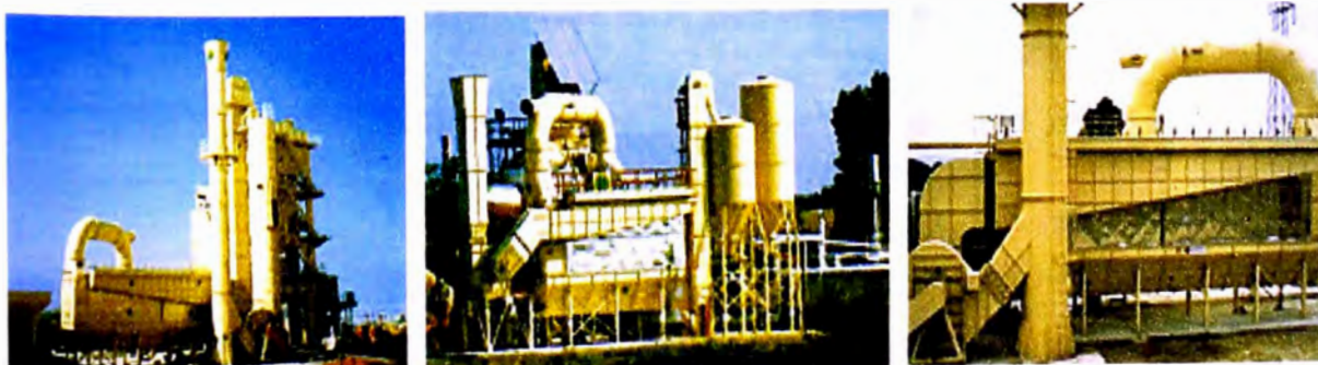
Foto 1.77 Filtro de mangas
