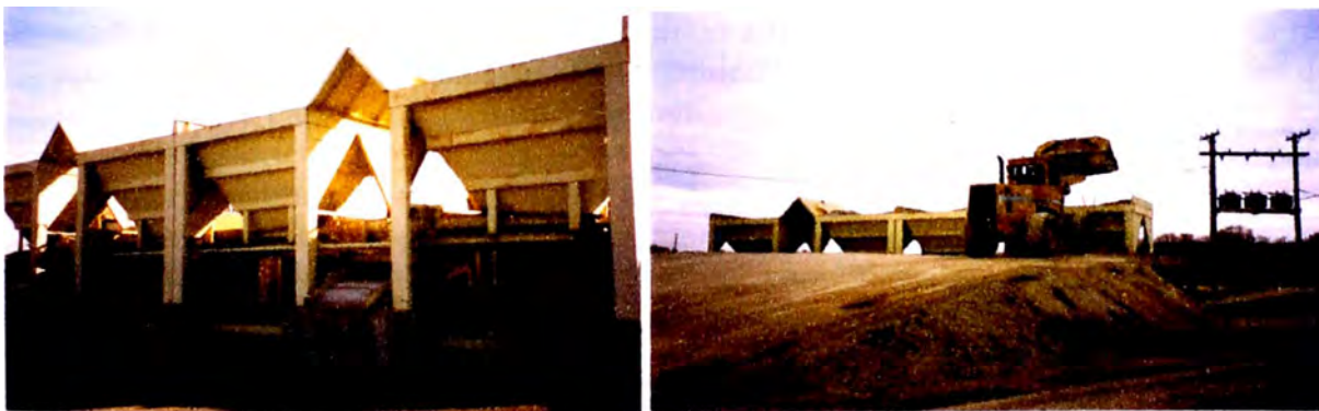
Foto 3.32 Tolvas para agregados vírgenes alimentadas con cargador frontal
