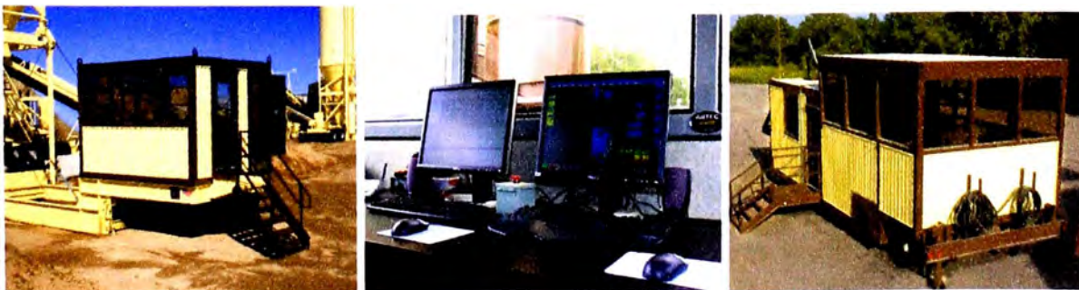
Figura 4.100 Cabina o sala de control
