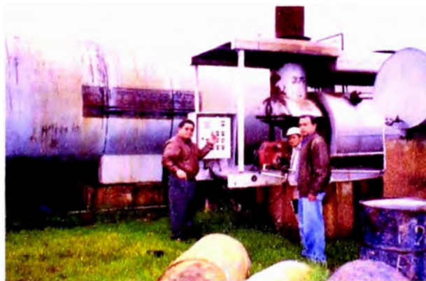
Foto 3.50 Identificación de los puntos de inspección del tanque de asfalto de la planta CIBER ubicada en Cajamarca. Ing Hugo Miranda, Sr Pastor Caro e Ing Juan Felipe Diaz TESIS "PROYECTO DE INGENIERÍA DE UNA PLANTA DE ASFALTO EN CALIENTE CON TECNOLOGÍA DE ÚLTIMA GENERACIÓN"
