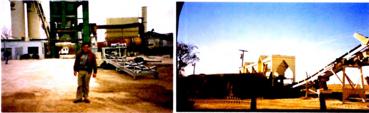
Figura 3.33 Montaje de tolvas para agregados vírgenes y faja transportadora en la planta de asfalto Almix Ubicada en Indiana EUA
