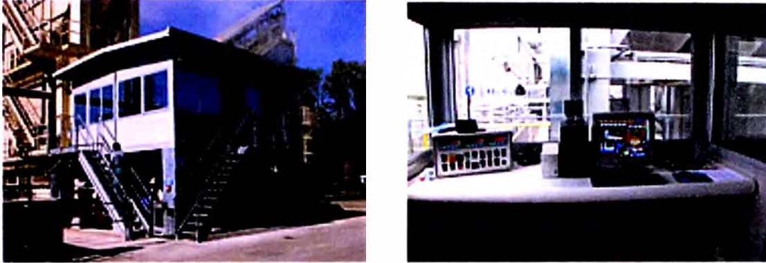
Foto 1.89 Cabina de control
