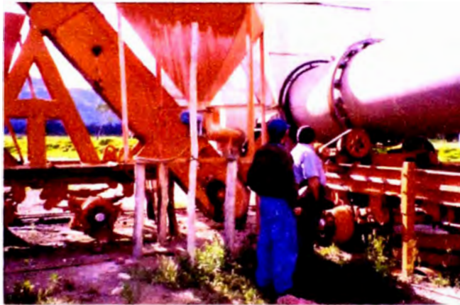
Foto 3.49 Identificación de los puntos de inspección del tambor mezclador de la planta CIBER ubicada en Cajamarca
