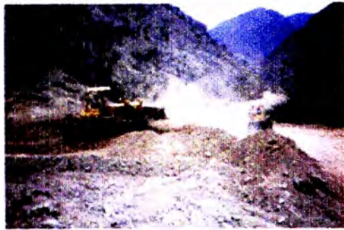
Extracción y Acumulación de Materiales
