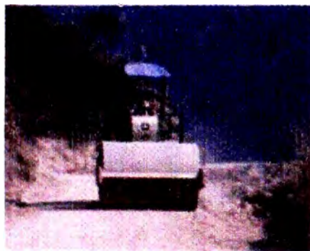
Compactación de la plataforma
