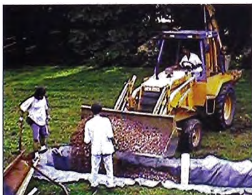
Fotografía N°2.4.- (Derecha) Construcción de una trinchera de infiltración (Izquierda)
