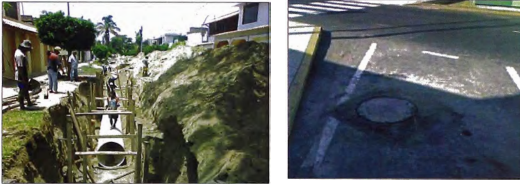
Fotografía N°2.3. - (Derecha) Colocación de tuberías colectoras de drenaje pluvial (Izquierda) Buzón de registro en vía
