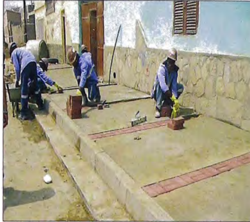
Fotografía N°2.1.- Construcción de una Cuneta de concreto – Lobito – Angola
