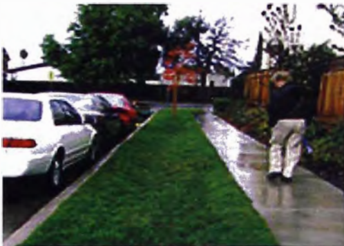
Fotografía N°2.5.- (Derecha) Manto de infiltración al borde de vía (Izquierda) Características de un manto de infiltración
