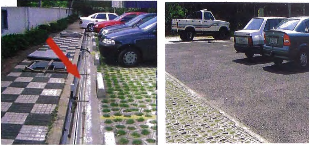
Fotografía N°2.7. - (Derecha) Bloques huecos en un estacionamiento (Izquierda) Pavimento poroso en un estacionamiento
