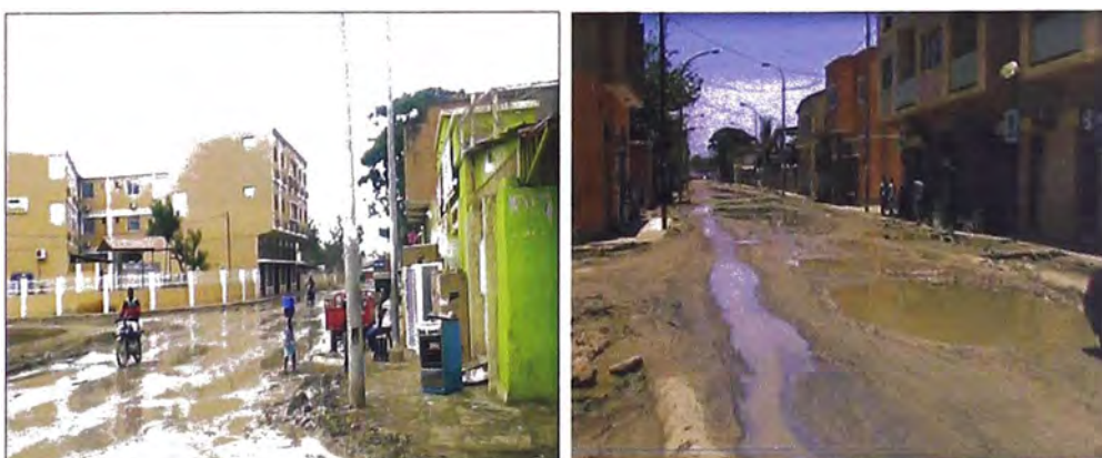
Fotografía N°4.2.- Calle de los Aliados – barrio de Sumbe
