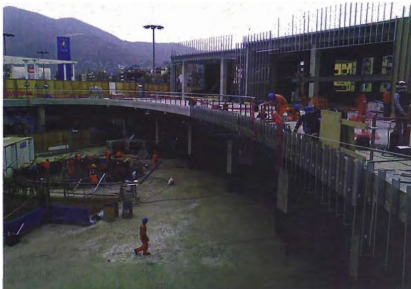
Figura N°4.12.- Cerramiento de fachada de Chuck E. Cheese's
