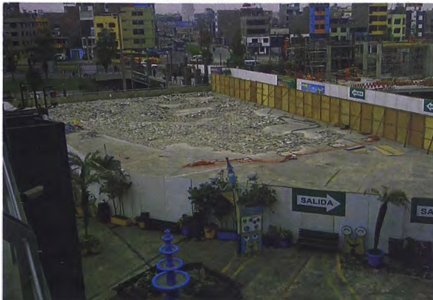
Figura N°4.11.- Demolición del techo de Chuck E. Cheese's
