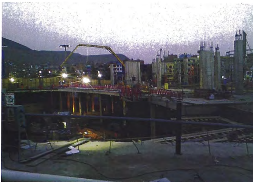
Figura N°4.13.- Vaciado de piso en techo de Chuck E. Cheese's
