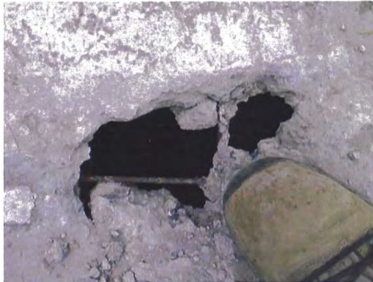
Figura N°4.7.- Perforación de techo de locatario
