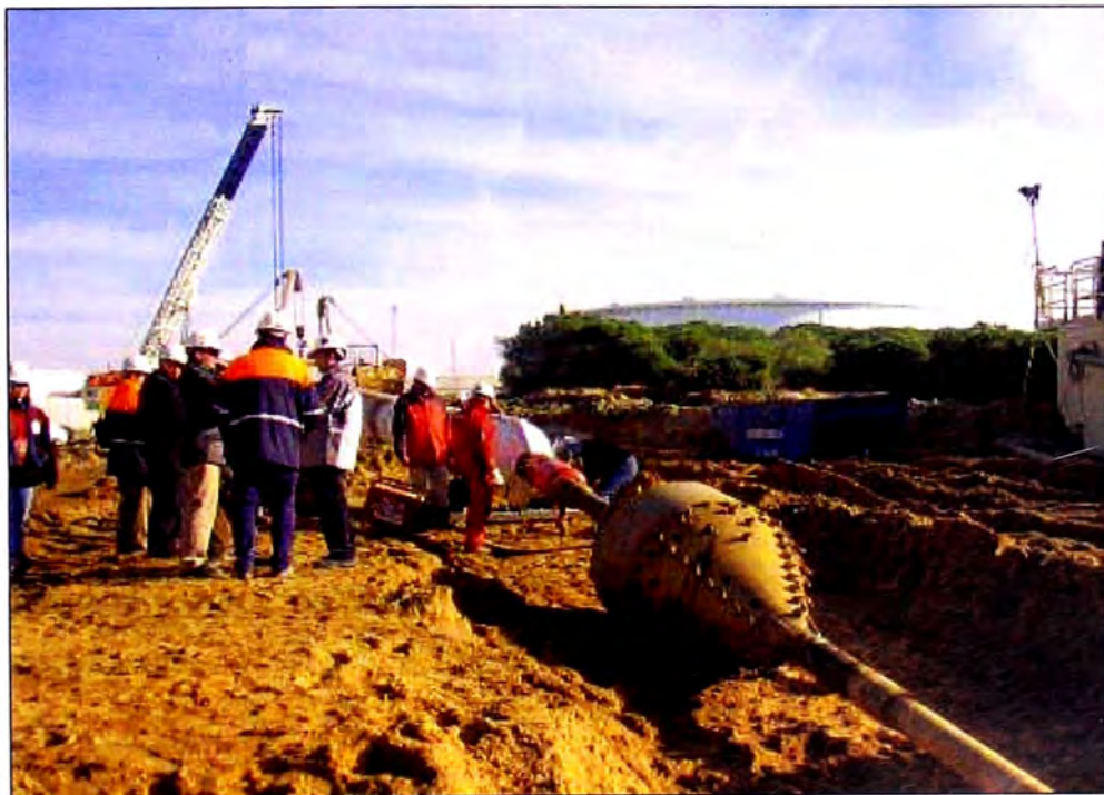
Figura N°4.4.- Instalación de la tubería producto.
