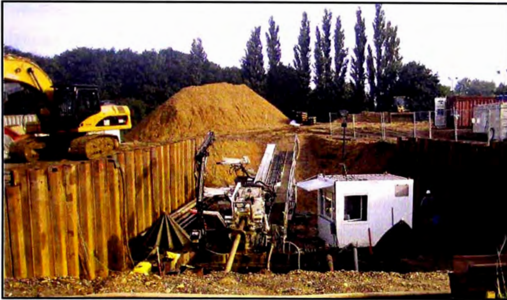
Figura N°1.3.- Montaje típico del equipo de PHD.
