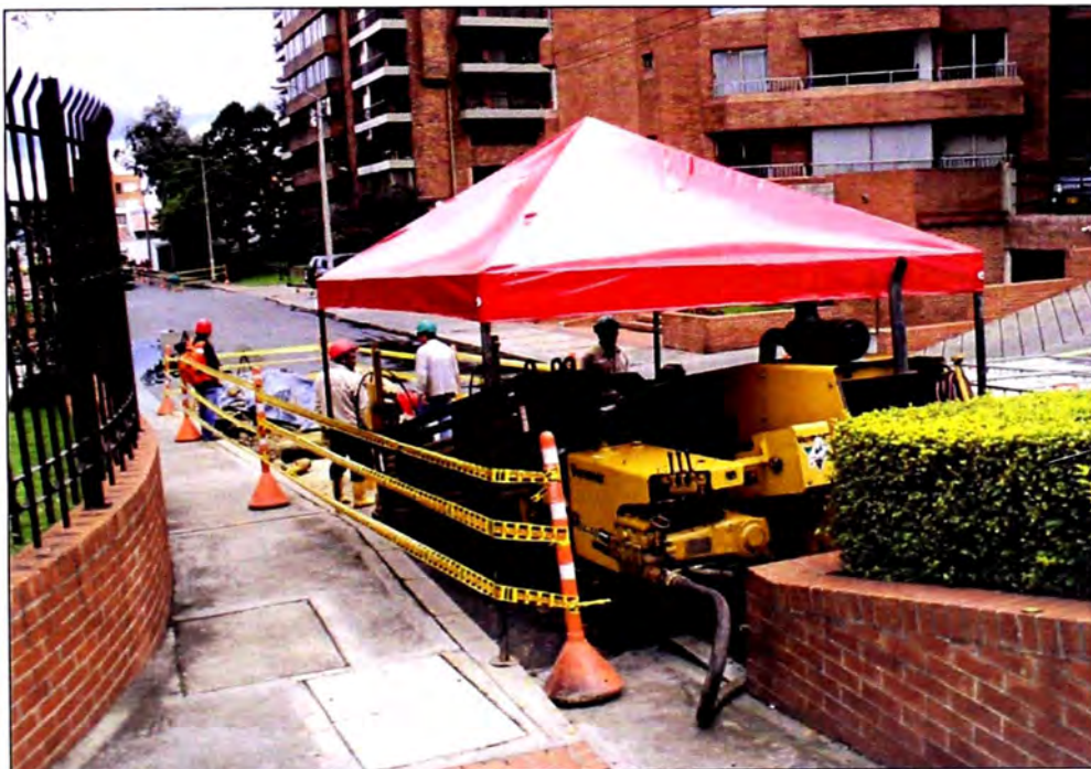
Figura N°5.4.- Obreros realizando la Perforación Horizontal Dirigida.
