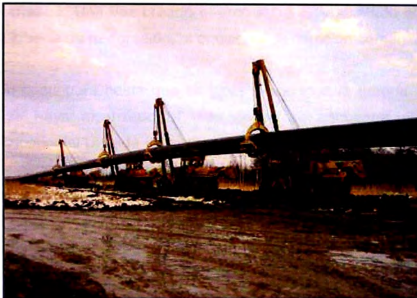
Figura N°4.2.- Creación del arco superior usando tiende tubos.
