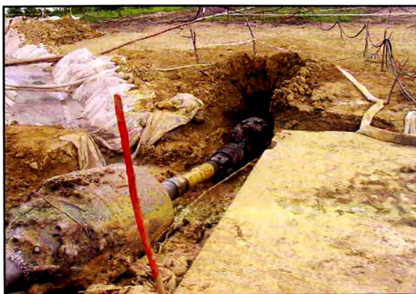
Figura N°4.3.- Inserción con escariador de barril, eje giratorio y cabezal de arrastre.
