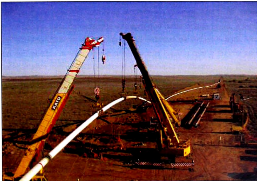
Figura N°4.1.- Creación del arco superior usando grúas.
