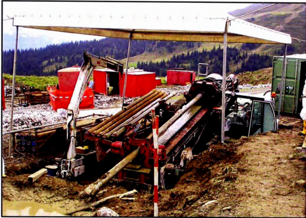
Figura N°5.2.- Perforadora de 100t de fuerza en obra.
