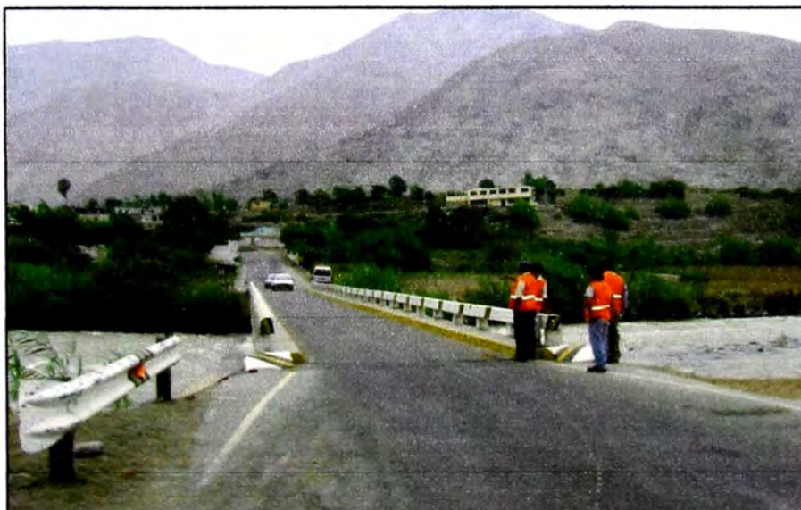
Figura 15.- Vista actual del puente Jita
