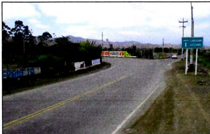
Figura 11.- Zona de futura intersección
