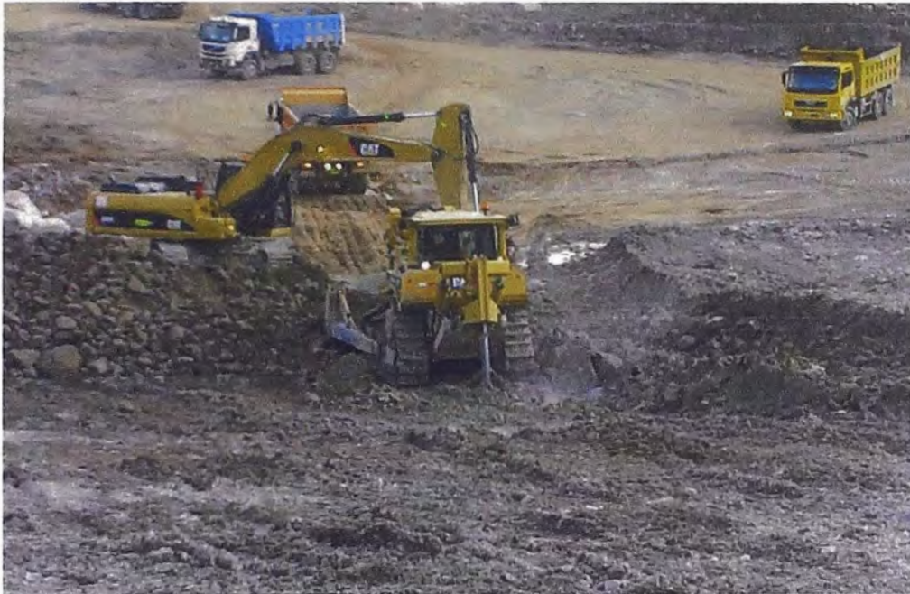
Figura N° 35.- Situación encontrada en campo de carguío con excavadora en roca blanda removida por Tractor Buldózer
