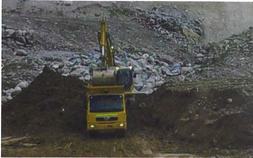
Figura N° 52.- Situación Implementada - Excavadora en terreno saturado
