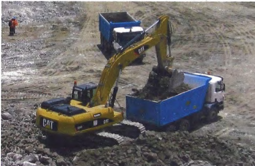
Figura N° 58.- Situación Implementada para excavadora en terreno de roca blanda removida por Tractor Buldózer
