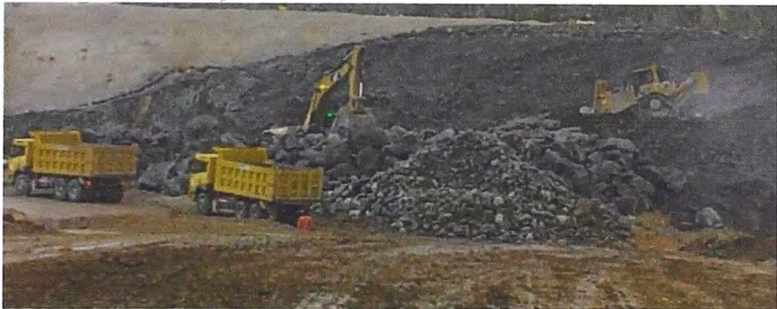
Figura N° 33.- Situación encontrada de excavadora en terreno de roca fragmentada por voladura
