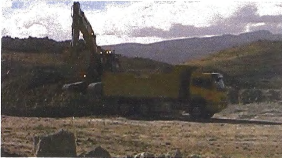
Figura N° 54.- Situación Implementada para excavadora en terreno no saturado
