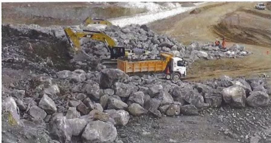
Figura N° 56.- Situación Implementada para excavadora en roca por voladura
