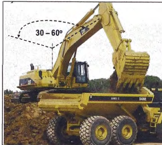
Figura N° 48.- Ángulo de giro óptimo de la excavadora en carguío
