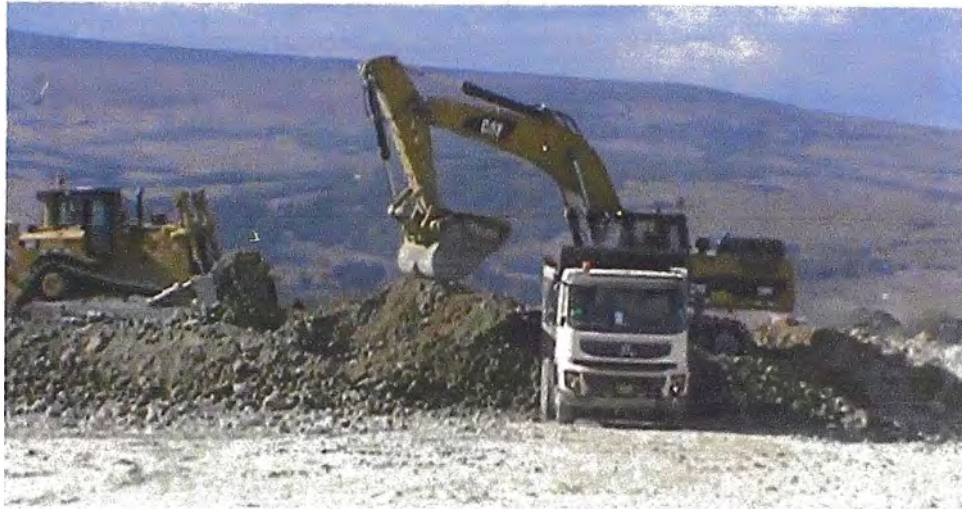
Figura N° 31- Situación encontrada de excavadora en terreno no saturado
