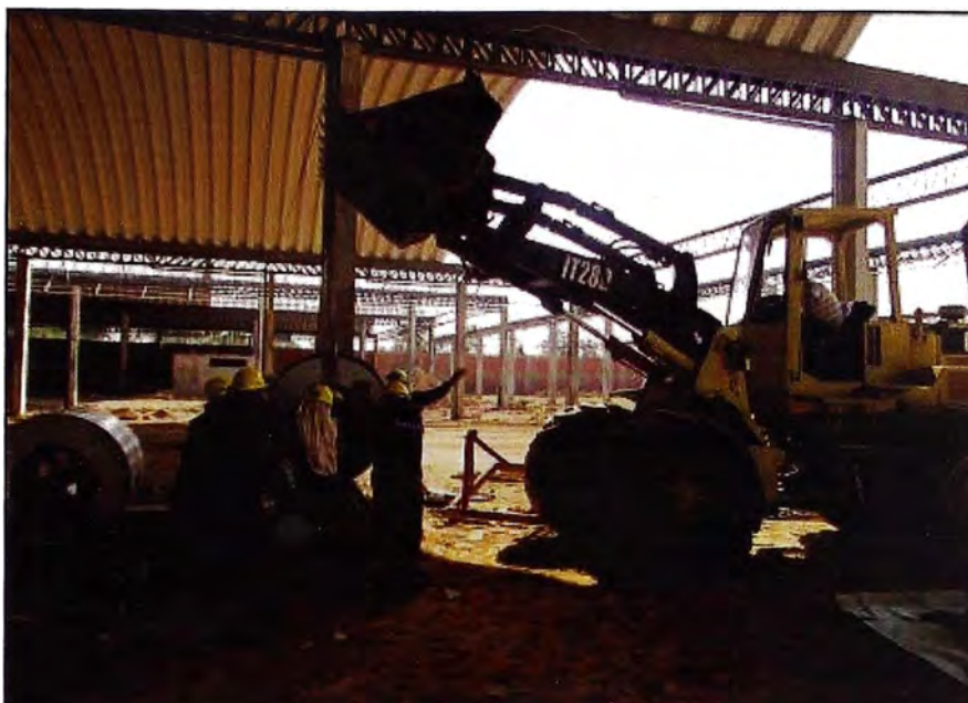
Figura 28. Colocación de las bobinas por medio de un cargador frontal.
