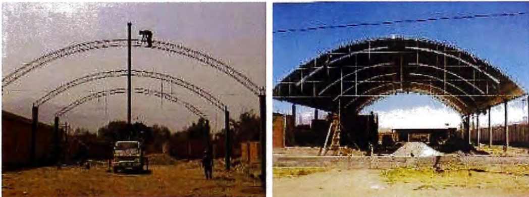
Figura 2. Techo industrial con techo curvo.
