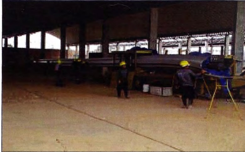
Figura 30. Vista de la salida del perfil ya rolado y con la curvatura determinada.
