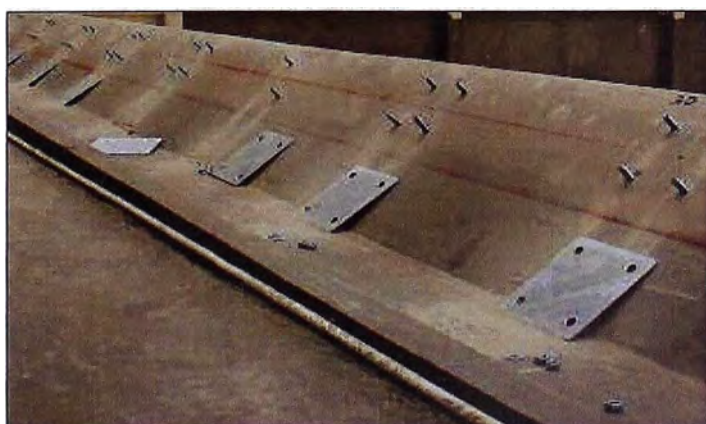
Figura 35. Vista de la colocación de pernos de anclaje en la viga.
