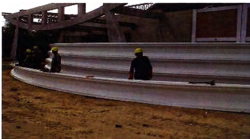
Figura 34. Vista del momento donde se superpone un arco encima del otro para empezar a sellarlo.
