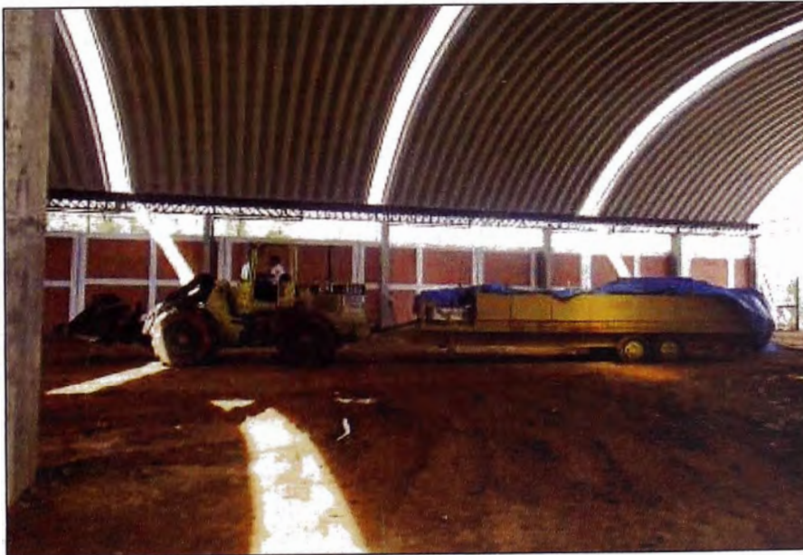
Figura 25. Instalacion de la maquina conformadora con ayuda de un cargador frontal.
