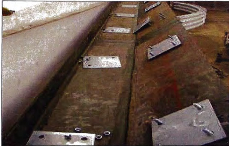
Figura 36. Vista de la colocación de placas sobre los pernos de anclaje.
