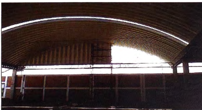
Figura 40. Vista de la colocación del tímpano frontal.
