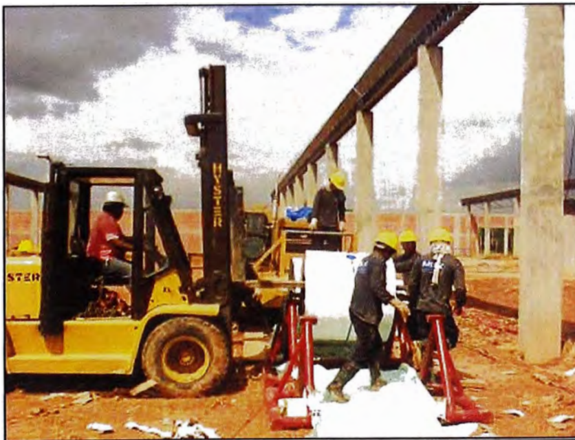
Figura 27. Colocación de las bobinas por medio de un montacargas.
