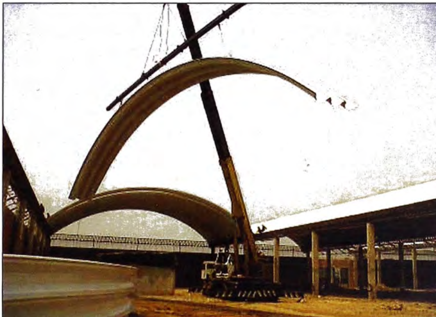
Figura 37. Vista del montaje de una terceta sobre la viga canal.
