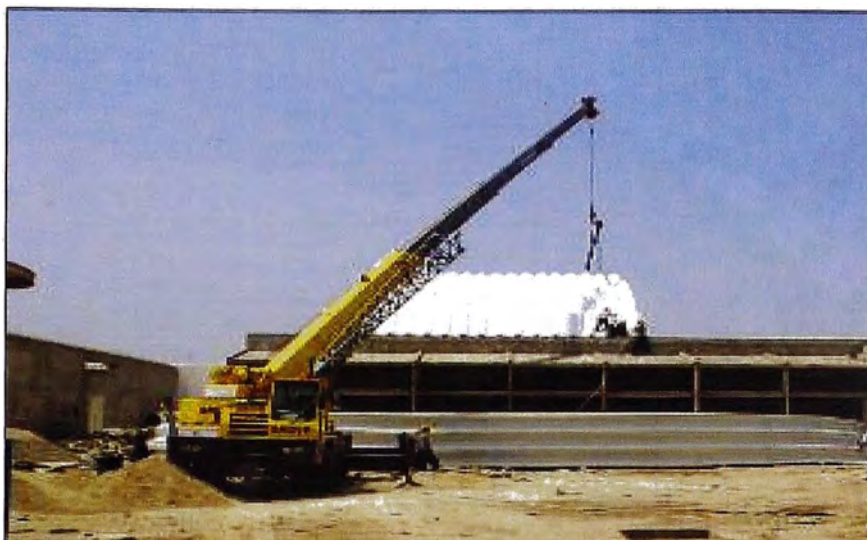
Figura 38. Vista de la recepción y colocación de la terceta en el techo.
