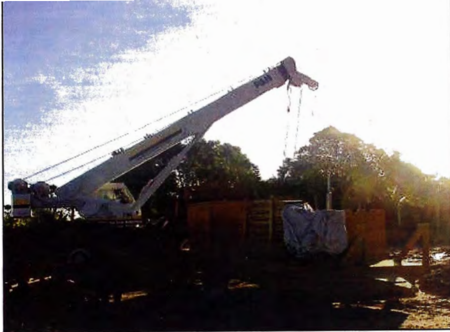
Figura 24. instalacion de la maquina conformadora por medio de una grúa.
