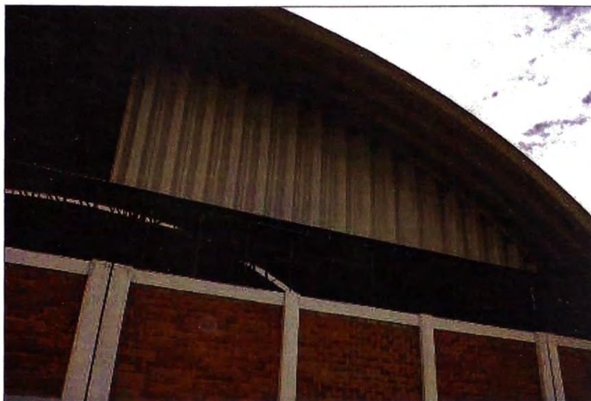
Figura 41. Vista de la colocación del tímpano frontal.
