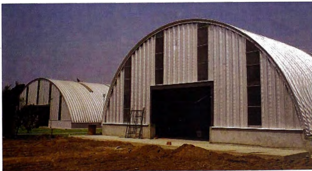
Figura 5. Aplicación en la industria de un techo Auto soportado tipo Semicircular.
