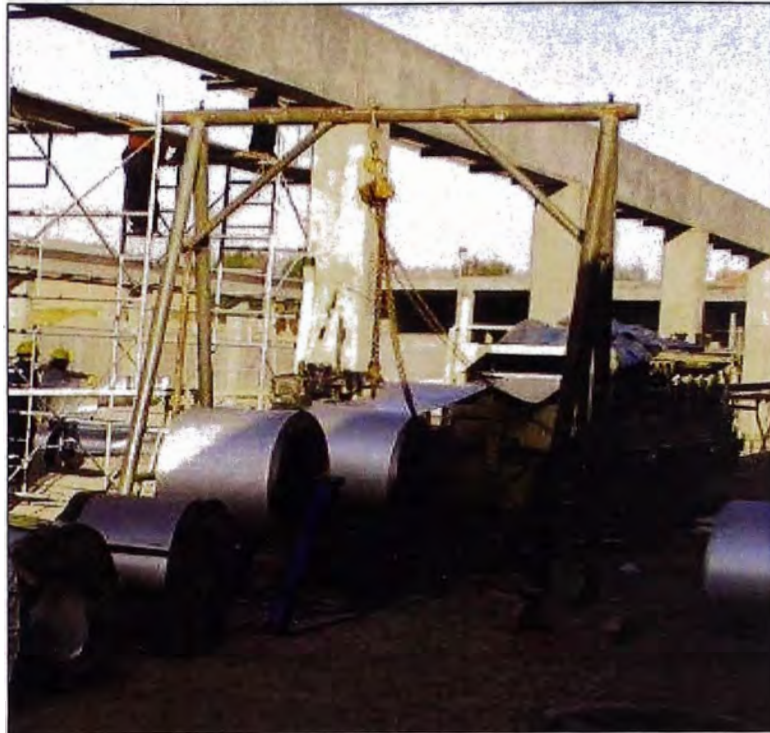
Figura 26. Colocación de las bobinas por medio del tecele.
