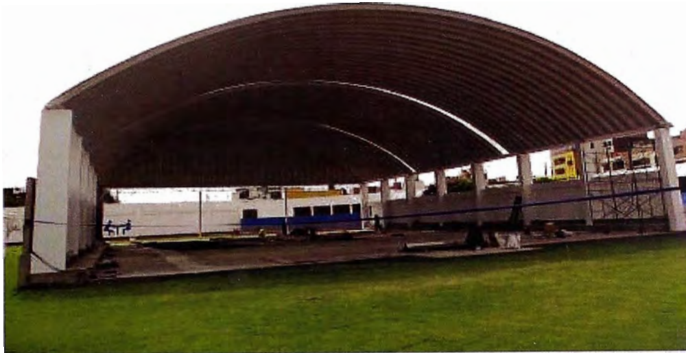
Figura 4. Aplicación en la industria de un techo Auto soportado tipo membrana.
