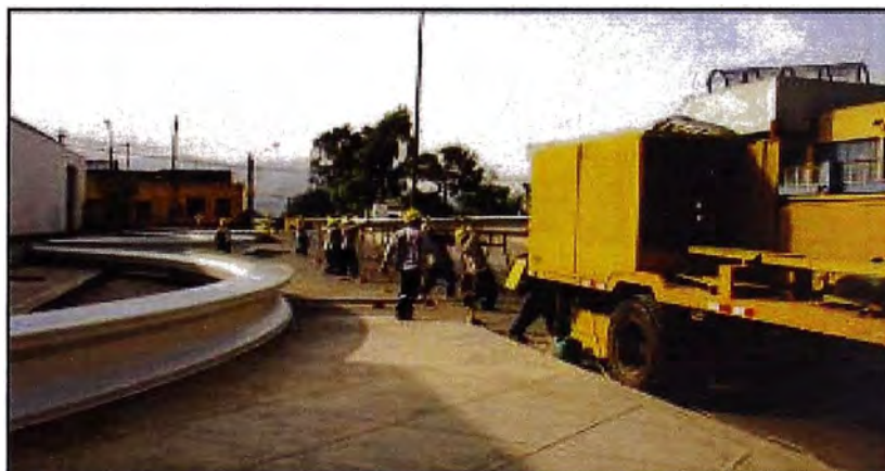
Figura 29. Vista del ingreso del perfil a la maquina conformadora.
