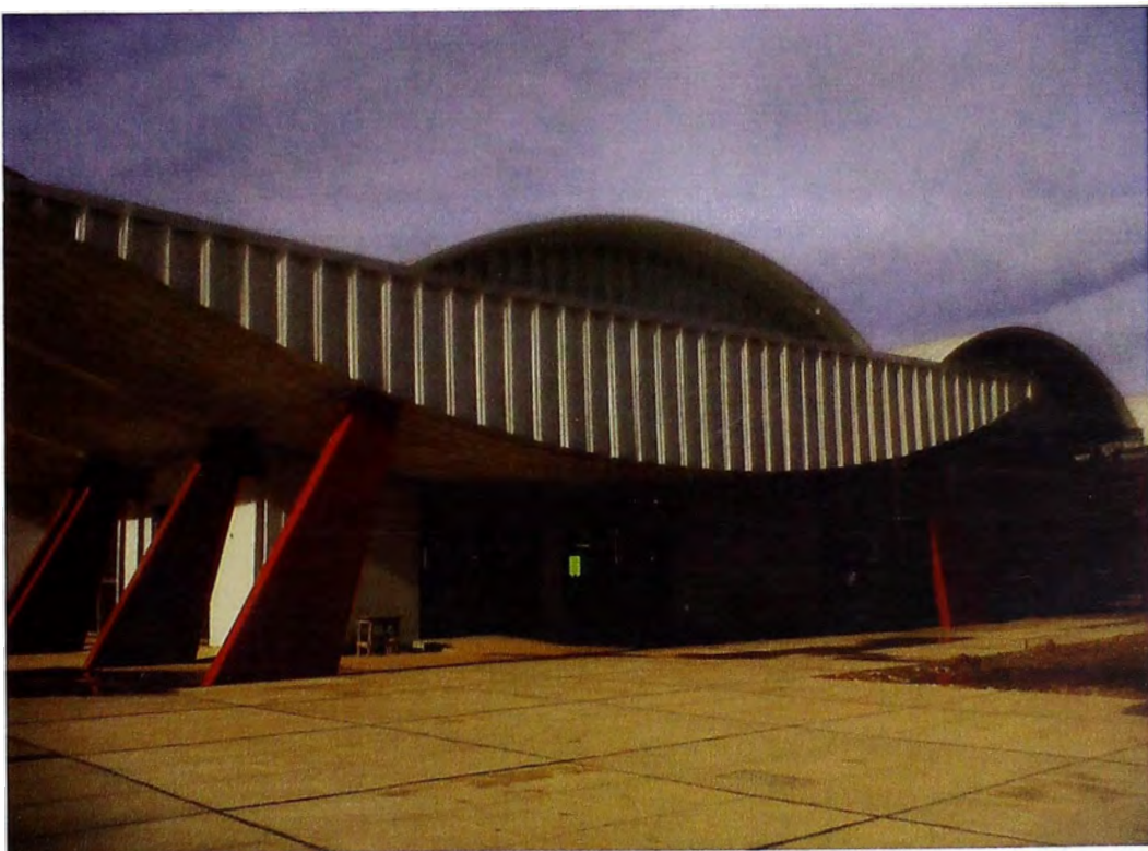
Figura 7. Aplicación en la industria de un techo membrana invertido.
