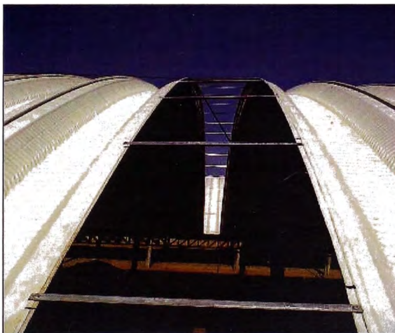
Figura 42. Vista de la colocación de los ángulos donde descansan las planchas translúcidas.
