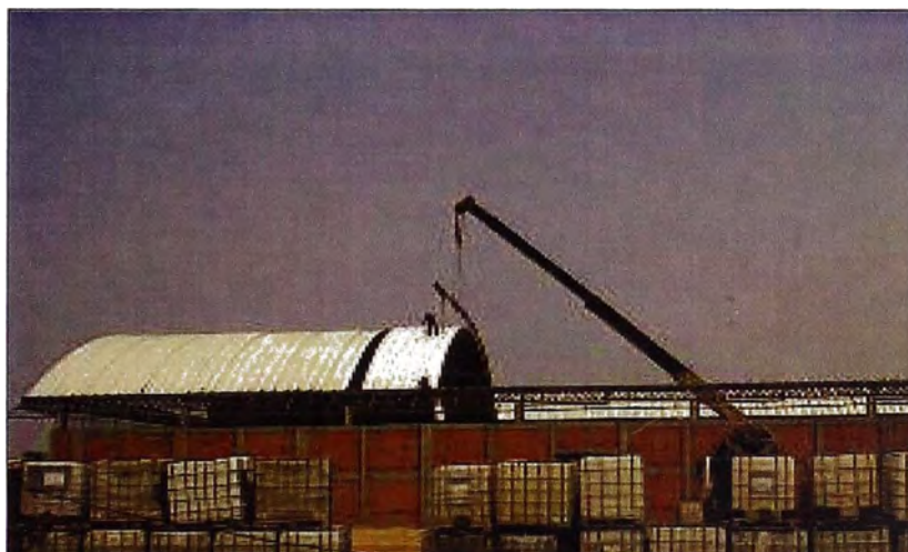
Figura 39. Vista de la recepción y colocación de la terceta en el techo.
