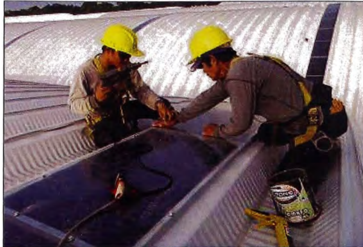
Figura 43. Vista de la colocación de los ángulos donde descansan las planchas traslucidas.
