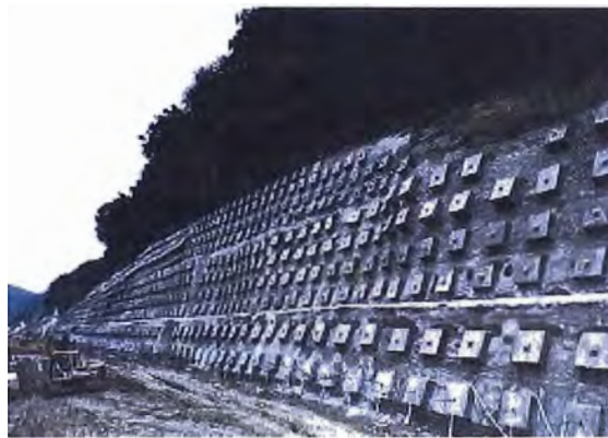
FIGURA N° 2.1. Pernos Anclados
