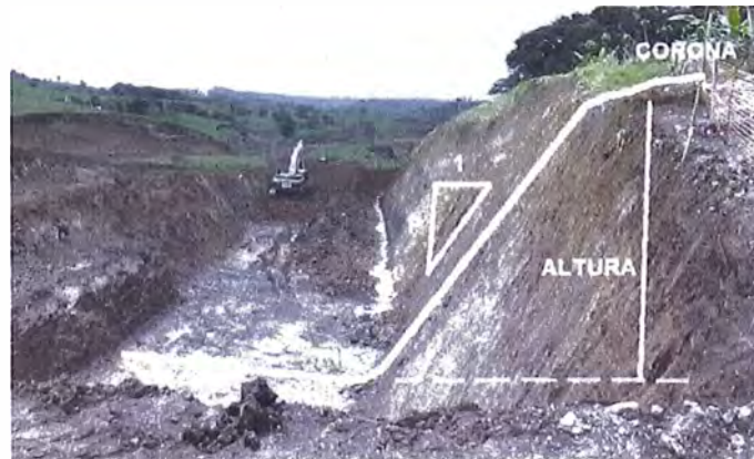
FIGURA N° 1.1. Partes de un Talud
