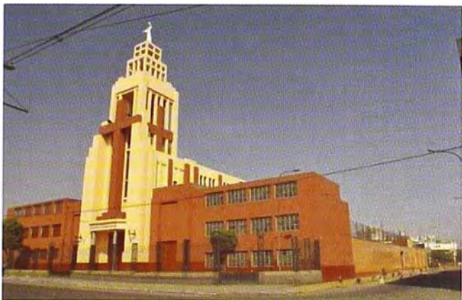
Foto 1. Fachada exterior de la iglesia Nuestra Señora de los Desamparados. 2012. Fuente: Archivos del Autor.
