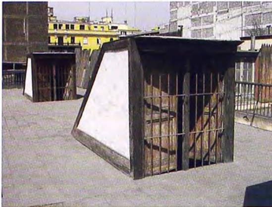
Foto2: Teatina de casona ubicada en el cruce de los jirones Camaná y Callao. Se aprecian sus proporciones y características típicas. Fuente: Archivos del Autor, 2007.
