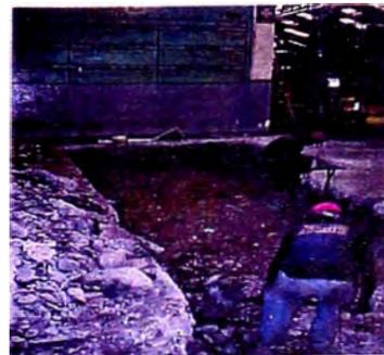
**FOTO 5.8 ROTURA PISO EXTRUSORA DUPLEX**
