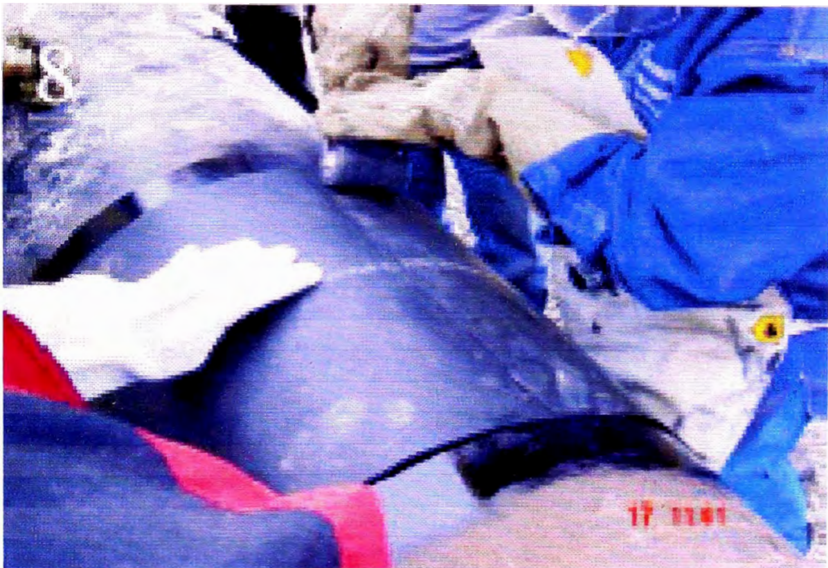
Foto 10 : Colocación de la mantas termocontraíbles después de la inspección
