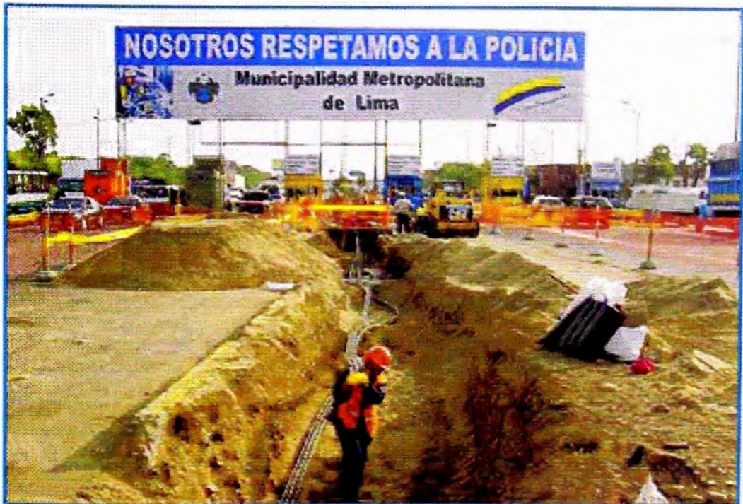
Foto 12 : Tendido de triductos en la Vía de evitamiento
