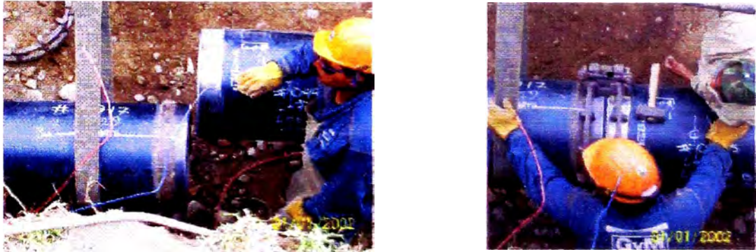
Figura 5.11: Alineamiento de tubería con grampa externa
