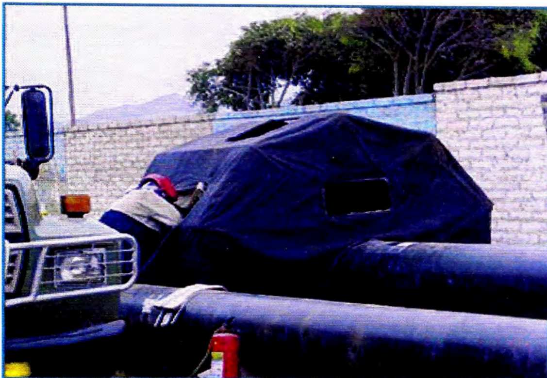
Foto 5 • Proceso de Soldadura en Lurín
