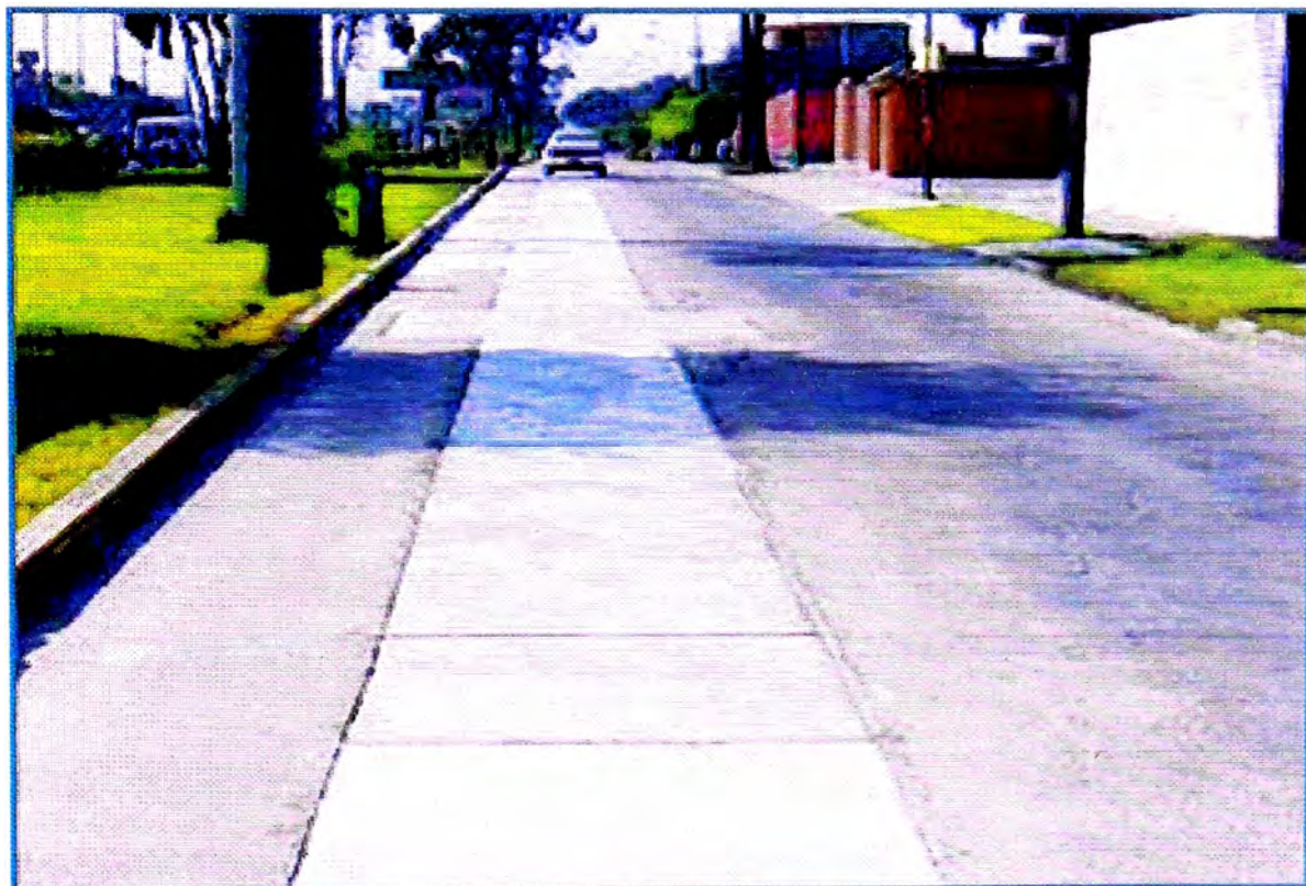
Foto 14 · Calle compactada en Surco.
