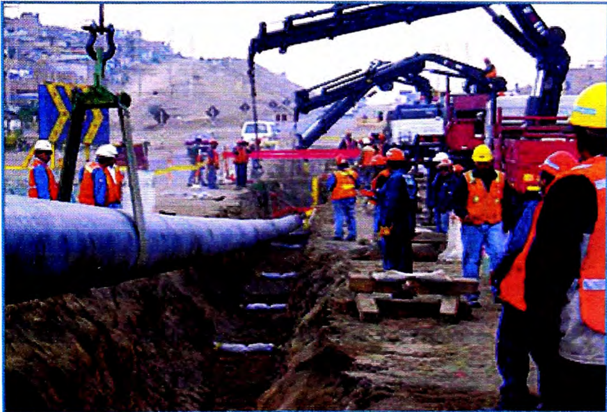
Foto 4: Bajada de tubería soldada en la zona del Ferrocarril
