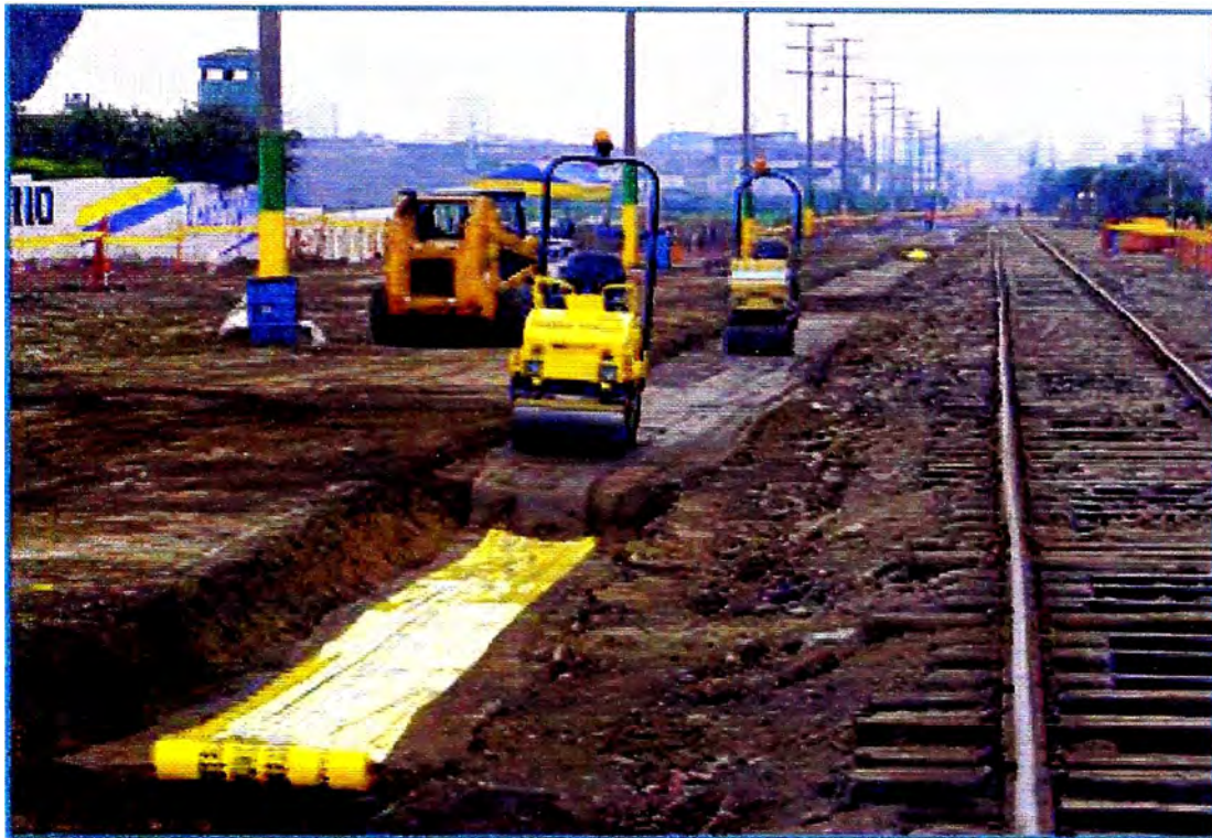
Foto 13 :Compactación cerca de la Línea del ferrocarril
