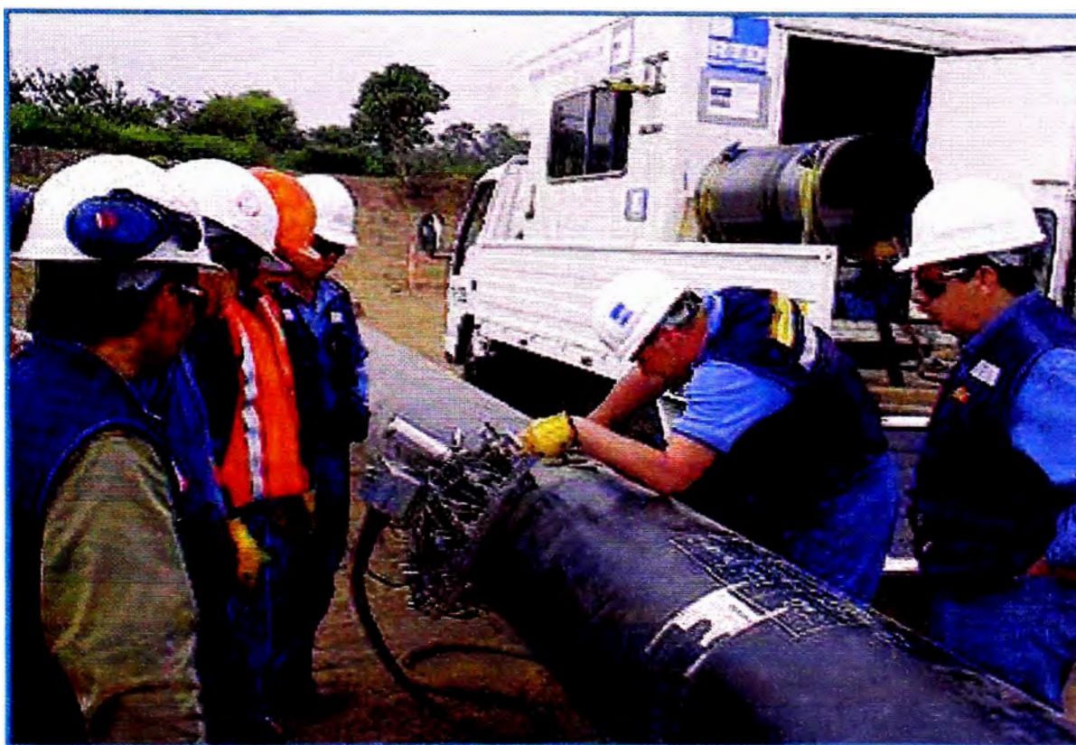
Foto 6 • Inspección de Soldadura con el Rotoscan en Lurín
