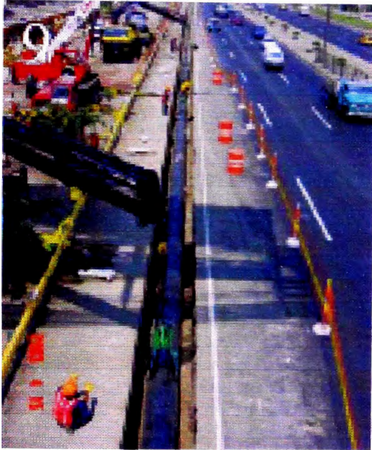
Foto 11: Bajado de tuberías en la Vía de evitamiento
