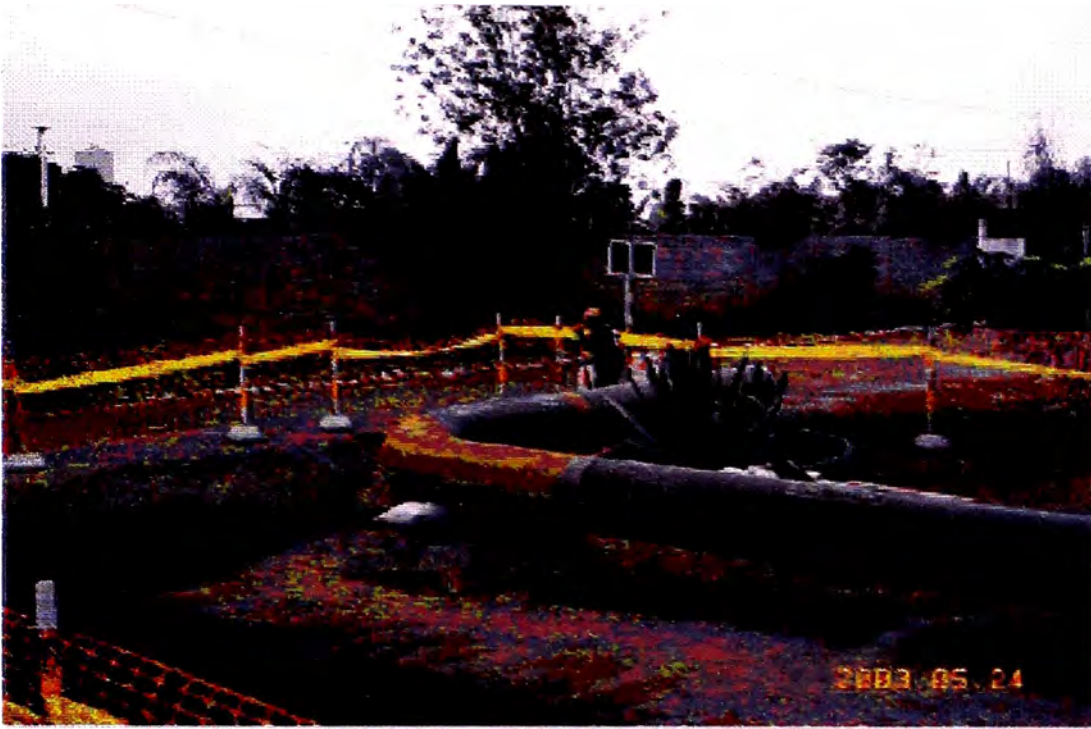
Sección de Tubería con codo a 90° de fábrica ,aun sin revestir ,en la intersección de las Av. Santa Cruz y Los Sauces, en Lurin / Pachacamac
