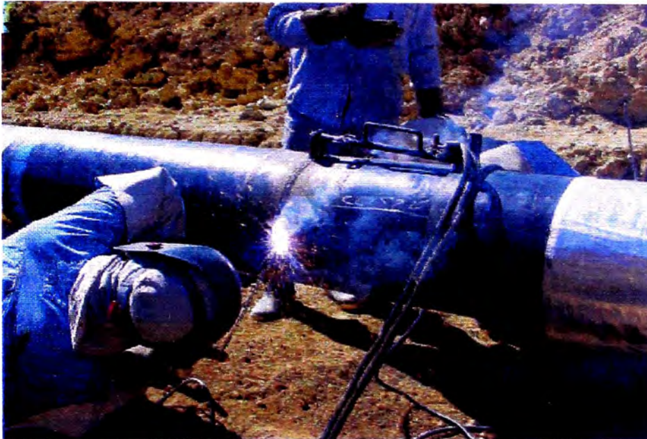
Figura 7.3: Soldadura de la tubería
