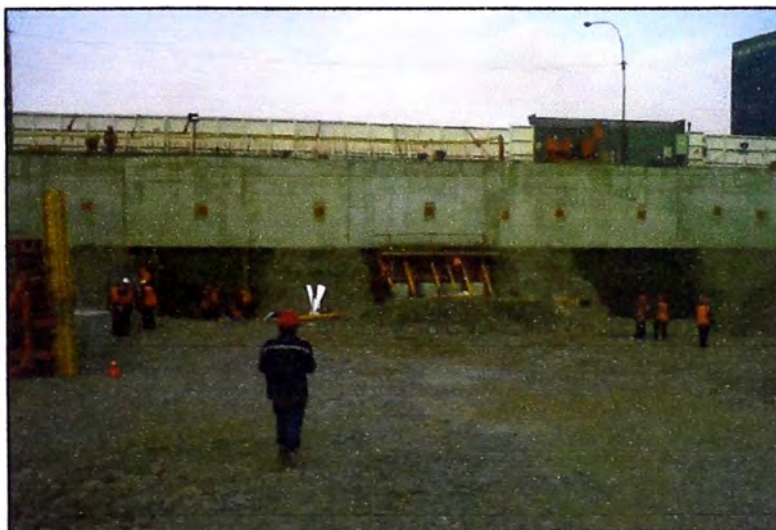
Figura N° 3.11: Fotografía de excavación intercalada del segundo nivel
