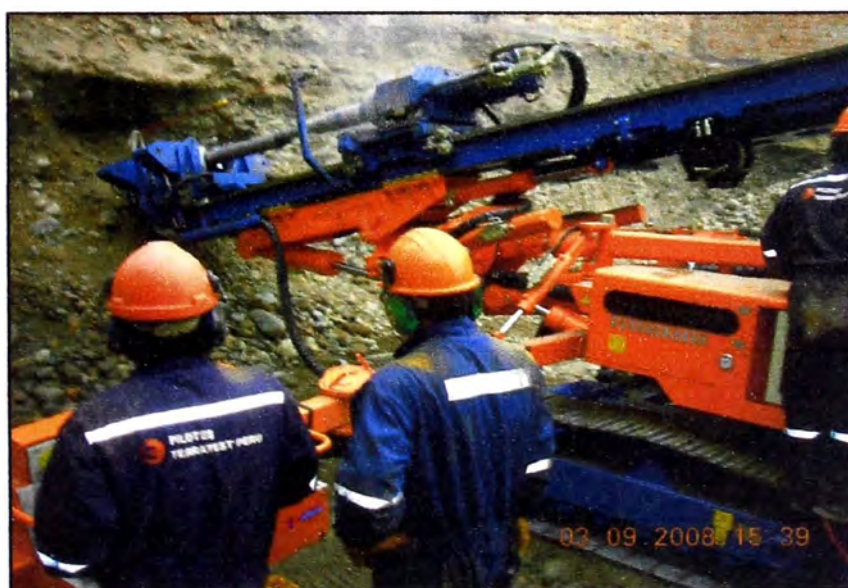
Figura N° 3.02: Fotografía de perforación para colocación del anclaje
