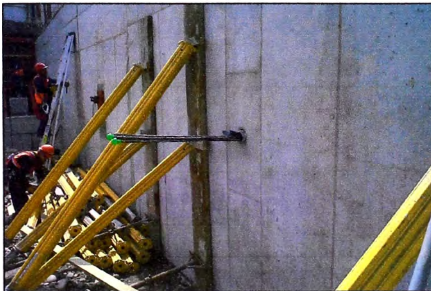
Figura N° 3.08: Fotografía de desencofrado del muro
