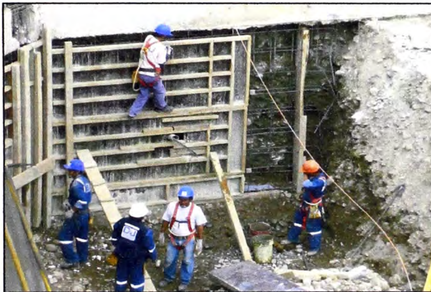
Figura N° 3.06: Fotografía de encofrado de los muros
