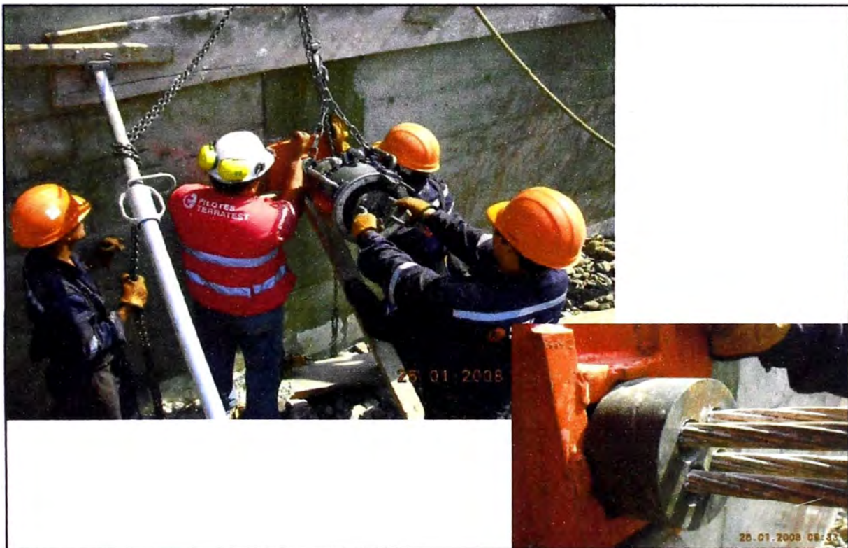
Figura N° 3.09: Fotografía de tensado del anclaje
