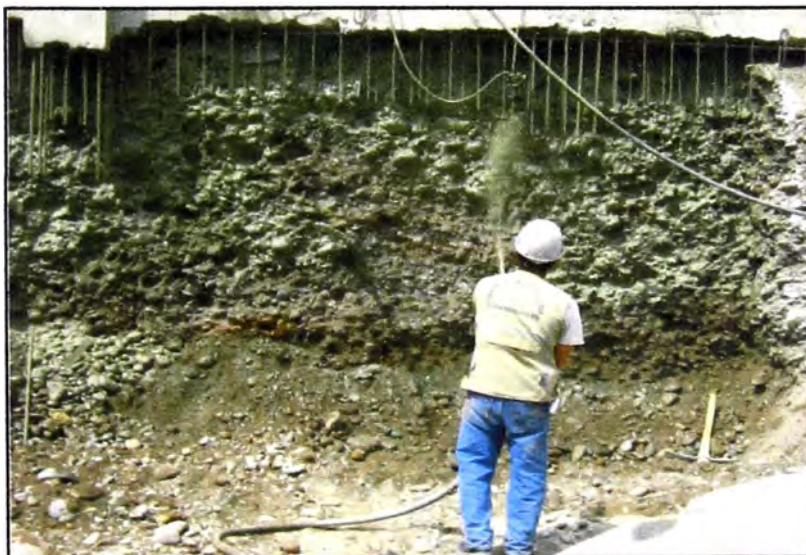
Figura N° 3.03: Fotografía del proceso de pañeteo con lechada de cemento
