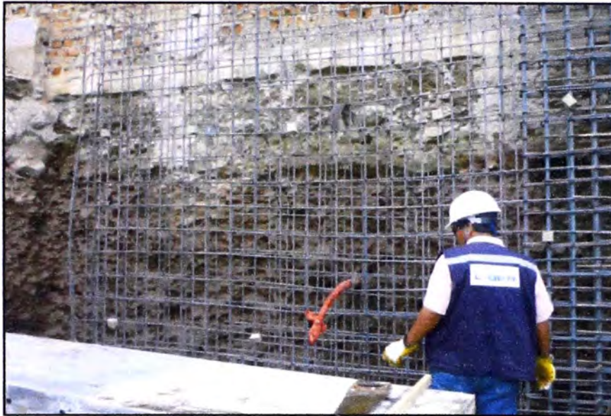
Figura N° 3.05: Fotografía de colocación de armadura de acero del muro
