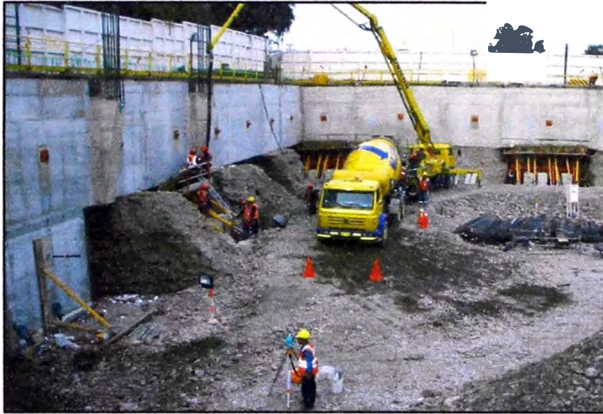
Figura N° 3.07: Fotografía de vaciado de concreto
