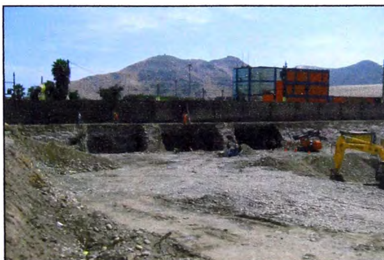
Figura N° 3.01: Fotografía de excavación del primer nivel con bermas de estabilización
