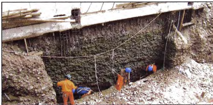
Figura 95 - Perfilado manual del terreno y excavación de zanja
