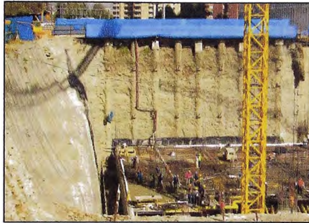
Figura 30 - Pilotes Anclados para excavaciones en edificaciones, Chile
