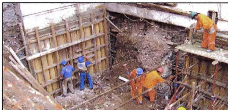
Figura 103 - Desencofrado del muro
