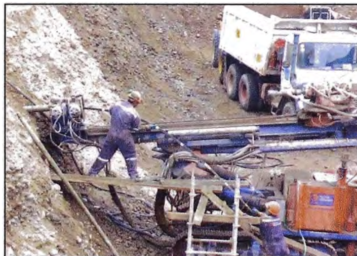
Figura 93 - Inserción del tensor o anclaje
