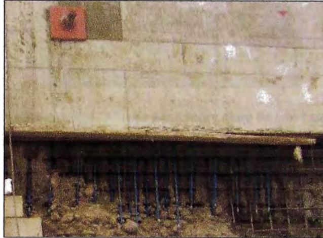
Figura 96 - Protección del acero con polietileno
