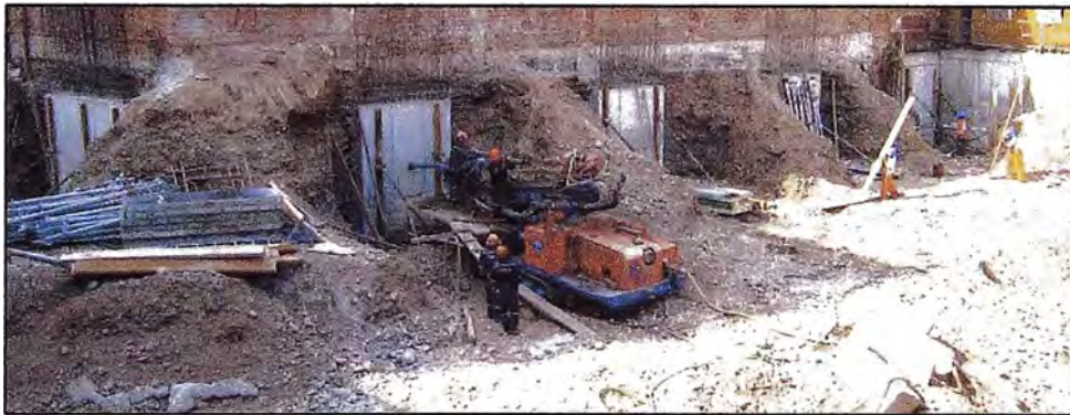
Figura 91 - Perforación sobre pase en muro armado
