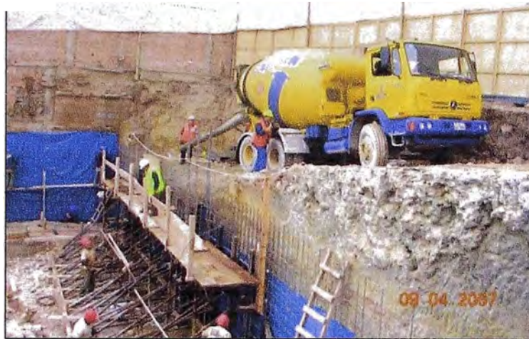
Figura 102 - Vaciado del muro
