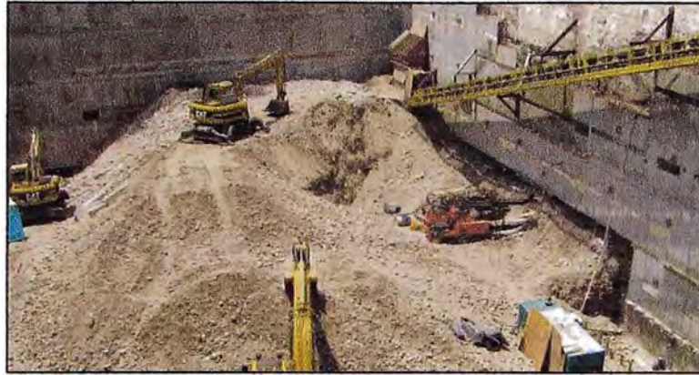
Figura 81 - Extracción del material mediante faja transportadora
