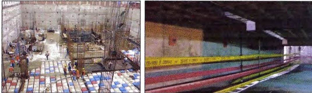
Figura 108 - Construcción de las losas de los sótanos del proyecto.
