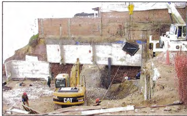
Figura 85 - Eliminación de material utilizando una retroexcavadora
