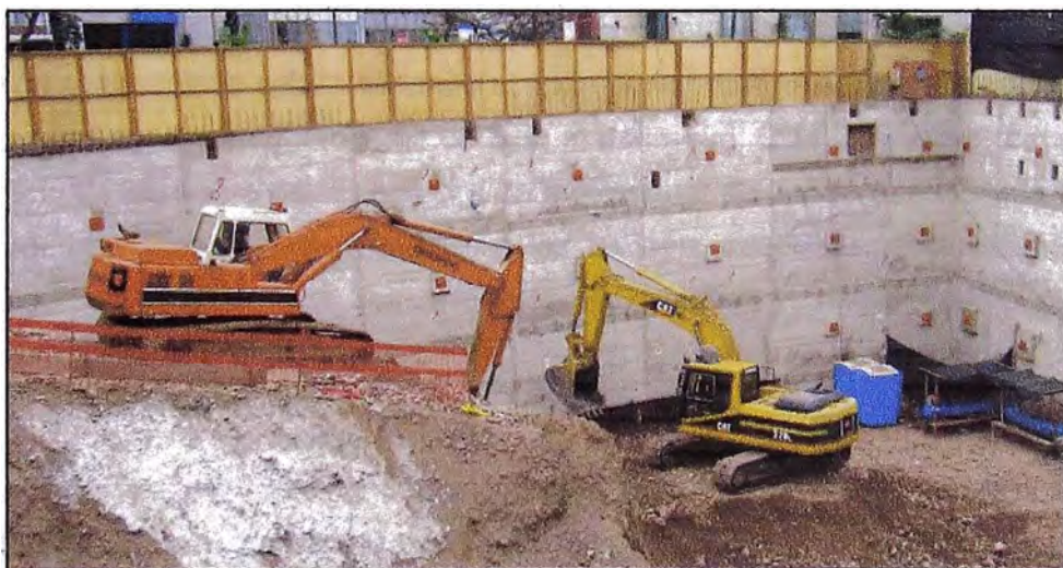
Figura 80 - Empleo de 2 excavadoras, sistema escalonado.
