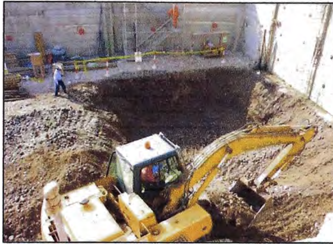
Figura 79 - Excavación del segundo nivel mediante excavadora de orugas
