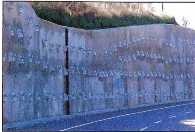
Figura 20 - Capuchón de protección para anclajes permanentes
