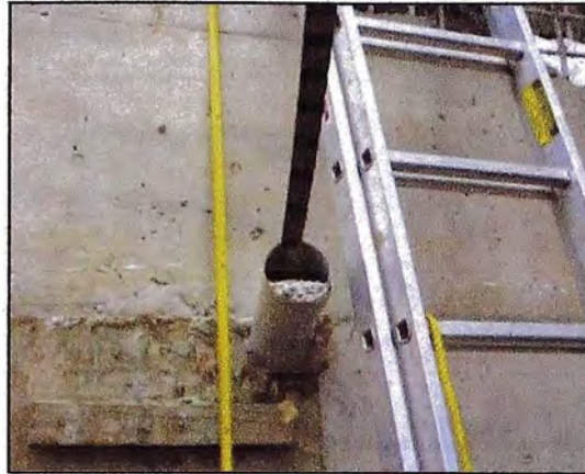
Figura 98 - Tubo de PVC 4" para pase sobre muro de concreto armado
