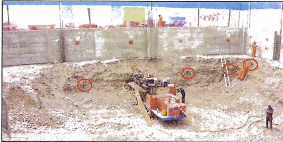
Figura 90 - Replanteo de punto de perforación sobre las banquetas
