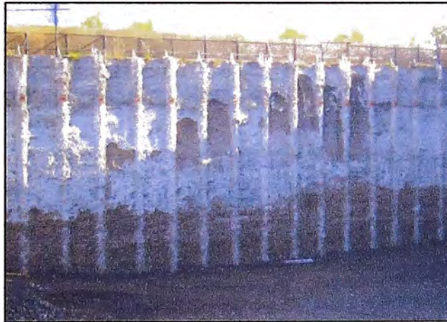
Figura 29 - Pilotes Anclados para excavaciones en edificaciones, Chile
