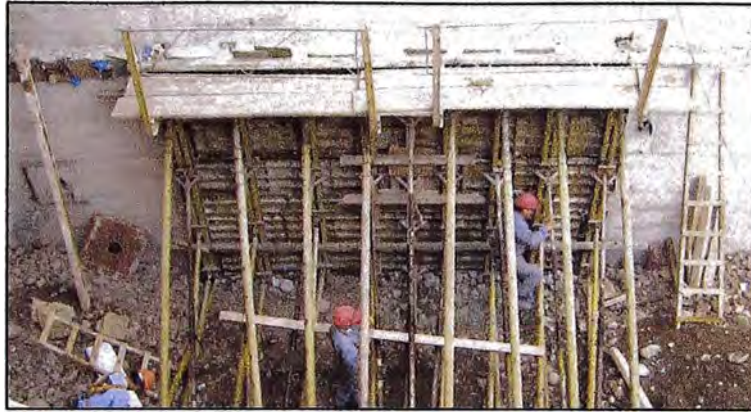
Figura 100 - Apuntalamiento contra terreno del encofrado
