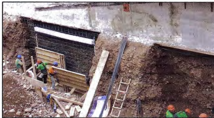
Figura 99 - Tecnoport para cajuelas en muro
