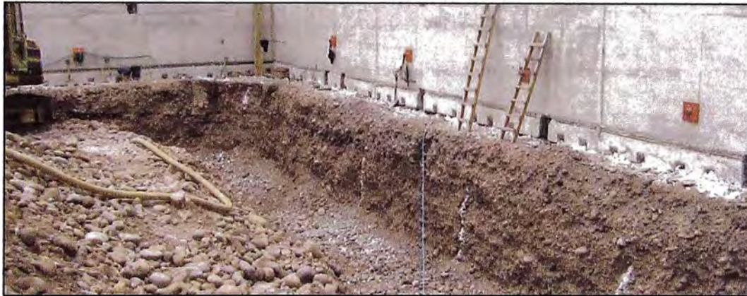
Figura 78 - Banquetas para soporte de muro anclado
