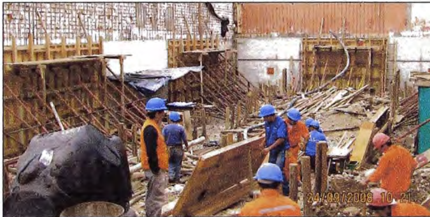
Figura 39 - Apuntalamiento de encofrado de madera
