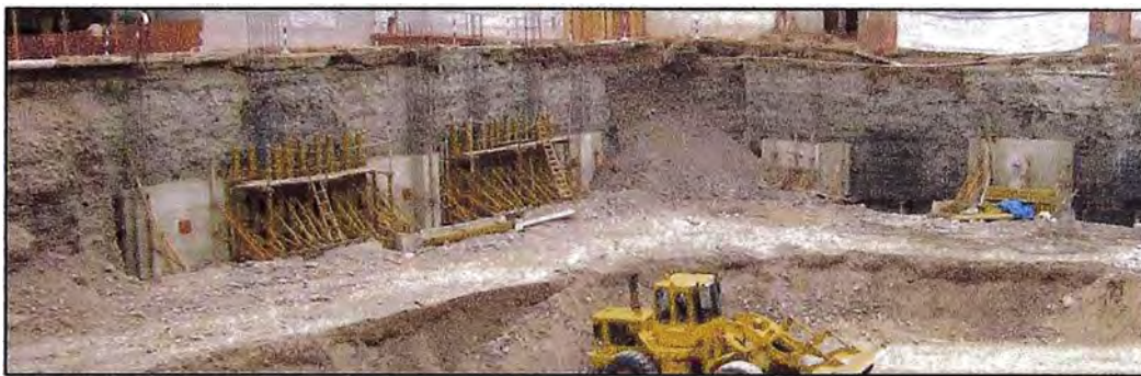
Figura 101 - Encofrado y apuntalamiento de muro alternado
