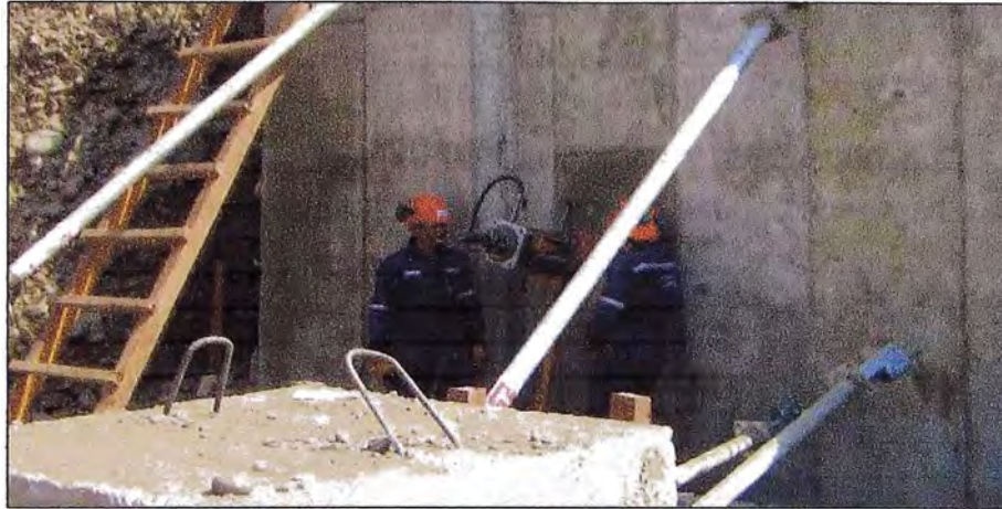
Figura 106 - Tensado del anclaje
