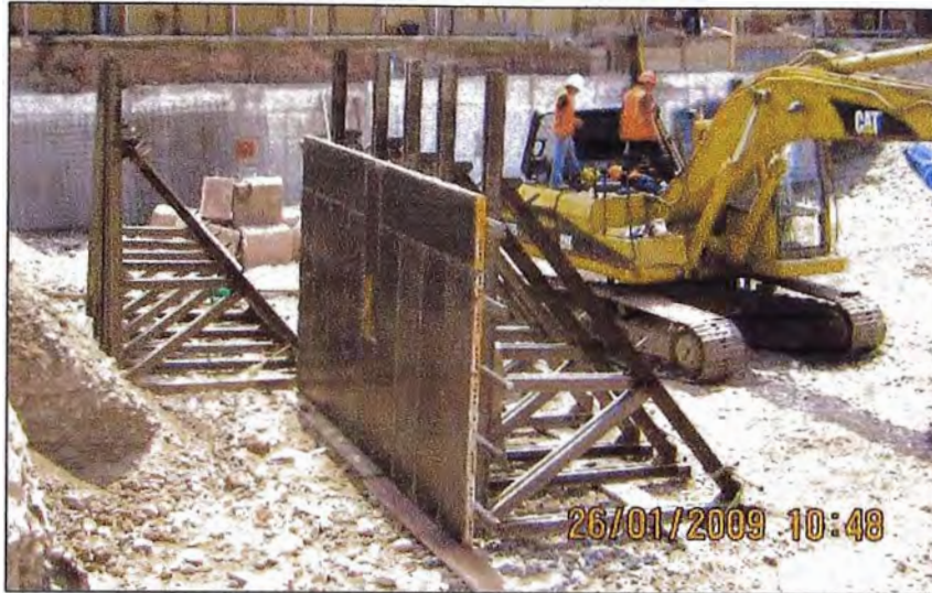
Figura 41 - Apuntalamiento de encofrado modular
