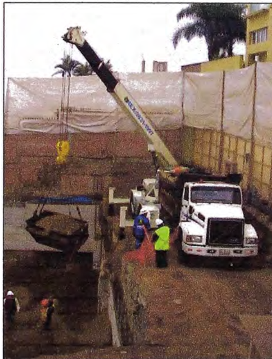
Figura 84 - Izaje de la bandeja de eliminación
