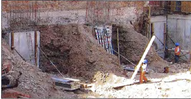
Figura 104 - Apuntalamiento del muro
