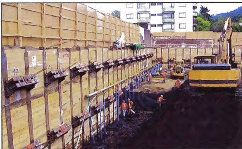
Figura 25 - Anclajes empleados sobre estructuras metálicas
