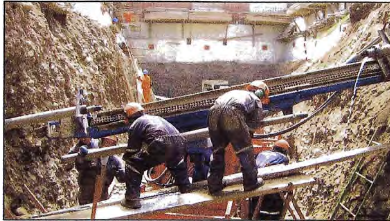
Figura 92 - Colocación de tuberías de perforación
