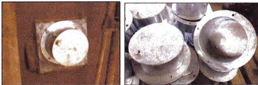
Figura 19 - Capuchón de protección para anclajes permanentes
