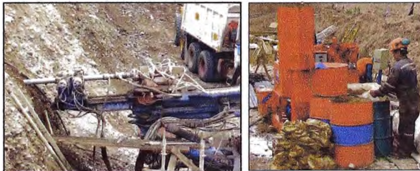
Figura 94 - Proceso de inyección del anclaje
