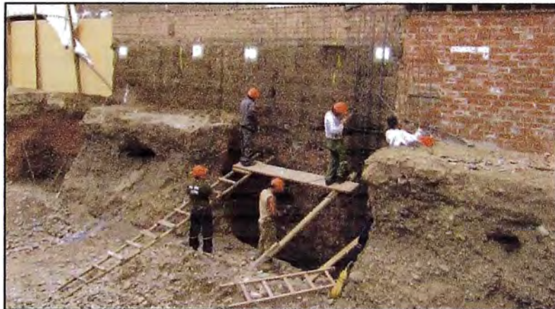
Figura 97 - Habilitación de acero de refuerzo
