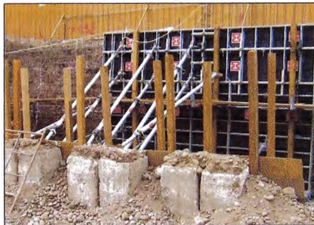
Figura 40 - Apuntalamiento de encofrado metálico
