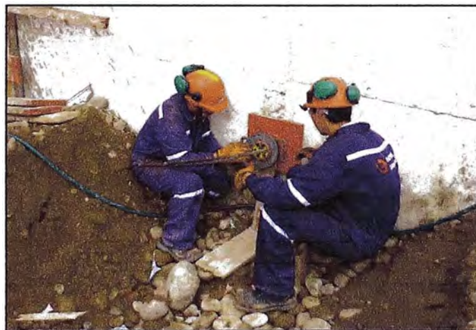
Figura 105 - Instalación de la placa y silla de apoyo para el tensado
