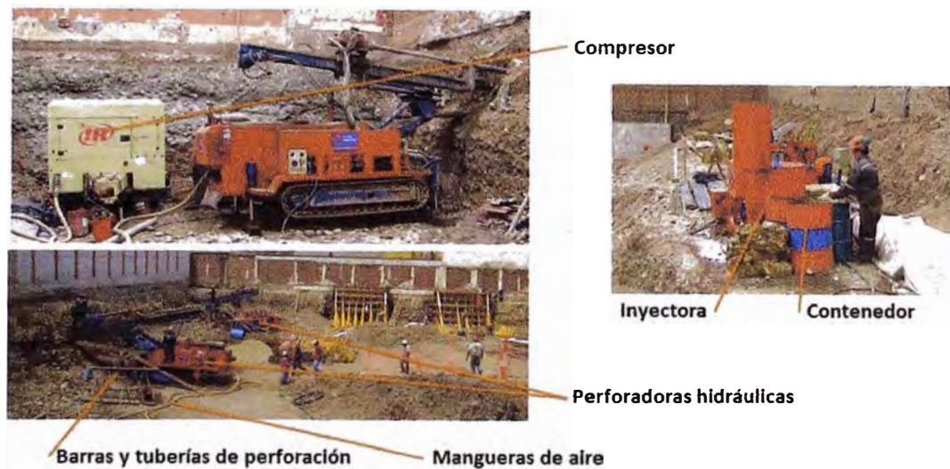
Figura 43 - Anclajes empleados sobre concreto armado
