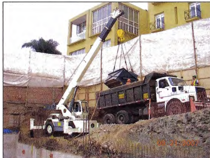
Figura 86 - Apertura de la bandeja en el interior de la tolva del volquete
