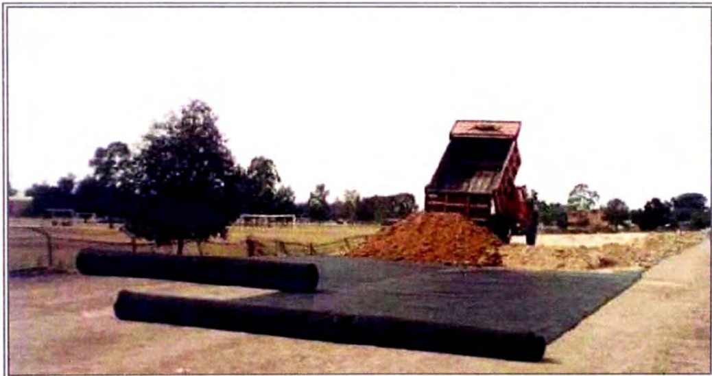
Figura N°1.8: Estabilización de suelo con Geotextil
