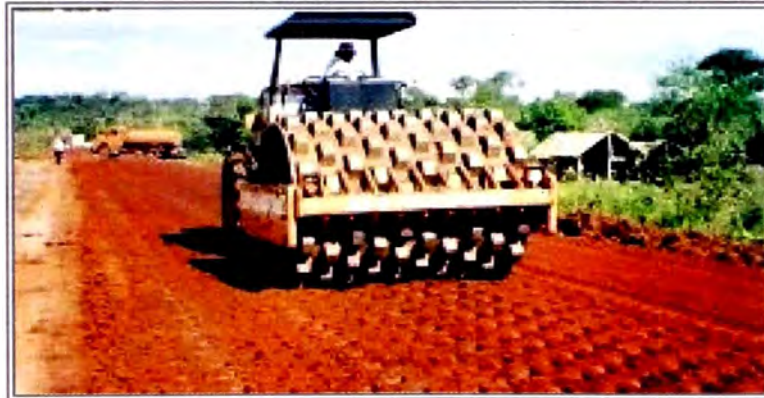
Figura N°1.4: Estabilización mecánica con rodillo Pata de Cabra
