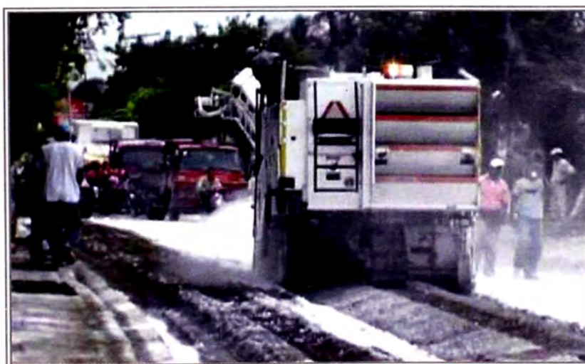
Figura N°1.6: Estabilización con cal
