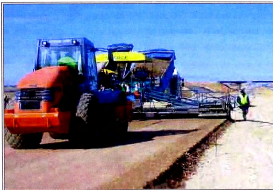
Figura N°1.7: Estabilización de suelo con cemento.
